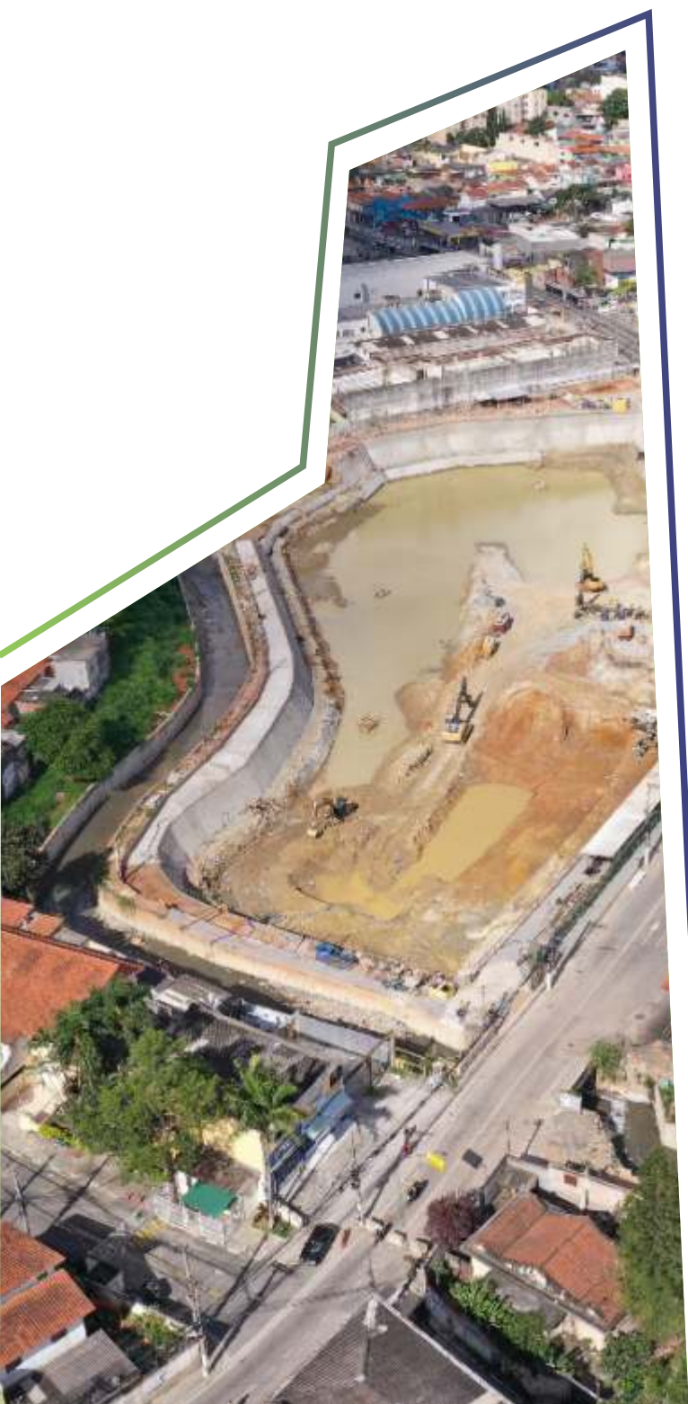
Piscinão do Capão Redondo em construção
