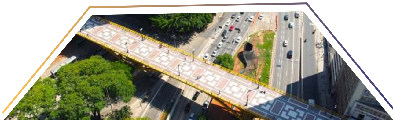
Detalhe da recuperação e restauro do Viaduto Santa Ifigênia
