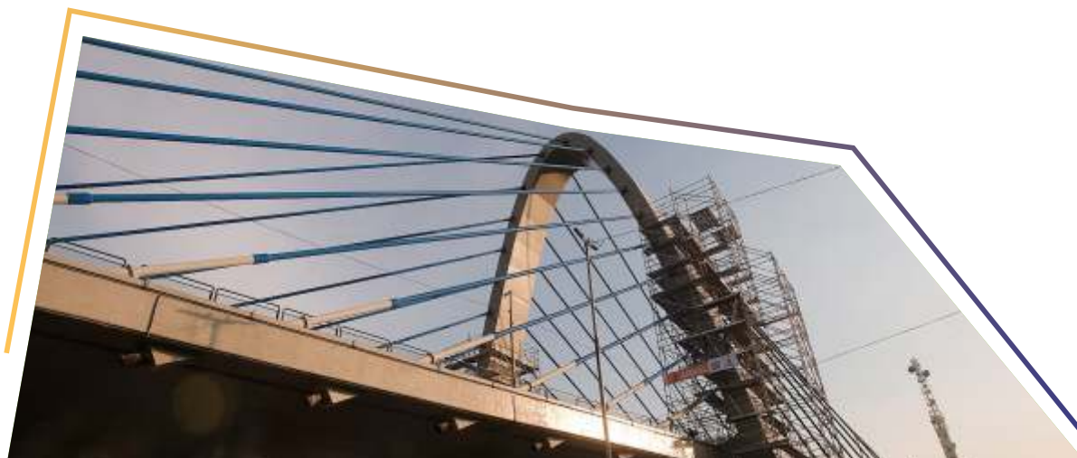
Detalhe do Programa de Recuperação de Pontes e Viadutos
