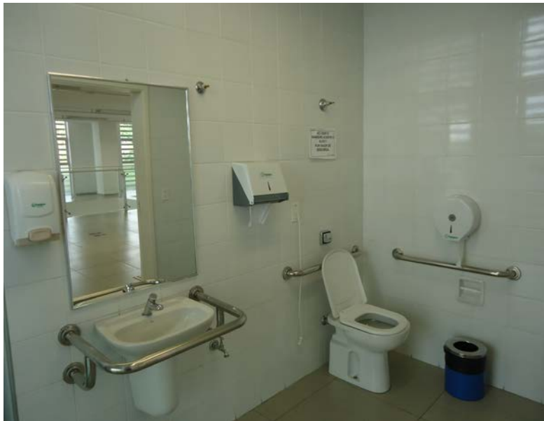
Figura 9 - Banheiro adaptado da Biblioteca Prestes Maia
