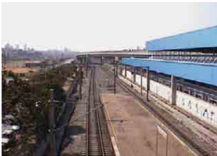
Foto de 1998 indicando, à direita, a Estação de Metrô Penha e, à esquerda, a antiga Estação Carlos de Campos. Ao fundo, o Viaduto Engenheiro Alberto Badra.
