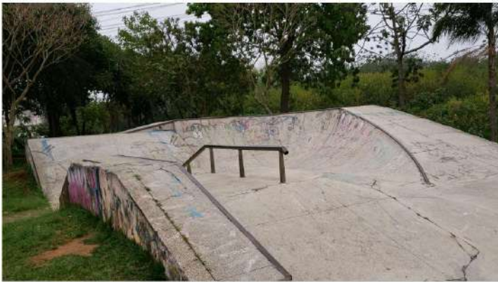
Praça Miguel Arrojado Lisboa – SUB JT
