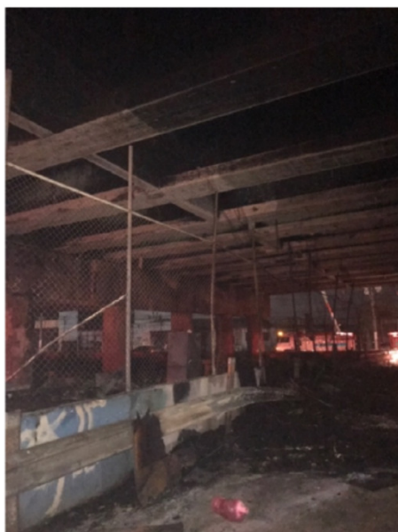
Fotos Viaduto Alcântara Machado:
