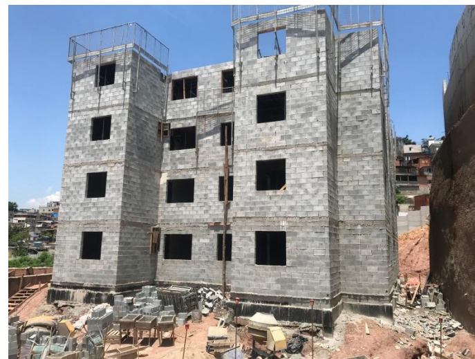
Cond. 6ª - Alvenaria do 4º pavimento
