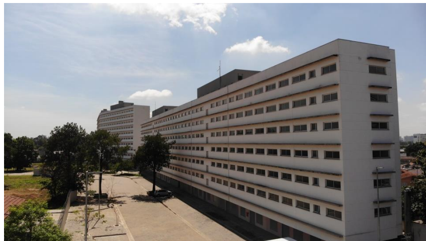
Vista Panorâmica – Torre F1 e Torre F2
