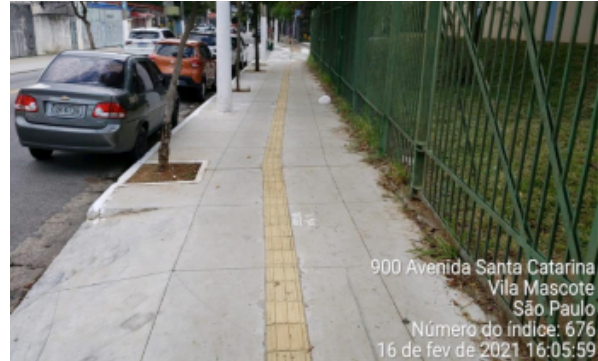
Requalificação de calçadas: Av. Santa Catarina
