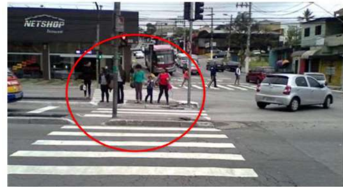
Foto 6- Local com canteiro estreito, conversão à esquerda e travessia em 2 estágios
