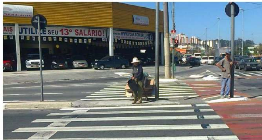
Canteiro Central muito estreito para acomodar pedestres
