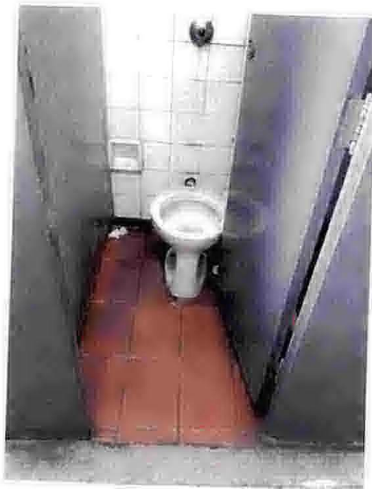
Foto 54 – Sanitário feminino – Cabine 02.
