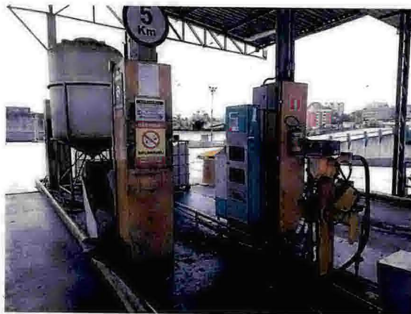
Foto 254 – Área de abastecimento.
