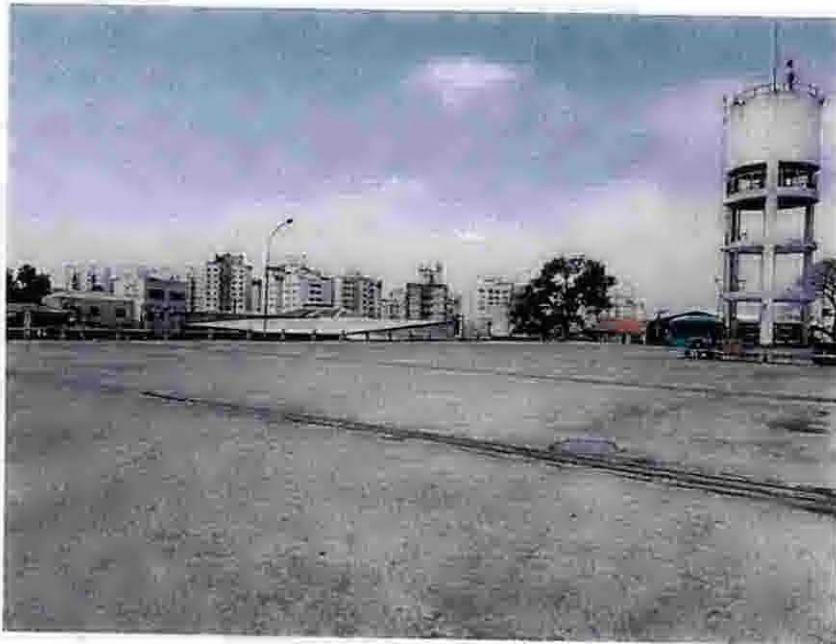
Foto 239 – Pátio elevado: apresenta problemas no pavimento.
