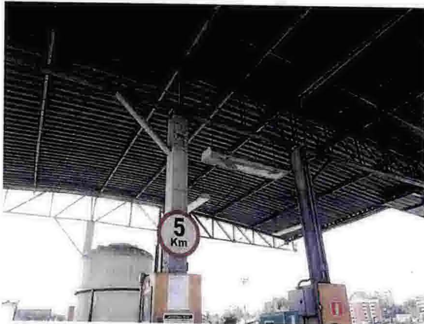
Foto 255 – Área de abastecimento – Estrutura de cobertura.
