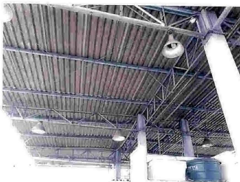
Foto 268 – Área de lavagem de veículos – Estrutura de cobertura.
