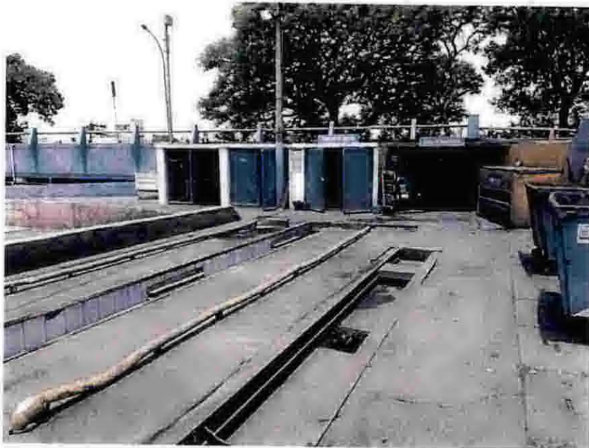
Foto 257 – Área de lavagem de chassi.
