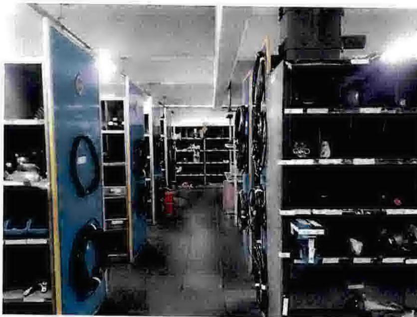
Fotos 310 – Almoxarifado: apresenta problemas na pintura.
