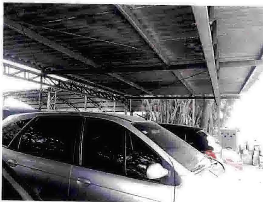
Foto 227 – Pátio – Estacionamento coberto.
