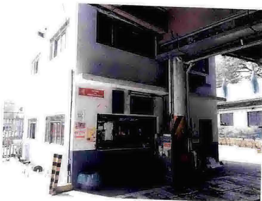
Foto 14 – Fachada do Prédio do plantão e CCO.
