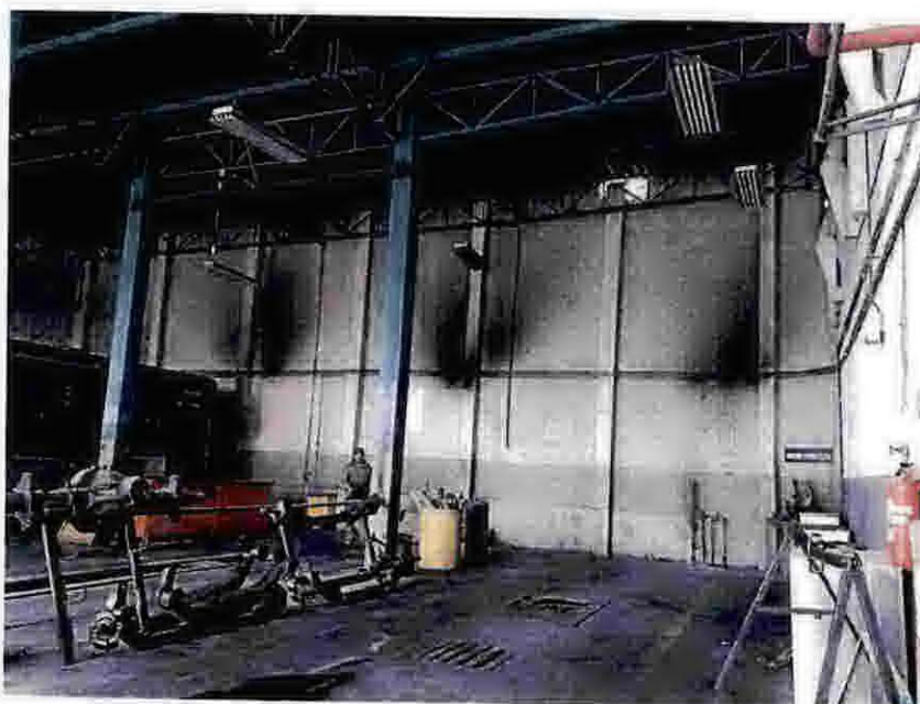
Fotos 332 – Área de Manutenção de AC e Motores: apresenta problemas na pintura.
