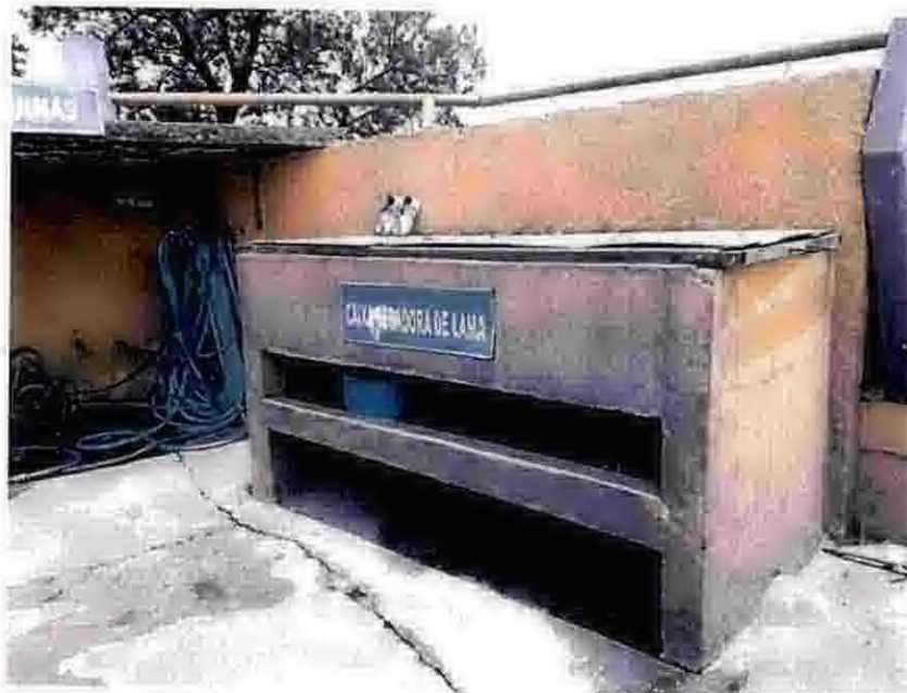
Foto 258 – Área de lavagem de chassi.
