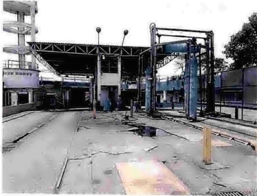
Foto 263 – Área de lavagem de veículos.
