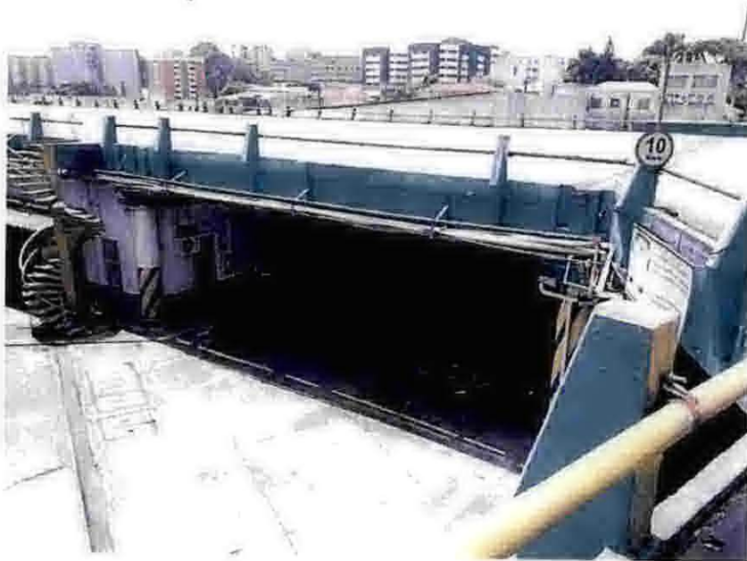
Foto 246 – Pátio elevado e escada de acesso.
