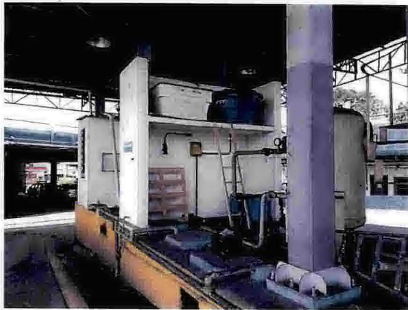
Foto 269 – Área de lavagem de veículos.
