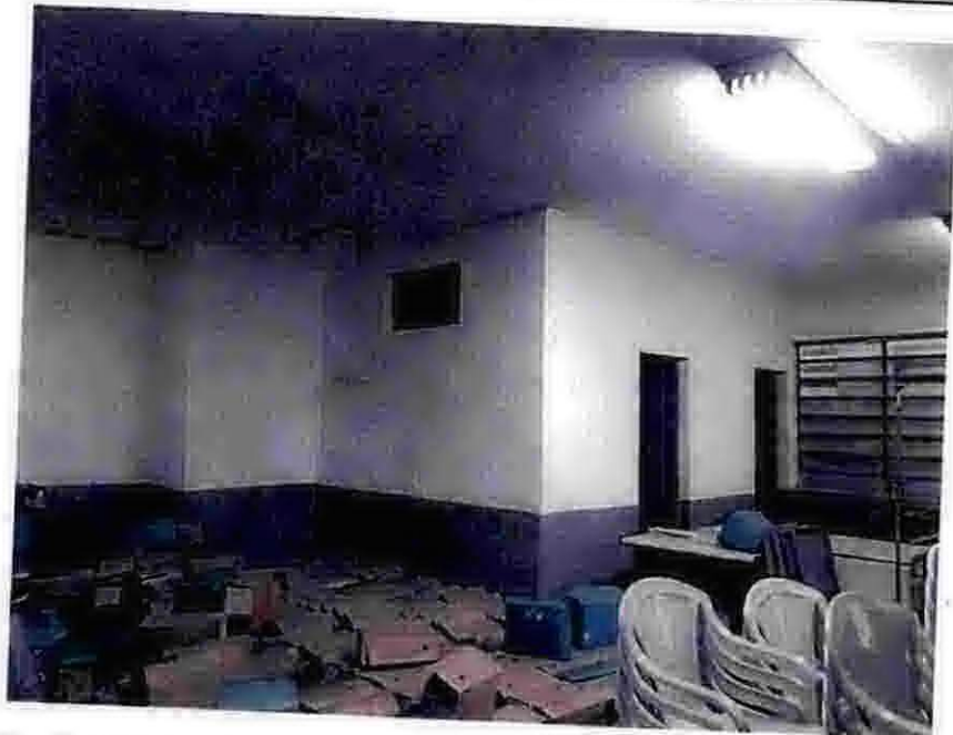
Foto 83 – Sala de eventos.
