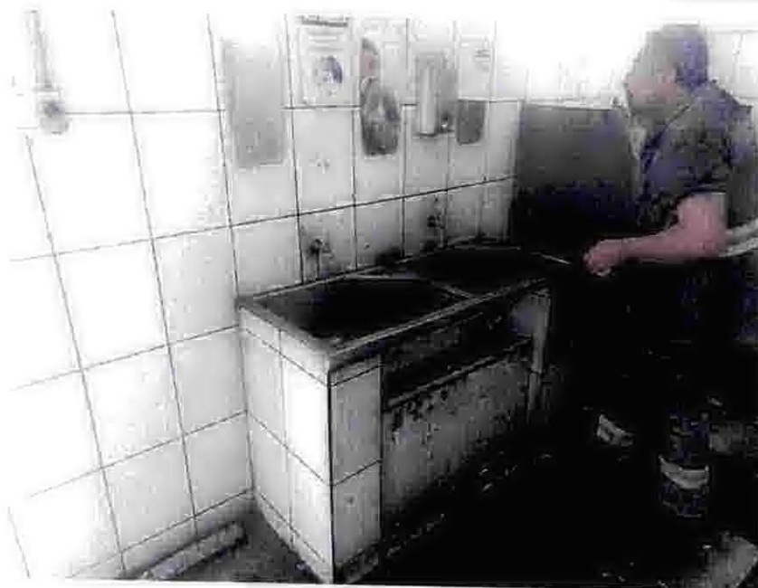
Fotos 349 – Sanitário da Oficina.
