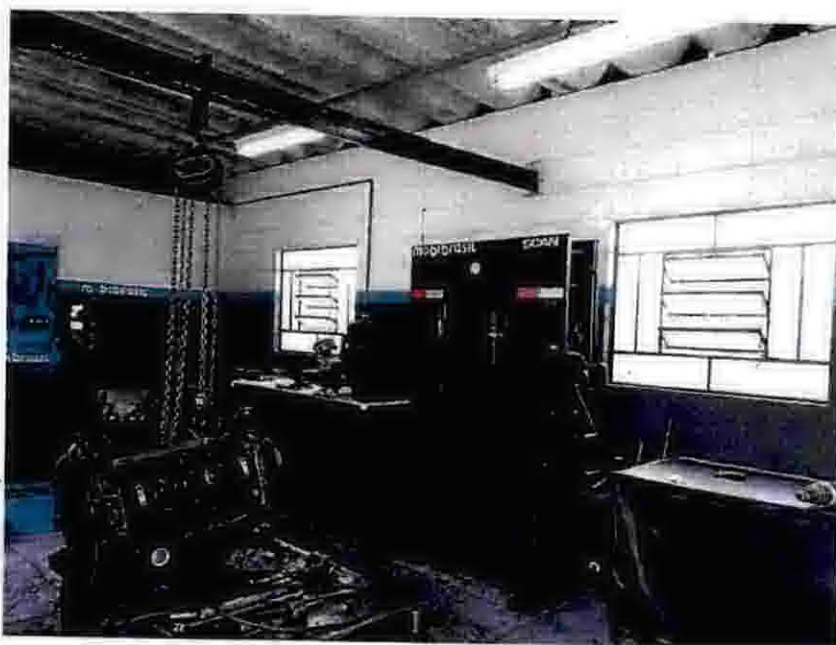
Fotos 338 – Área de Montagem de Câmbio: apresenta problemas na pintura.
