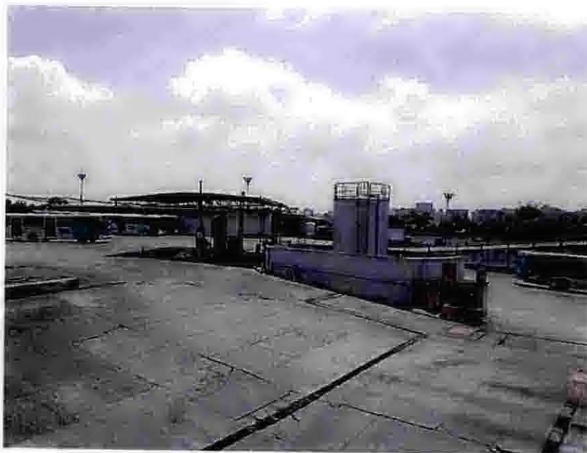
Foto 249 – Área de abastecimento.
