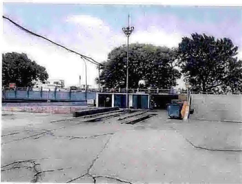
Foto 256 – Área de lavagem de chassi.
