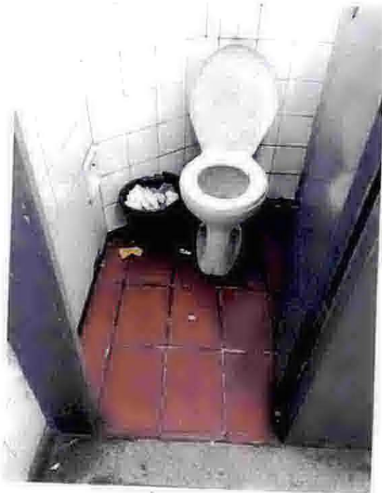
Foto 52 – Sanitário feminino - Cabine 01.
