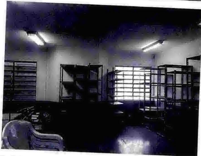
Foto 85 – Sala de eventos.
