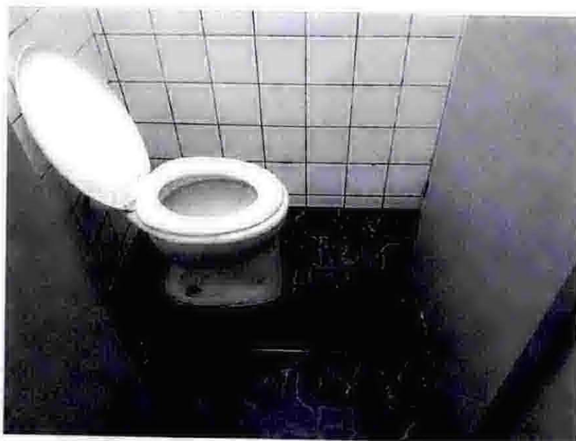
Fotos 320 – Sanitário anexo ao Controle de manutenção.
