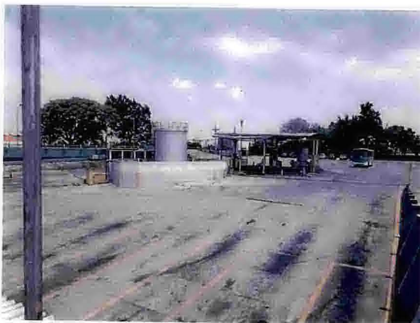
Foto 250 – Área de abastecimento.
