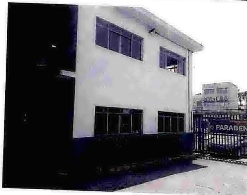
Foto 23 – Fachada do Prédio do plantão e CCO.
