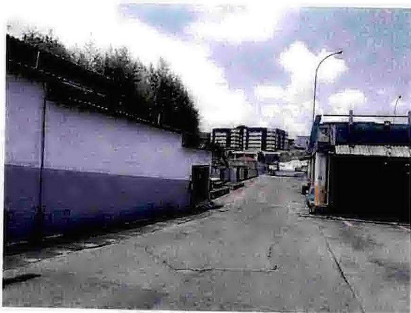
Fotos 297 – Depósito de Pneus: apresenta problemas na pintura.
