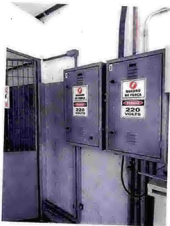
Foto 41 – Sala dos quadros de energia: apresenta furo na alvenaria e há um cabo passado com o auxílio de "enforcagato".
