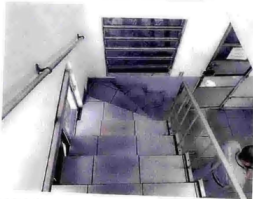
Fotos 21 e 22 – Vista interna do Prédio do plantão e CCO – Escada de acesso a piso superior.
