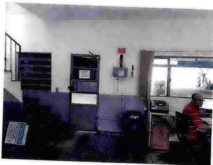
Foto 18 – Vista interna do Prédio do plantão e CCO: apresenta desgaste no piso.
