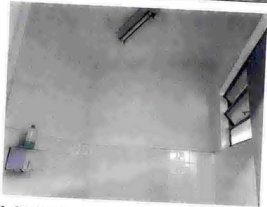
Foto 89 – Sala de eventos – Sanitário feminino anexo.
