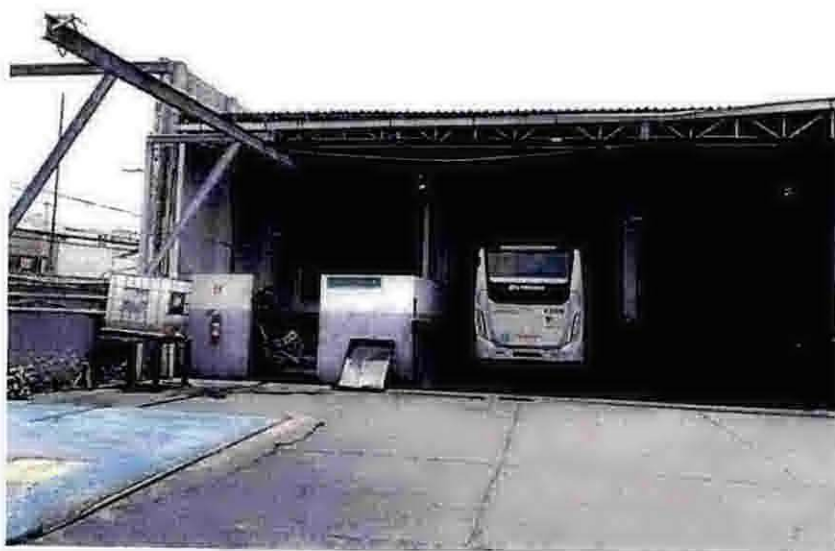
Fotos 330 – Área de Manutenção de AC e Motores.
