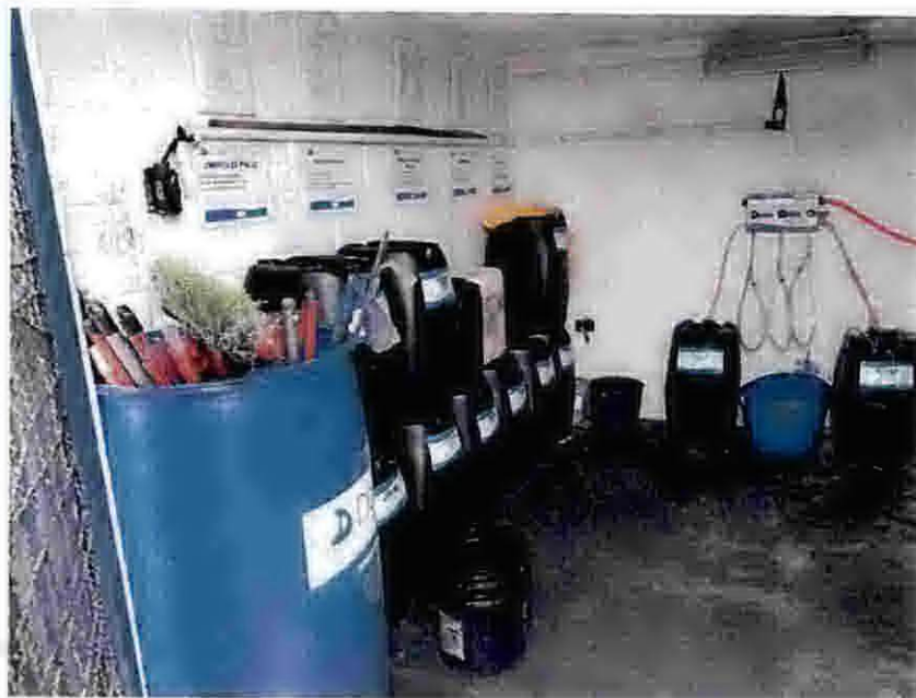
Foto 261 – Área de lavagem de chassi – Depósito de produtos de limpeza.
