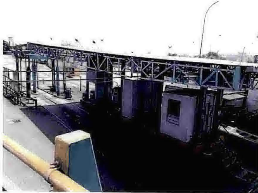
Foto 264 – Área de lavagem de veículos.
