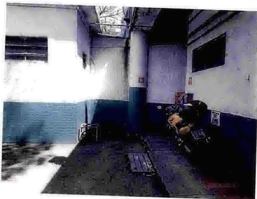
Foto 36 – Área próxima a cabine primária: em utilização como estacionamento.
