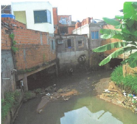
Foto 1 – Notar construções sobre o córrego e assoreamento por sedimentos e lixo
