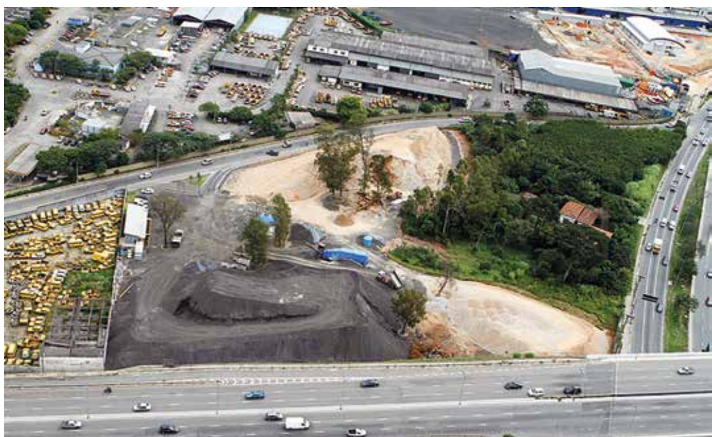
Depósito de materiais utilizados para a produção de massa asfáltica
