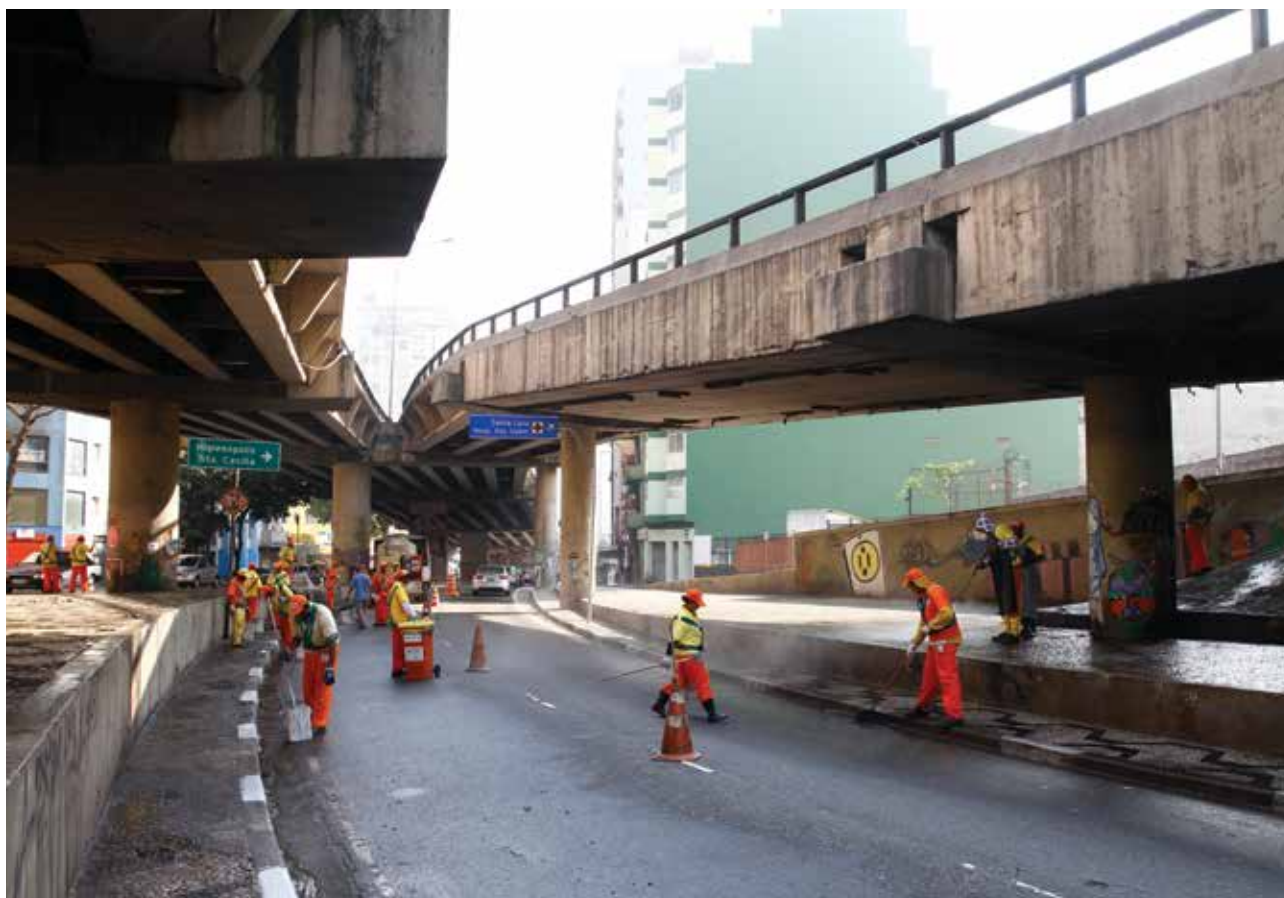
Acima e na outra página: equipe da Zeladoria da Prefeitura faz ação de limpeza e pintura no Elevado Presidente Costa e Silva (Minhocão), jardinagem na Praça Santos Drummond e na Av. Prof. Fonseca Rodrigues (Parque Villa-Lobos) e construção de calçadas na Zona Norte da cidade.
