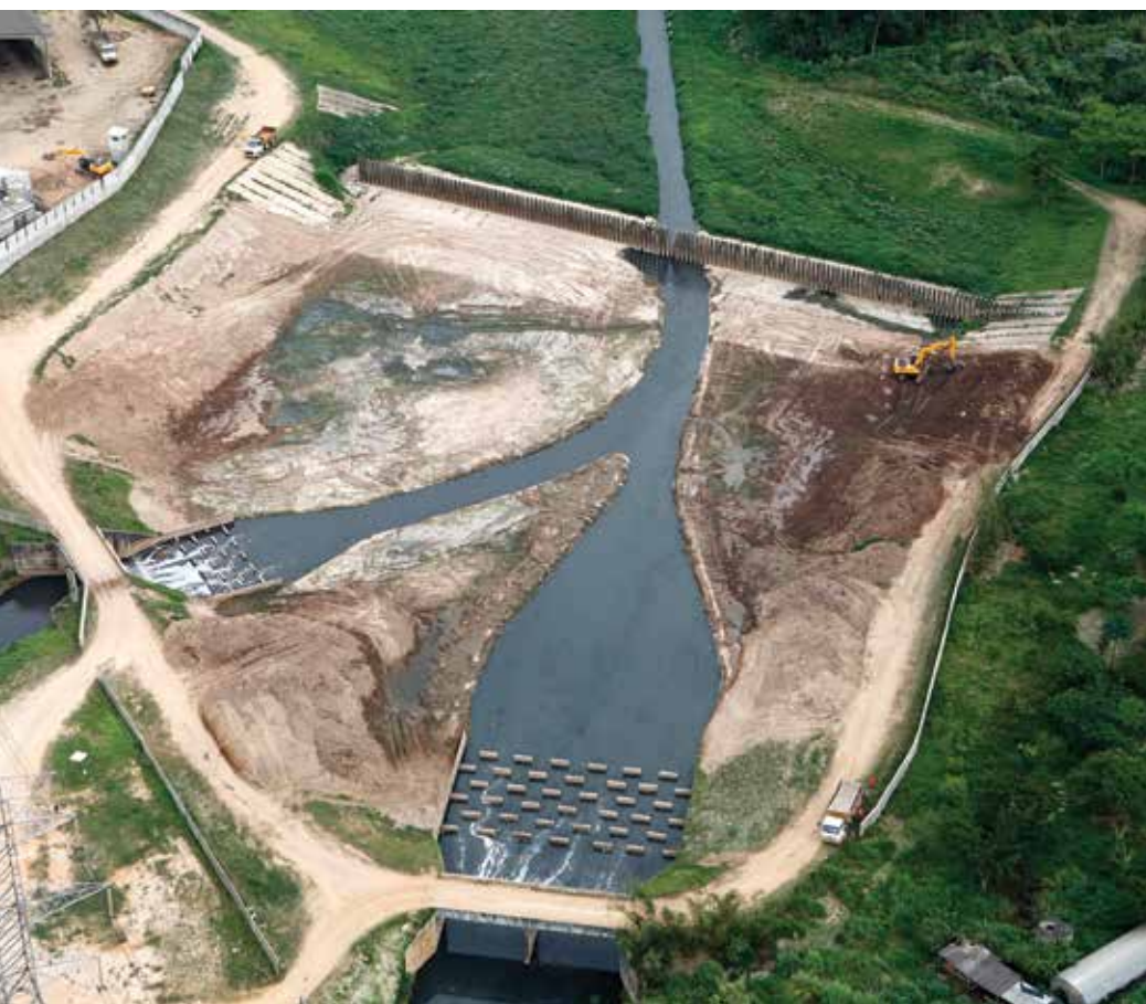
Até novembro de 2012, a limpeza dos piscinões de São Paulo, como o de Aricanduva, na Zona Leste (acima), removeu 268.547 m 3 de detritos com o uso de equipamentos de pequeno e grande porte.
