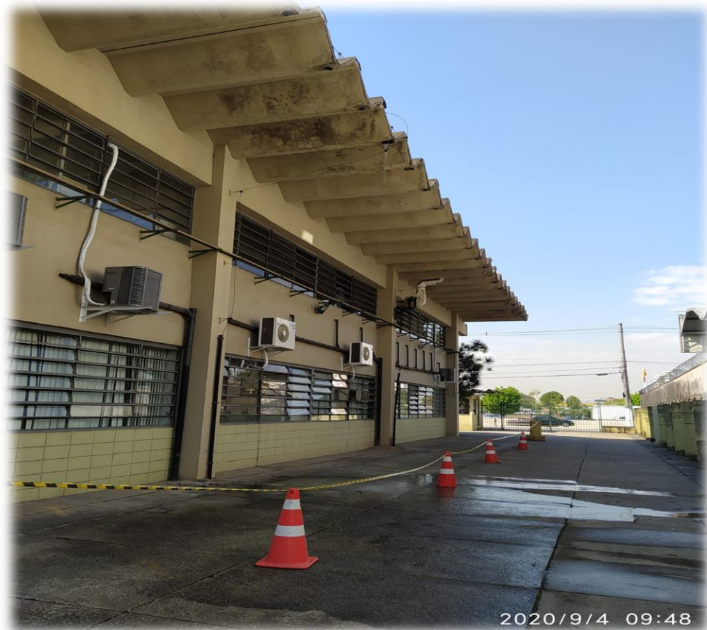
Reforma iniciada pela lavagem e aplicação de manta impermeabilizante no telhado
