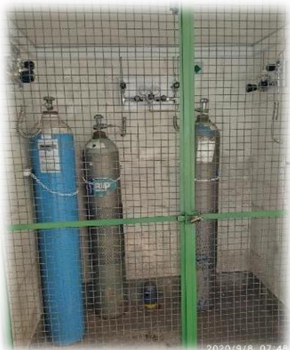
Cilindros de gases: 04 cilindros para armazenamento de Nitrogênio; 03 cilindros para armazenamento de Ar Sintético; 02 cilindros para armazenamento de Hidrogênio; 02 cilindros para armazenamento de Acetileno seção técnica de Aditivos e Micotoxinas
