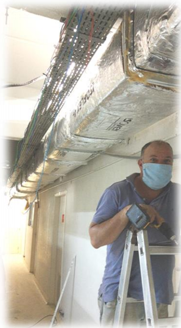
Instalação de ducto do ar condicionado central
