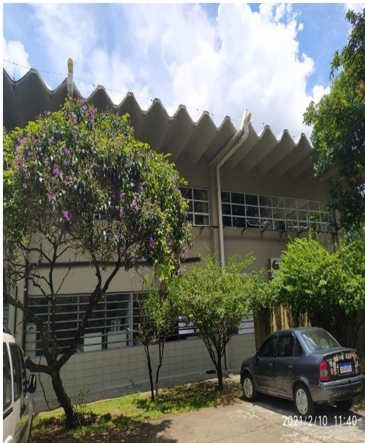
Pintura externa do prédio e impermeabilização do telhado, instalação de janelas
