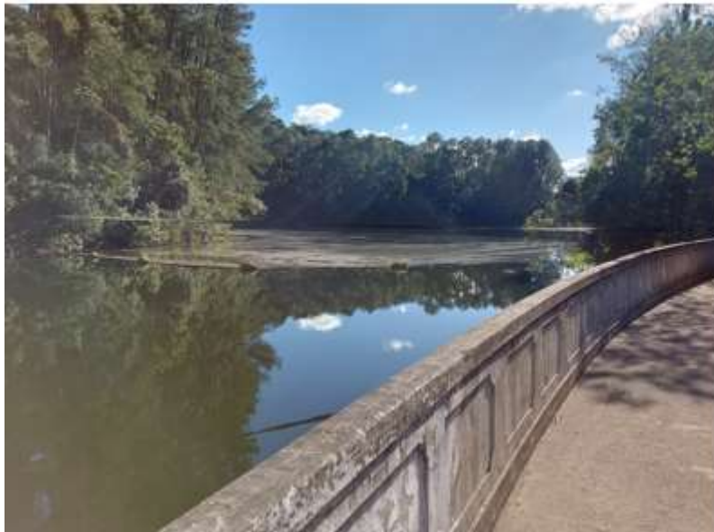
Barragem do Cabuçu (Guarulhos – SP)
