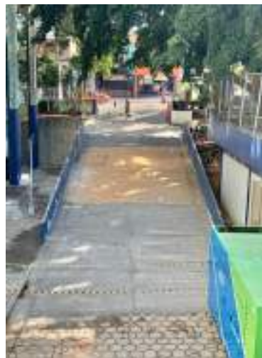
Reforma da Rampa de Acesso
