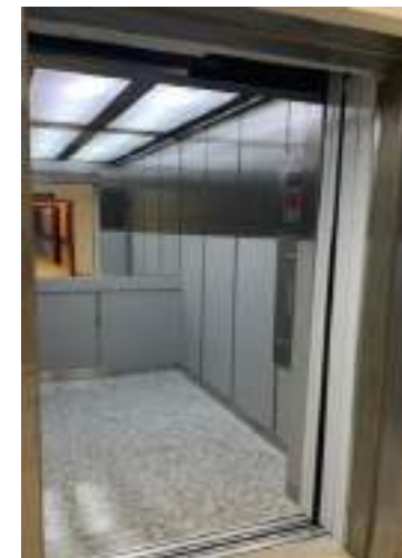
Reforma dos Elevadores
