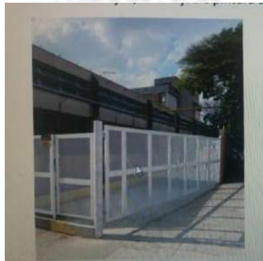
Confecção, Instalação e Pintura de Portão
