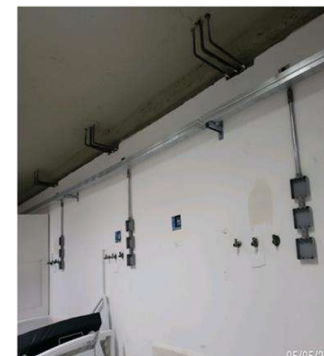
Readequação e Instalação de Estrutura Elétrica
