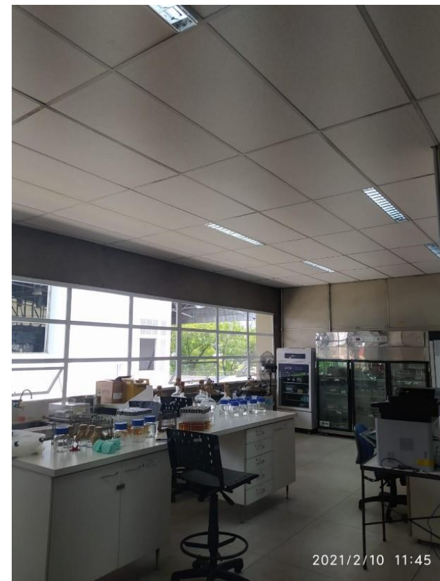
Reforma de laboratório – seção microbiologia (reforma elétrica, instalação de forros e luminárias, janelas instaladas aguardando acabamento)
