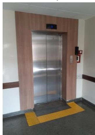
Substituição Elevador HM V José Storopoli
