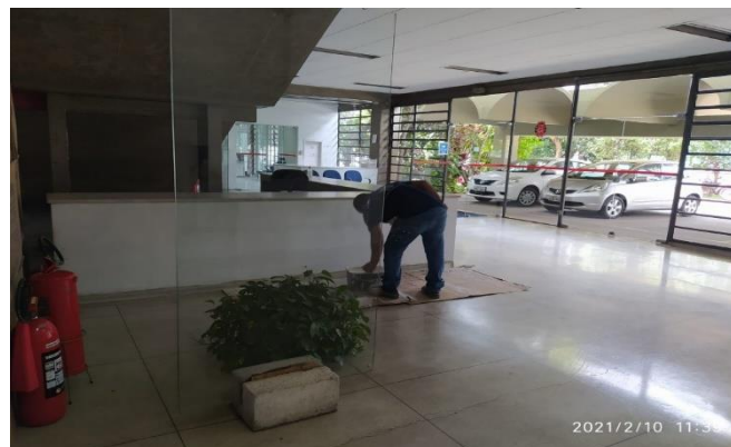
Pintura Interna – prédio central
