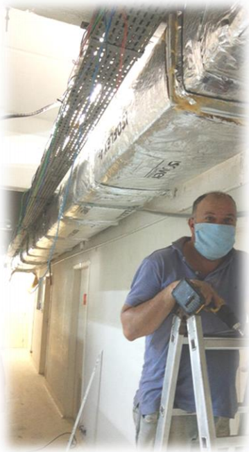
Instalação de ducto do ar condicionado central
