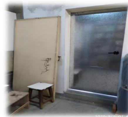
Substituição e instalação de Portas corta-fogo no Almojarifado
