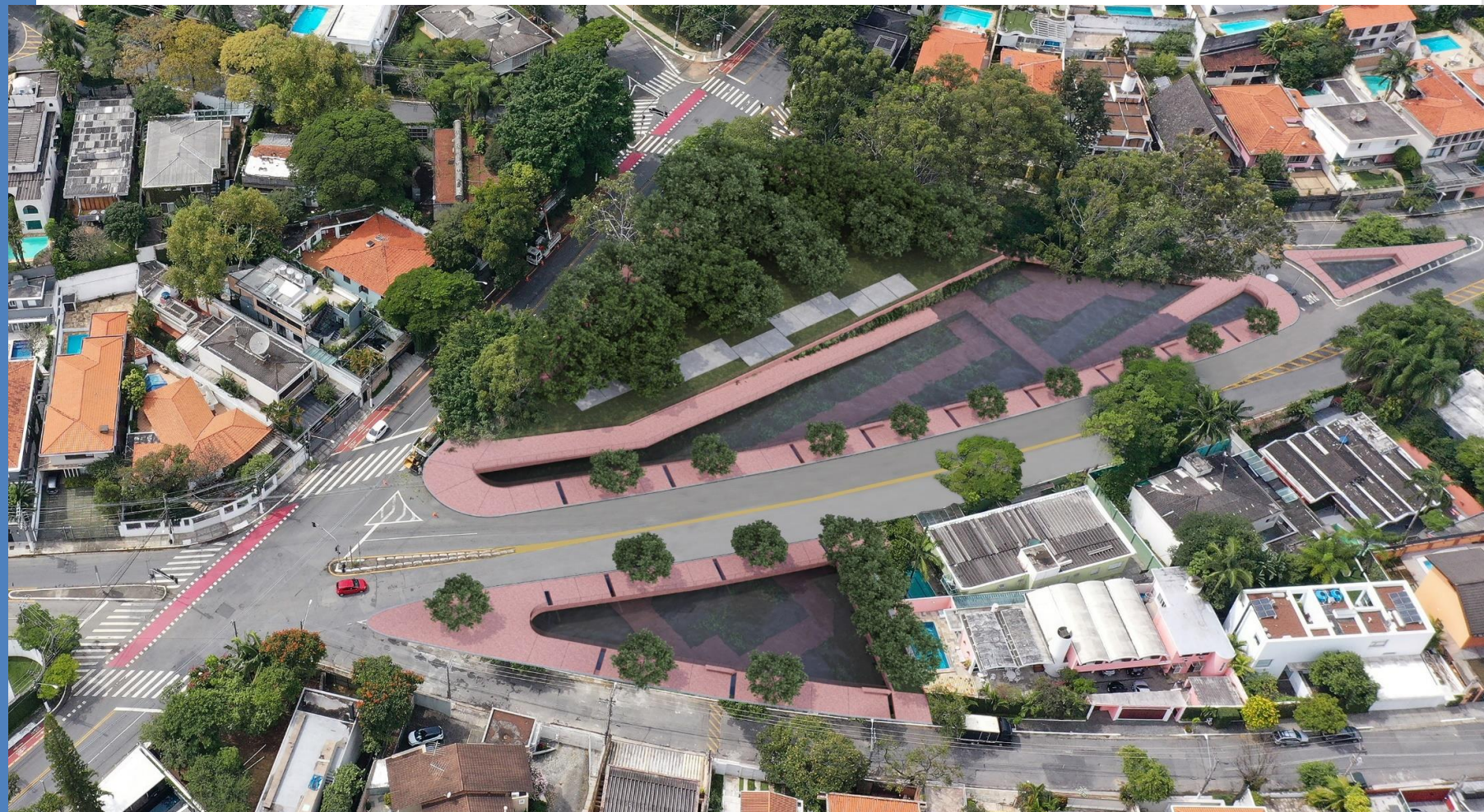
Perspectiva aérea do Reservatório Abegoaria – Depois (cheio)
