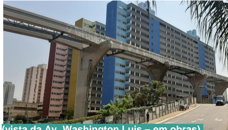
(vista da Av. Washington Luis – em obras)
