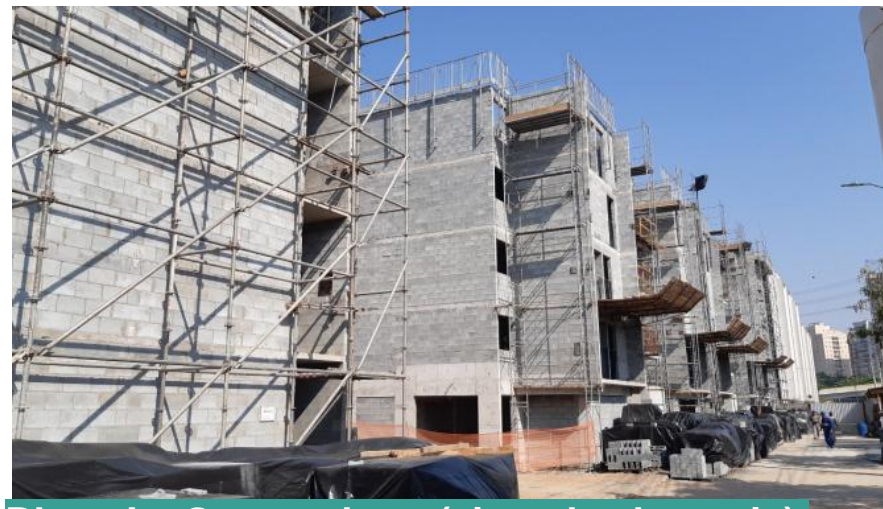
Bloco I e G - em obras (vista da alvenaria)
