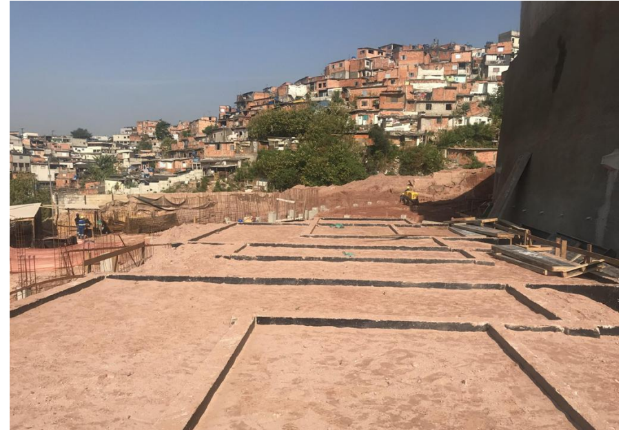
Condomínio 6B - em obras (entrega pós 2020) (aterro das vigas baldrame)
