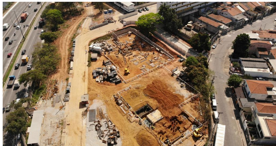
Condomínios J, K e L- obras (entrega pós 2020) (vista dos platôs)
