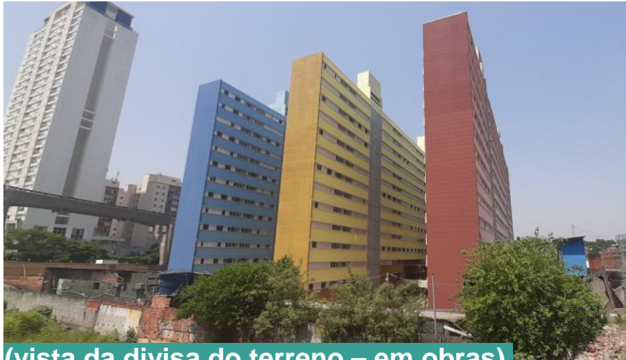
(vista da divisa do terreno – em obras)
