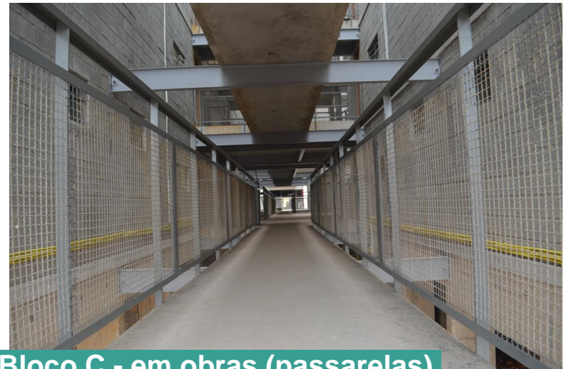
Bloco C - em obras (passarelas)
