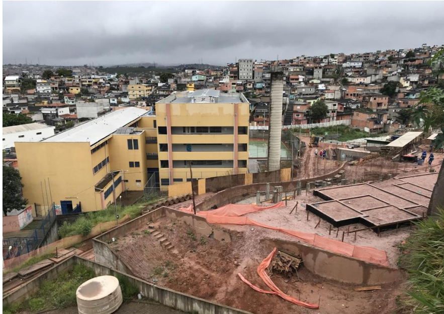
Condomínio 6B - em obras (entrega pós 2020) (vista aérea da implantação)
