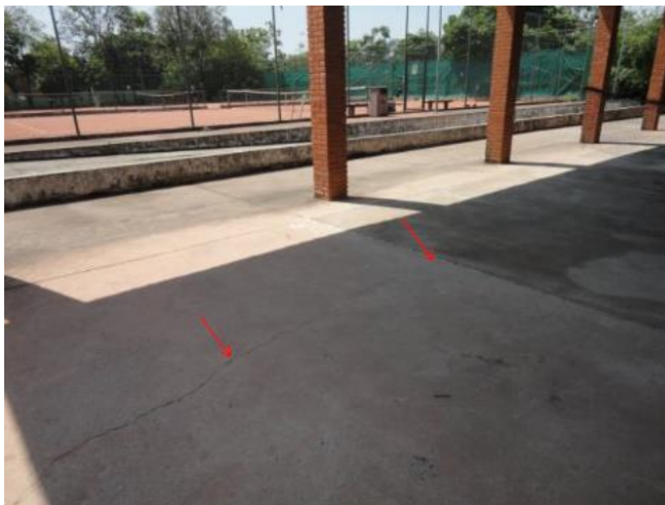
Figura 10: Piso. Fonte: Urbia Gestão de Parques
