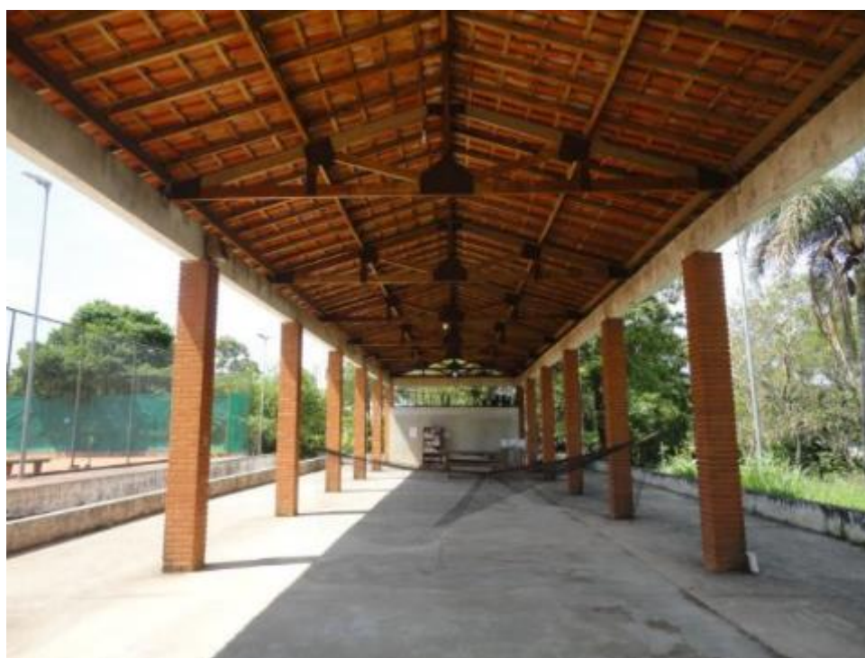
Figura 11: Piso e Telhado. Fonte: Urbia Gestão de Parques
