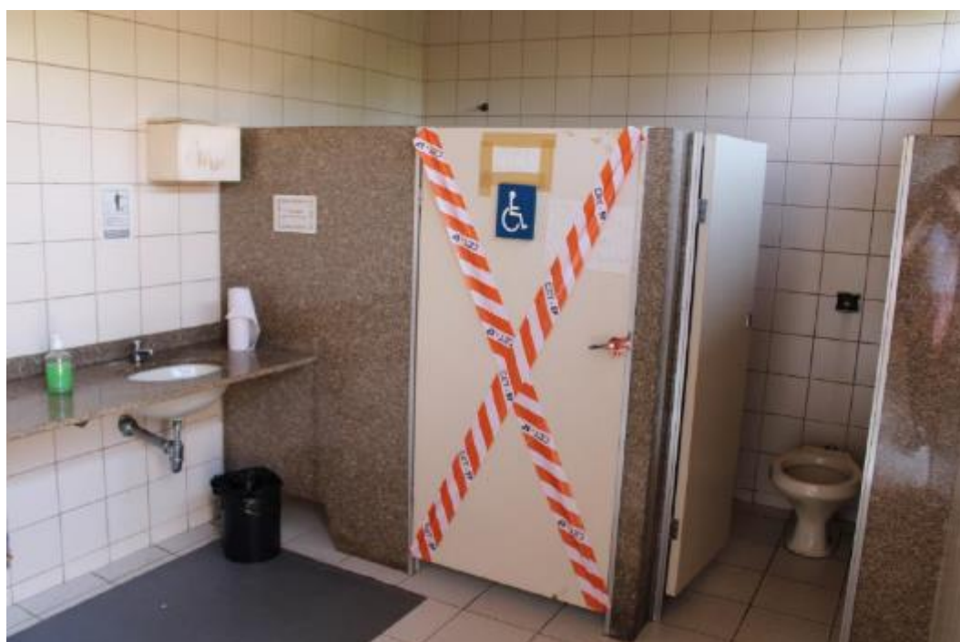
Figura 8: Sanitário Masculino. Fonte: Urbia Gestão de Parques
