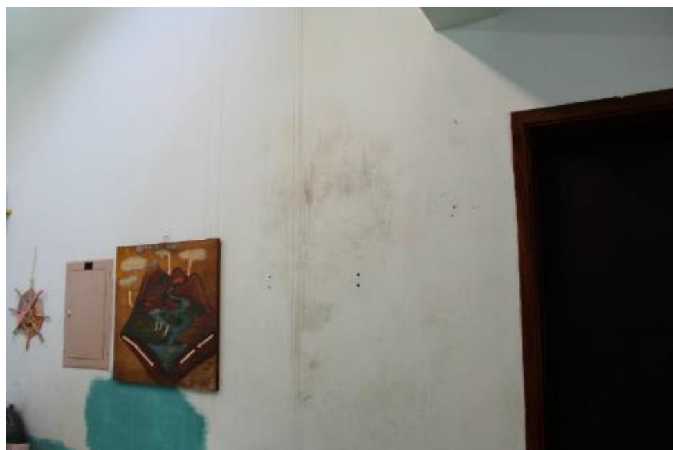
Figura 4: Parede Interna. Fonte: Urbia Gestão de Parques
