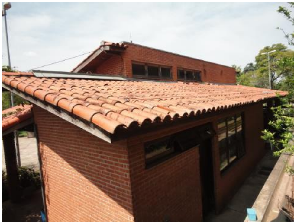
Figura 3: Telhado. Fonte: Urbia Gestão de Parques
