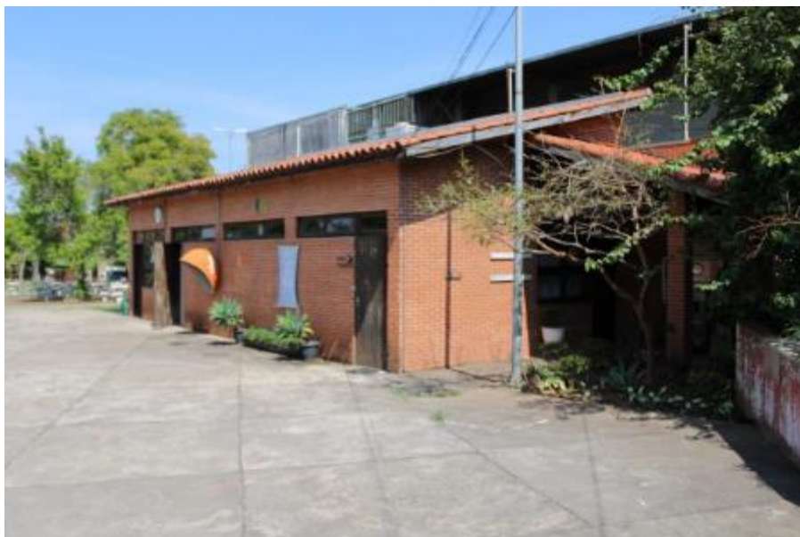
Figura 2: Edificação Administração e Sanitários. Fonte: Urbia Gestão de Parques
