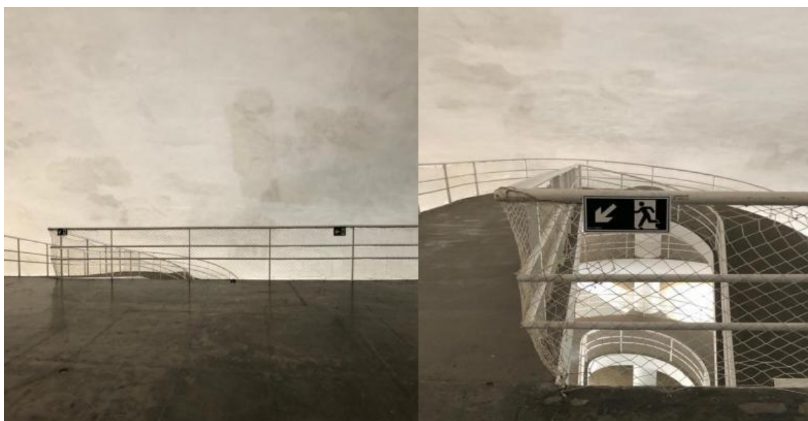
Imagem 24 e 25: Placas de sinalização de Rota de fuga a 1,00m do piso acabado.
