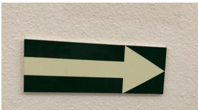
Imagem 12: Placa de indicação de rota de fuga não possui indicação do nome do fabricante ou CNPJ.
