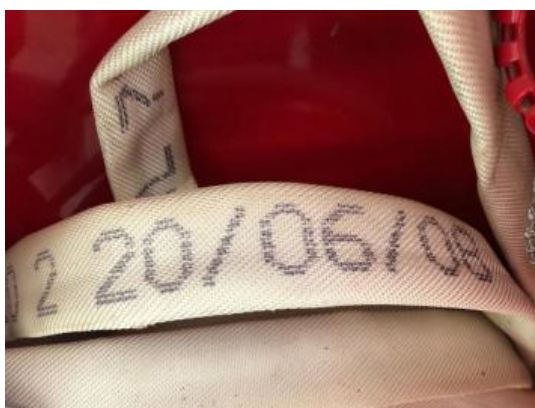
Imagem 50: Mangueira de hidrante vencida
