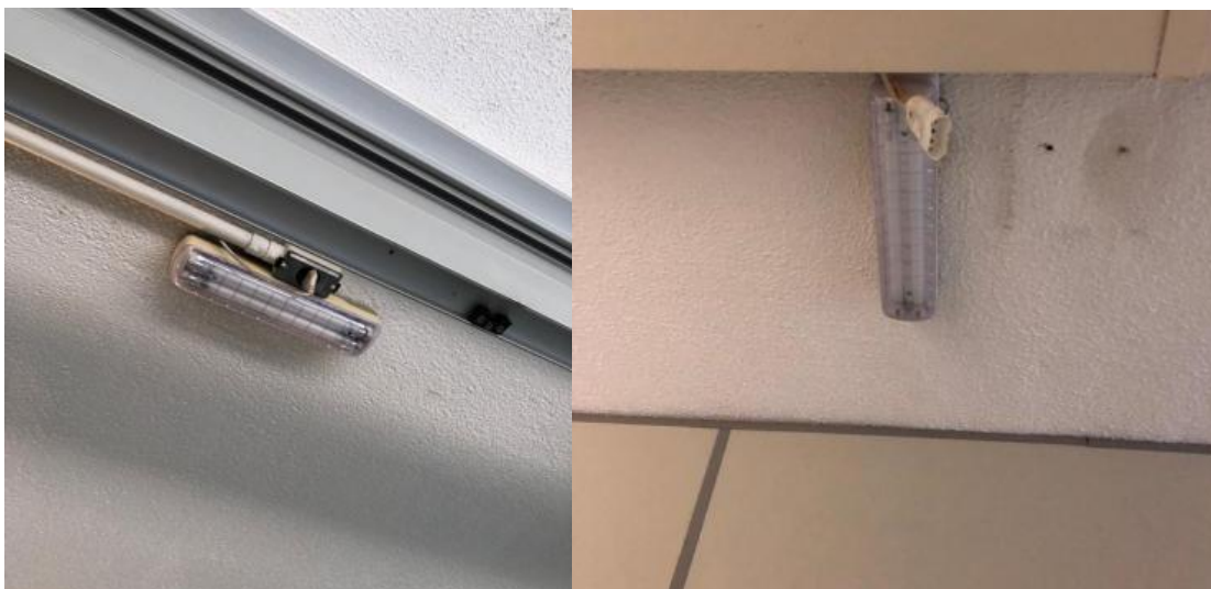
Imagem 46 e 47: a esquerda luminária que está conectada na energia elétrica, mas não funcionou no teste e a direita está desconectada da energia elétrica.
