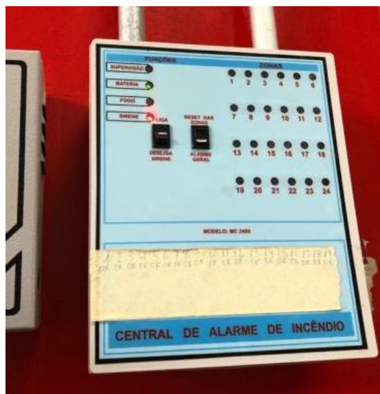
Imagem 37: Central de alarme de incêndio convencional do fabricante Metalcasty.
