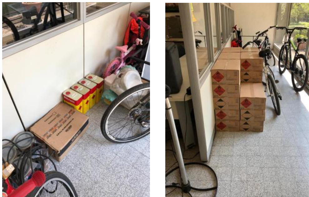
Imagem 44 e 45: Produtos inflamáveis em local inadequado.
