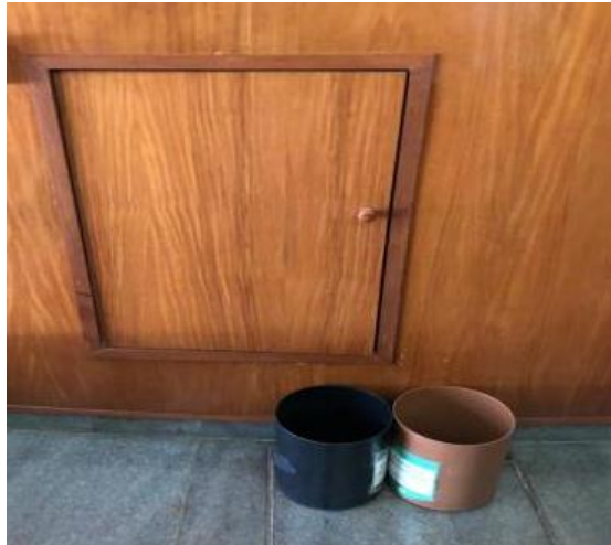
Imagem 56: Hidrante obstruído por lixeiras
