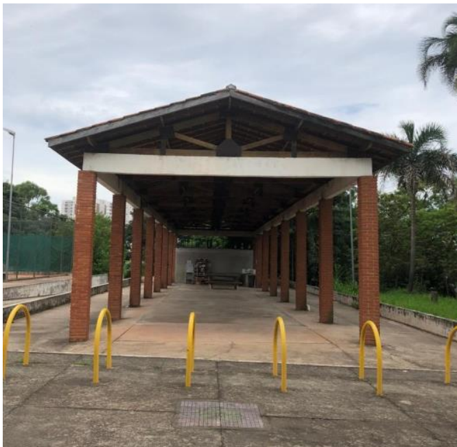
Figura 7: Quadra de bocha sem equipamento de proteção contra incêndio
