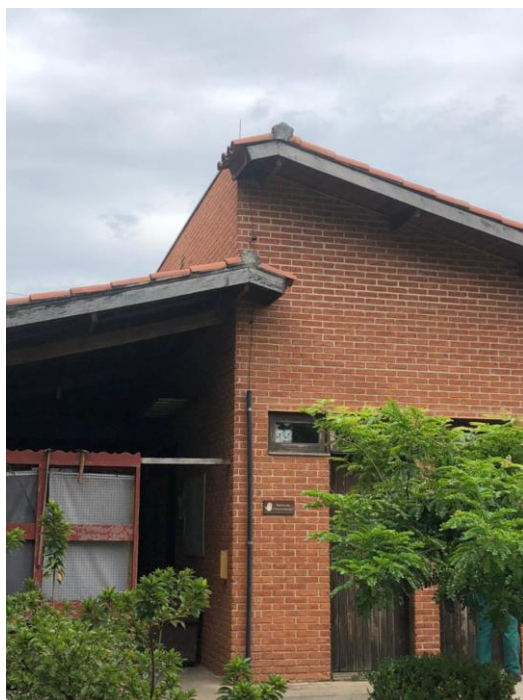
Figura 12: : SPDA no prédio administrativo
