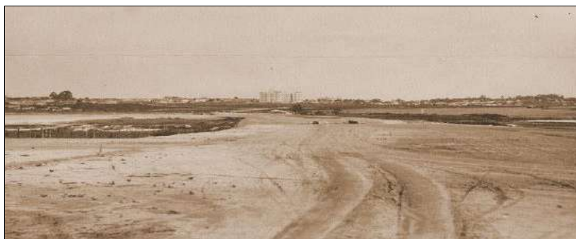
FIGURA 5 - OBRAS DE TERRAPLENAGEM REALIZADAS EM 1935 NA ÁREA DA VÁRZEA, ATUALMENTE OCUPADA PELO PARQUE IBIRAPUERA.
