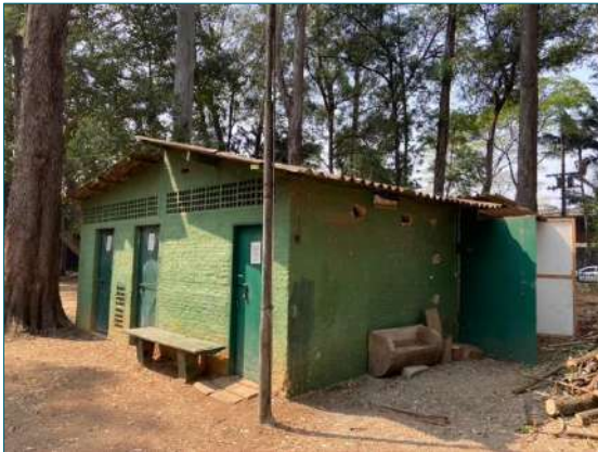
Edificação existente na base operacional
