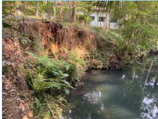
FIGURA 21 - DETALHE DE TALUDE ÍNGREME E MAL CONFORMADO, COM ACESSO OPERACIONAL DIFICULTADO À MARGEM DO CÓRREGO SAPATEIRO. 39
