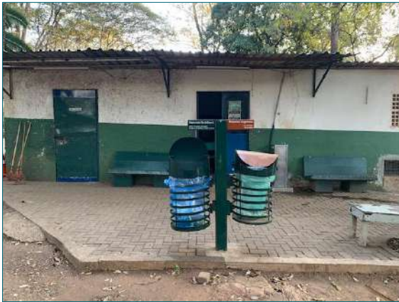
Edificação existente na base operacional
