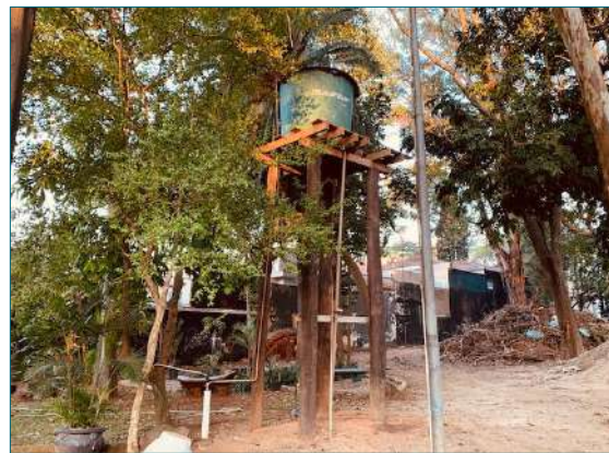
Caixa d'água elevada
