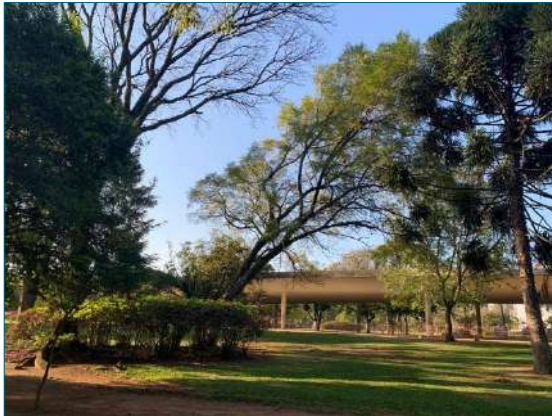
Árvore com inclinação excessiva, que necessita de escoramento
