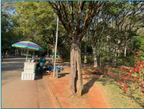
Exemplar arbóreo com tronco comprometido, que deverá ser monitorado
