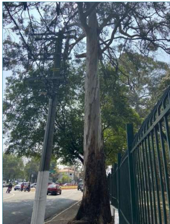
Eucalipto de grande porte, na área externa do Parque Ibirapuera, junto ao gradil em situação não conforme
