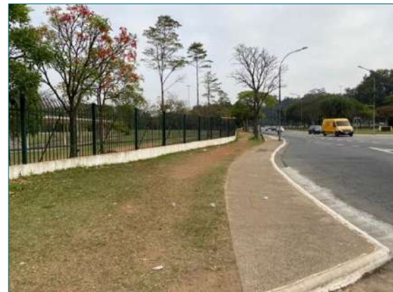
Aspecto de gramado ao longo da Av. Pedro Álvares Cabral com manutenção inadequada
