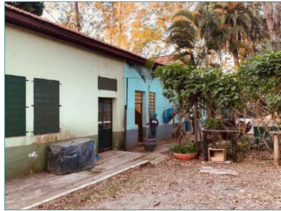
Edificação existente na base operacional
