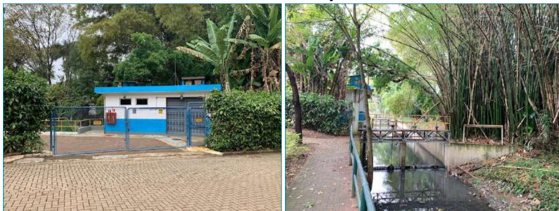
FIGURA 27 - ACESSO À ESTAÇÃO DE FLOTAÇÃO E REMOÇÃO DE FLUTUANTES (EFRF) DA SABESP NO INTERIOR DO PARQUE IBIRAPUERA E ESQUEMA DE TRATAMENTO DE ÁGUA POR FLOTAÇÃO.
