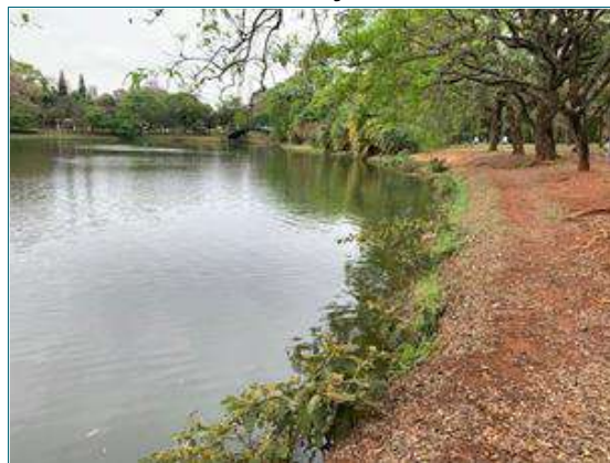
FIGURA 22 - TALUDE ÍNGREME À MARGEM DO LAGO QUE APRESENTA DIFICULDADES PARA A SUA MANUTENÇÃO MECANIZADA. 40
