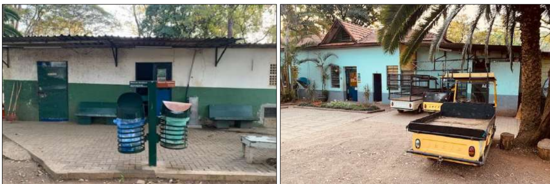
FIGURA 34 - BASE OPERACIONAL UTILIZADA PELA EMPRESA HESE NO PARQUE IBIRAPUERA. 73
