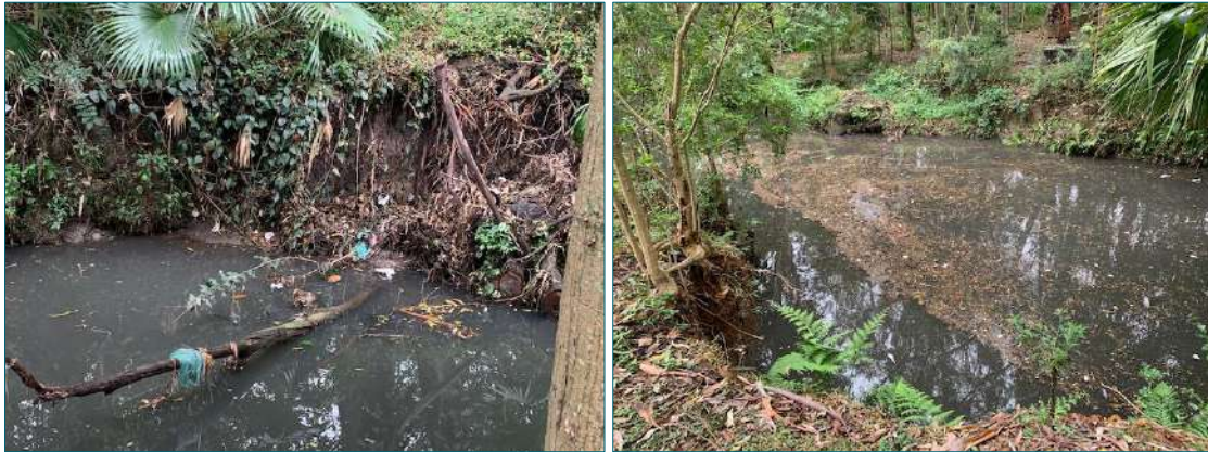
FIGURA 28 - RESÍDUOS E DETRITOS VERIFICADOS NAS ÁGUAS DO CÓRREGO DO SAPATEIRO, À MONTANTE DO LAGO 1, EM AGOSTO DE 2020. ASPECTO DO CÓRREGO DO SAPATEIRO, JUNTO AO LAGO 1 DO PARQUE.
