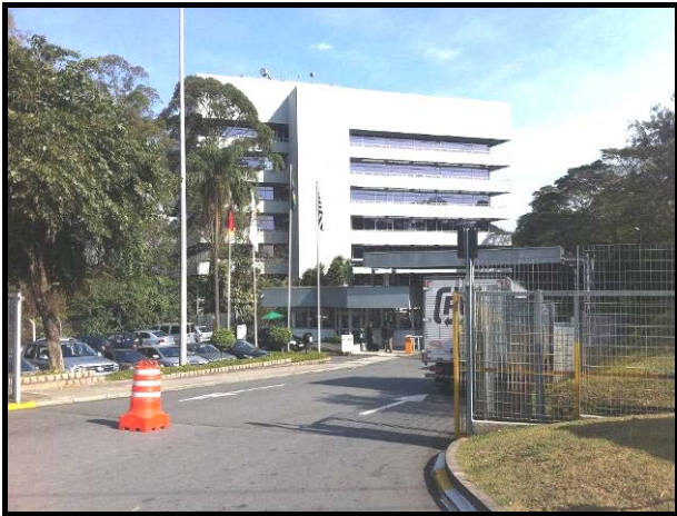
FIGURA 2.3.3.1 – Prédio da SIEMENS, situado ao norte da RPPN.
