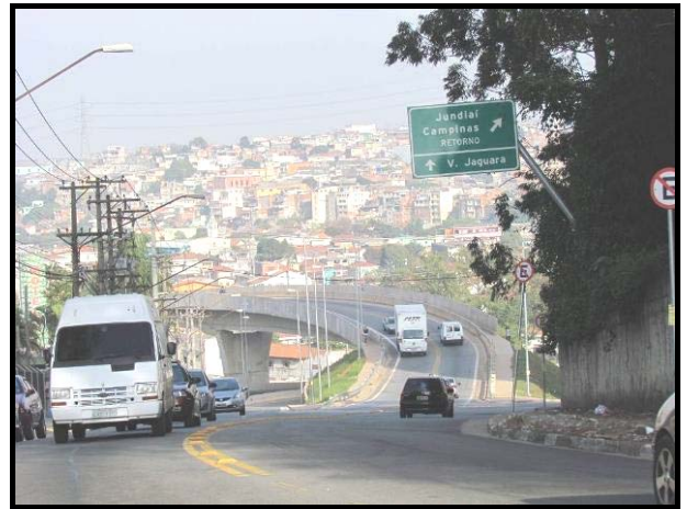
FIGURA 2.3.3.2 – Início da avenida Mutinga, que dá acesso à via anhanguera (esquerda).
