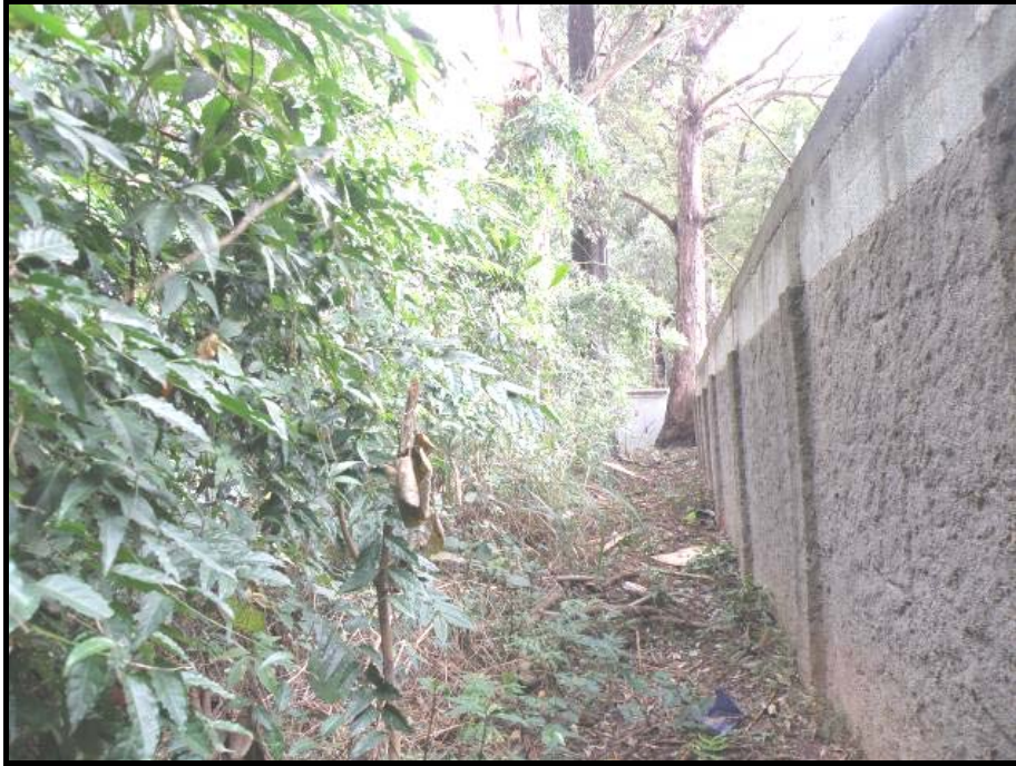
FIGURA 3.1.4.2 - Vista da área delimitada como Zona de Transição.
