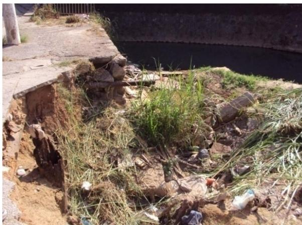
Figura 49 - Rio Verde junto da Av. Itaquera. Nota-se o desenvolvimento de processo erosivo junto da margem direita.
