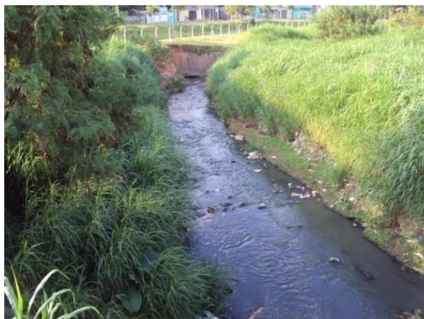
Figura 54 - Jusante da R. Castelo do Piauí. Nota-se, na foto, a execução recente de trabalho de retaludamento da margem esquerda e remoção parcial das moradias.
