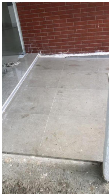
Foto 9.3.2-5 - Rampa de acesso em reforma.
