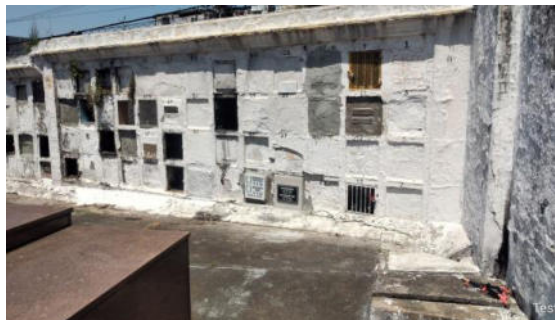
Foto 9.1.7.5-5: Canaleta na base do ossário do muro da rua Carlos Gomes.
