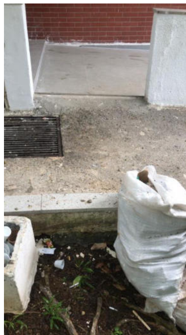
Foto 9.3.2-6 – Detalhe da rampa de acesso em reforma.
