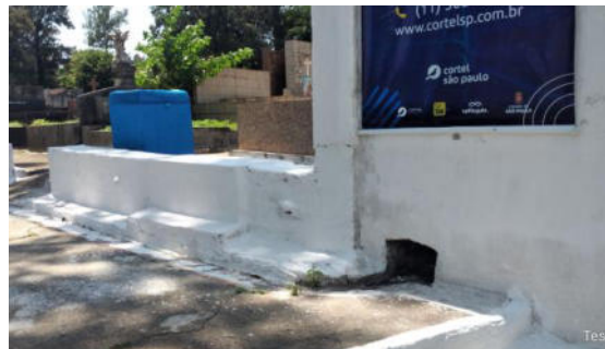
Foto 9.1.7.5-6: Saída d'água da canaleta posicionada no muro da rua Carlos Gomes, no Portão principal do cemitério
