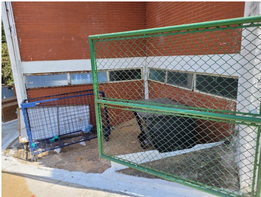
Foto 5.1.8 - Vista dos fundos da porção administrativa do cemitério
