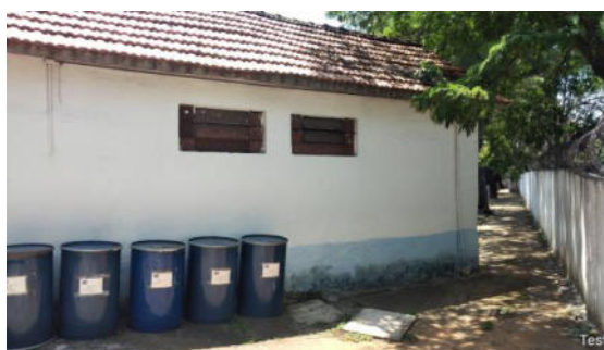
Foto 9.1.7.5-9: Caixa situada nos fundos dos antigos sanitários, com destinação desconhecida.
