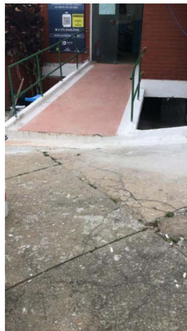
Foto 9.3.2-4 – Rampa já existente (com degrau a adequar).
