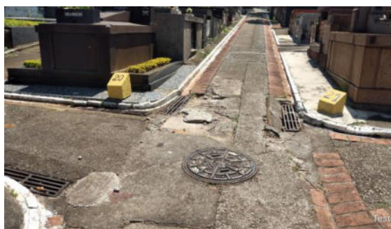
Foto 9.1.7.5-1 - Bueiros interligados a galerias subterrâneas de águas pluviais.
