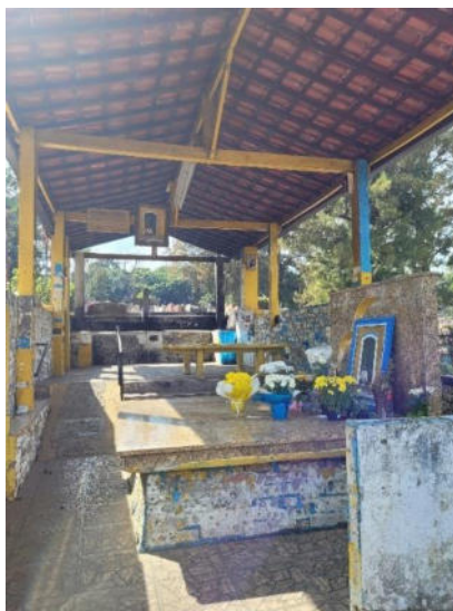
Foto 5.1.10 - Vista geral da área coberta do cemitério, na porção norte (área destinada ao Milagreiro Bento do Portão)
