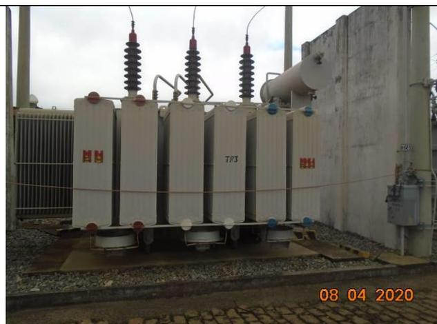
**Foto 12:** Vista geral da área do Transformador 3 12/15 MVA da ETD Guarapiranga. Esse transformador será substituído por um de 15/20 MVA. Haverá atividades construtivas nesse local. Vista em sentido Sudoeste.
