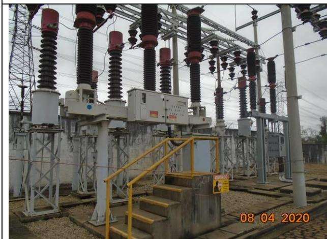
**Foto 09:** Vista geral dos disjuntores, TC e TP da ETD Guarapiranga. LTA PI-BAN ao fundo da imagem. Vista em sentido Leste.
