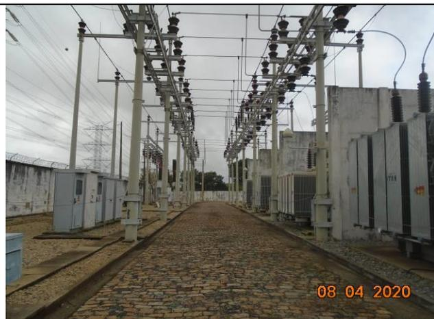
**Foto 14:** Vista geral da ETD Guarapiranga com os transformadores a direita e os disjuntores à esquerda. Vista em sentido Sudeste. LTA PI-BAN a esquerda.
