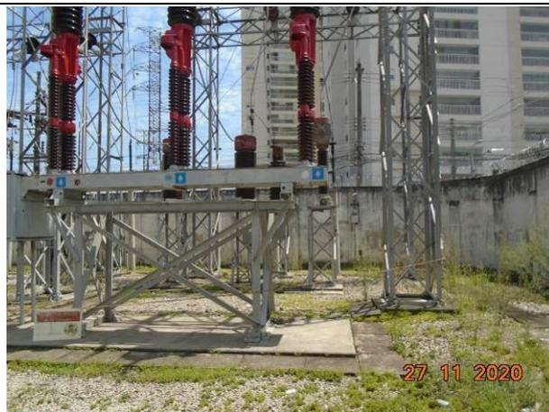
**Foto 48:** Vista dos disjuntores na ETD Água Branca. Nota-se que a ETD não possui vegetação nativa.
