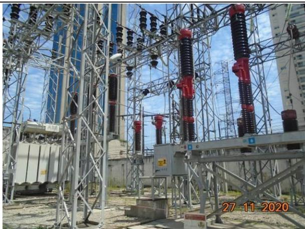
**Foto 47:** Vista dos disjuntores na ETD Água Branca.
