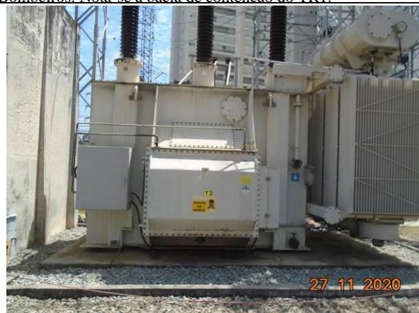
**Foto 54:** Vista geral do transformador TR-2 de 15/20 MVA que ser\u00e1 removido. Ser\u00e1 instalado um transformador de 32/40 MVA no local. Ser\u00e1 constru\u00eddo uma parede corta-fogo do lado direito do transformador, conforme IT 37 do Corpo de Bombeiros.
