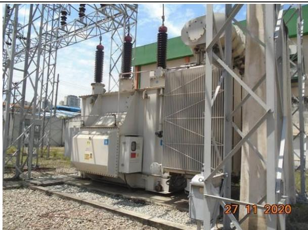
**Foto 51:** Vista geral do transformador TR-1 de 15/20 MVA que ser\u00e1 removido. Ser\u00e1 instalado um transformador de 32/40 MVA no local. Ser\u00e1 constru\u00eddo uma parede corta-fogo do lado esquerdo do transformador, conforme IT 37 do Corpo de Bombeiros.
