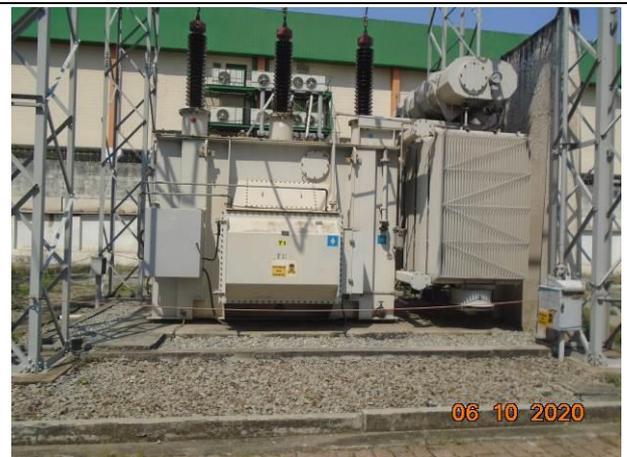
**Foto 12:** Vista geral do transformador TR-1 de 15/20 MVA que será removido. Será instalado um transformador de 32/40 MVA no local. Será construído uma parede corta-fogo do lado esquerdo do transformador, conforme IT 37 do Corpo de Bombeiros.
