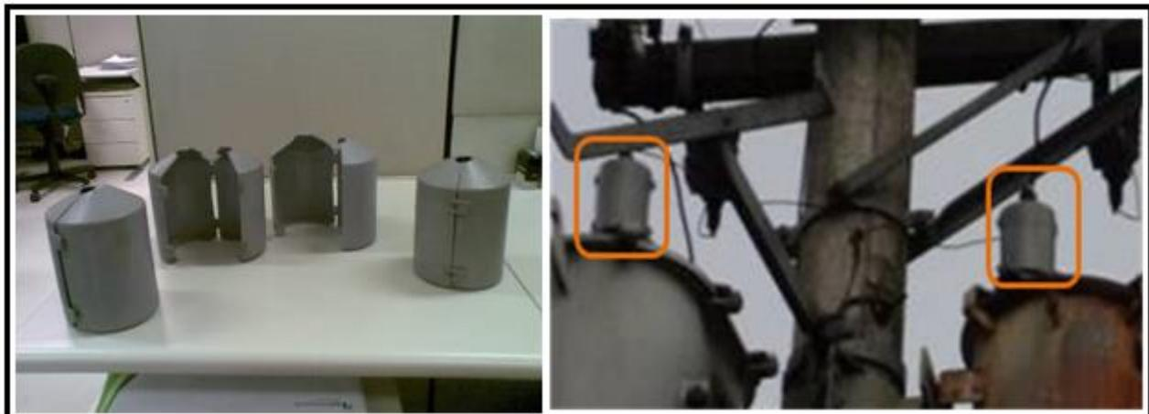
Figura 05- Protetor de Bucha de Transformador
