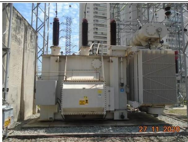
**Foto 56:** Vista geral do transformador TR-2 de 15/20 MVA que ser\u00e1 removido. Ser\u00e1 instalado um transformador de 32/40 MVA no local. Ser\u00e1 constru\u00eddo uma parede corta-fogo do lado direito do transformador, conforme IT 37 do Corpo de Bombeiros.
