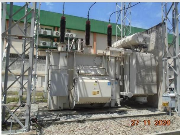
**Foto 49:** Vista geral do transformador TR-1 de 15/20 MVA que ser\u00e1 removido. Ser\u00e1 instalado um transformador de 32/40 MVA no local. Ser\u00e1 constru\u00eddo uma parede corta-fogo do lado esquerdo do transformador, conforme IT 37 do Corpo de Bombeiros.
