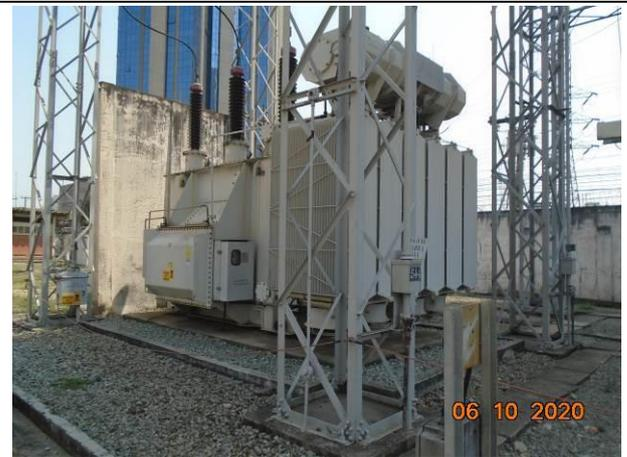
**Foto 10:** Vista geral do transformador TR-2 de 15/20 MVA que será removido. Será instalado um transformador de 32/40 MVA no local. Será construído uma parede corta-fogo do lado direito do transformador, conforme IT 37 do Corpo de Bombeiros.
