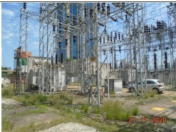
**Foto 35:** Vista dos disjuntores na ETD Água Branca.
