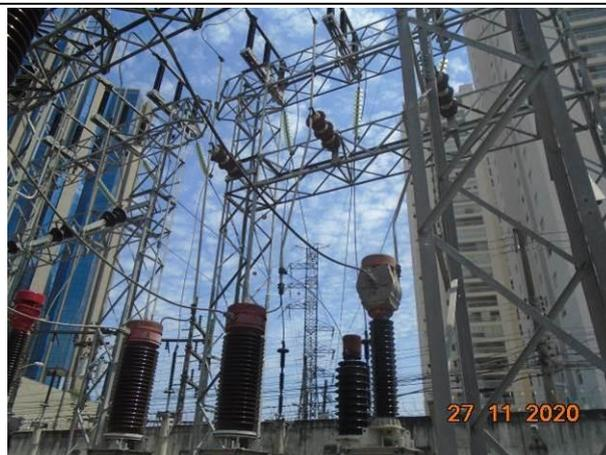
**Foto 40:** Vista dos disjuntores na ETD Água Branca. Nota-se ao fundo a torre e a linha que alimentam a ETD.
