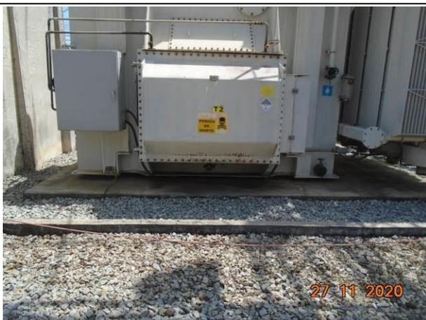
**Foto 55:** Vista geral do transformador TR-2 de 15/20 MVA que ser\u00e1 removido. Ser\u00e1 instalado um transformador de 32/40 MVA no local. Ser\u00e1 constru\u00eddo uma parede corta-fogo do lado direito do transformador, conforme IT 37 do Corpo de Bombeiros. Nota-se a bacia de conten\u00e7\u00e3o do TR-2.
