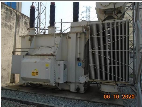
**Foto 11:** Vista geral do transformador TR-2 de 15/20 MVA que será removido. Será instalado um transformador de 32/40 MVA no local. Será construído uma parede corta-fogo do lado direito do transformador, conforme IT 37 do Corpo de Bombeiros.
