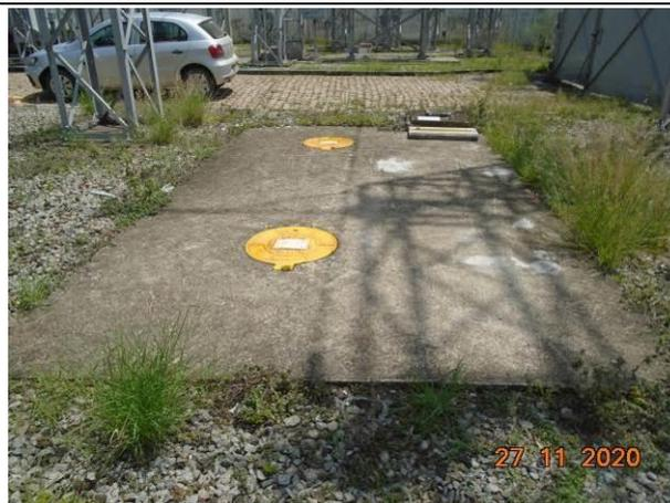
**Foto 38:** Vista da caixa de separação de água óleo na ETD Água Branca.
