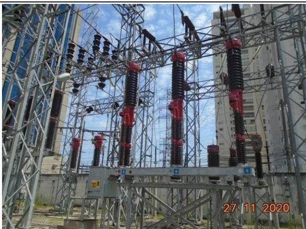
**Foto 39:** Vista dos disjuntores na ETD Água Branca.
