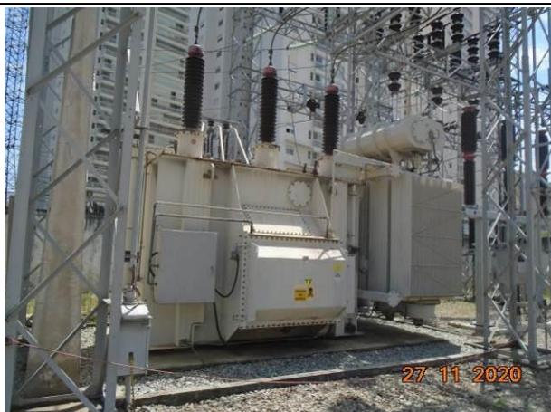
**Foto 53:** Vista geral do transformador TR-2 de 15/20 MVA que ser\u00e1 removido. Ser\u00e1 instalado um transformador de 32/40 MVA no local. Ser\u00e1 constru\u00eddo uma parede corta-fogo do lado direito do transformador, conforme IT 37 do Corpo de Bombeiros.
