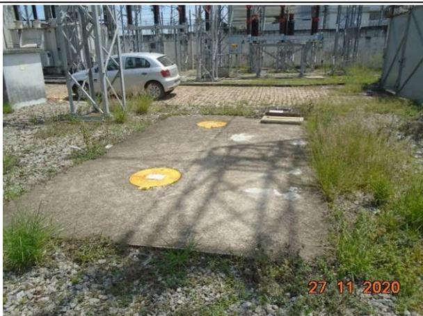
**Foto 37:** Vista da caixa de separação de água óleo na ETD Água Branca.
