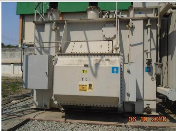
**Foto 13:** Vista geral do transformador TR-1 de 15/20 MVA que será removido. Será instalado um transformador de 32/40 MVA no local. Será construído uma parede corta-fogo do lado esquerdo do transformador, conforme IT 37 do Corpo de Bombeiros.
