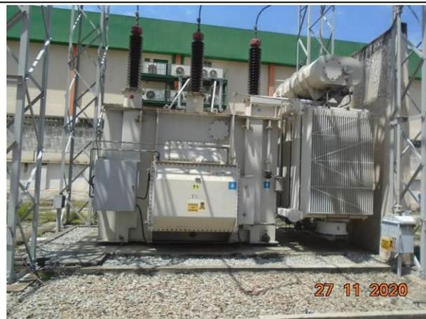
**Foto 50:** Vista geral do transformador TR-1 de 15/20 MVA que ser\u00e1 removido. Ser\u00e1 instalado um transformador de 32/40 MVA no local. Ser\u00e1 constru\u00eddo uma parede corta-fogo do lado esquerdo do transformador, conforme IT 37 do Corpo de Bombeiros.
