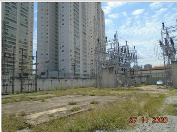
**Foto 61:** Vista da área que serão instalados os bancos capacitores na ETD Água Branca. Nota-se aos fundos os transformadores e a entrada principal da ETD.
