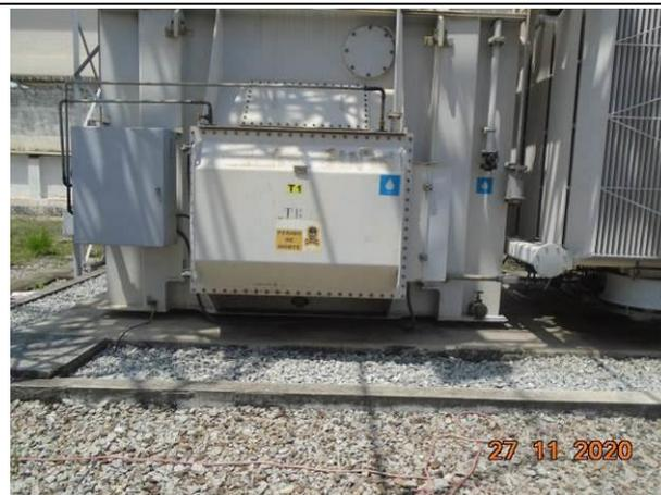
**Foto 52:** Vista geral do transformador TR-1 de 15/20 MVA que ser\u00e1 removido. Ser\u00e1 instalado um transformador de 32/40 MVA no local. Ser\u00e1 constru\u00eddo uma parede corta-fogo do lado esquerdo do transformador, conforme IT 37 do Corpo de Bombeiros. Nota-se a bacia de conten\u00e7\u00e3o do TR1.
