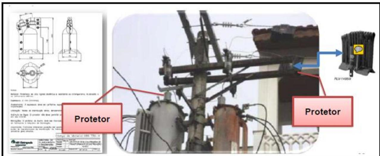
Figura 04- Capa protetora de estribo
