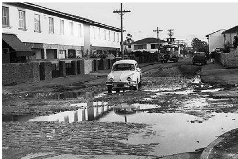
Figura 6 - Rua Nova Cidade: a região sofria com alagamentos
