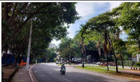
Figura 83 - Detalhe do viário em cima do córrego Uberaba, trecho este que se encontra canalizado.
