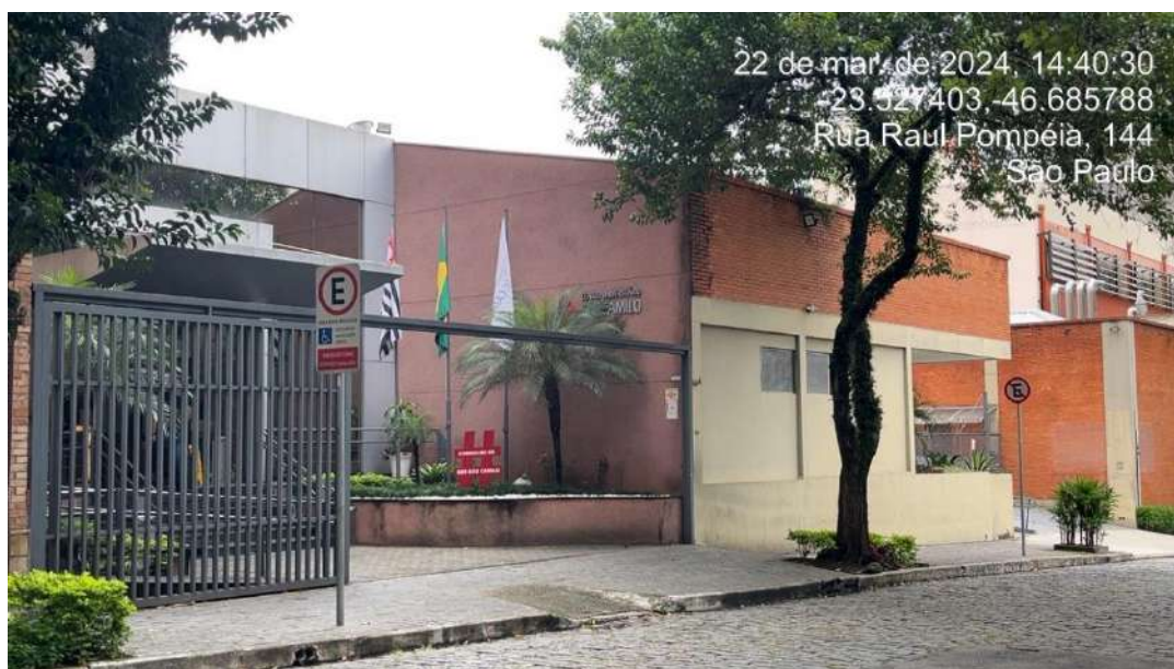
Figura 117 - Vista da fachada do Centro Universitário São Camilo, antigo Conjunto Industrial tombado pelo município.
