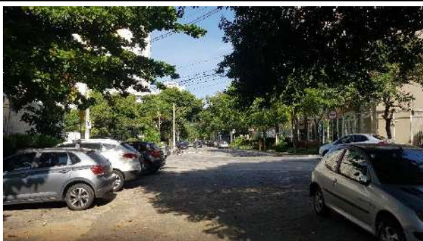
Figura 104 - Detalhe do traçado do córrego Água Preta, trecho este que se encontra canalizado.
