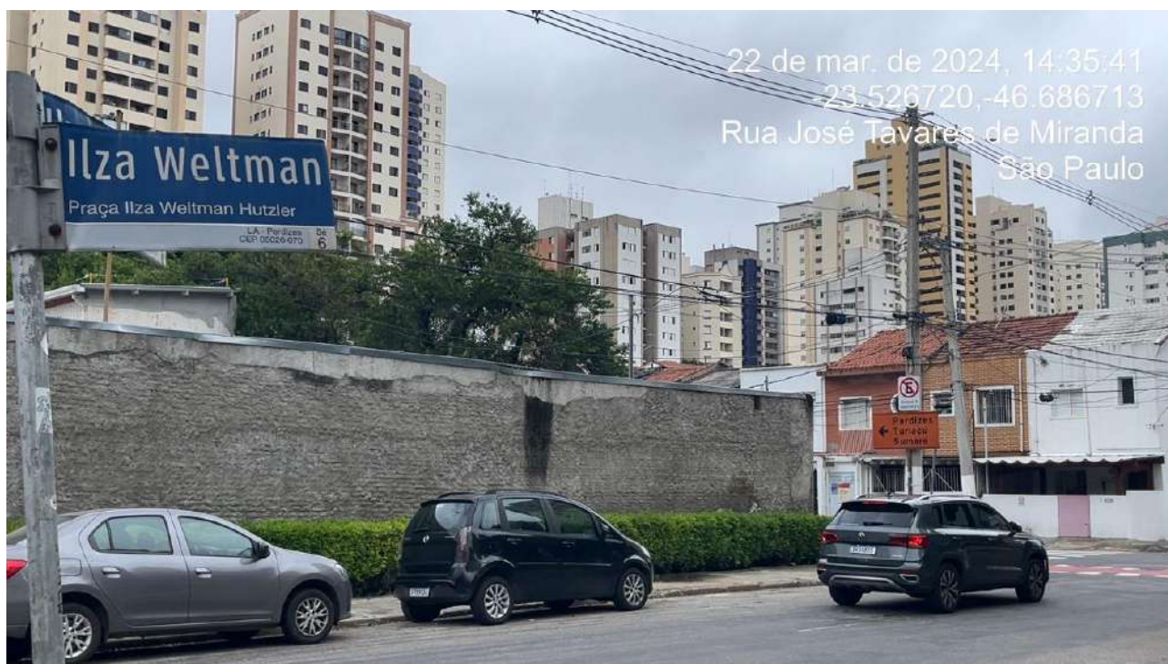
Figura 141 - Vista de muro de Estacionamento Particular na ADA do empreendimento.
