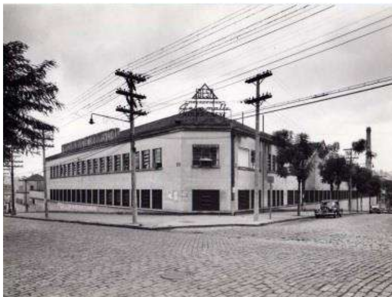
Figura 9 – Fábrica da IBESA/CONFAB, precursora da fábrica de geladeiras Clímax, cujo espaço foi posteriormente revitalizado pelo projeto inovador de Lina Bo Bardi para criar o atual SESC-Pompéia. – Fonte: https://www.saopauloinfoco.com.br/sesc-pompeia-lina-bo-bardi/
