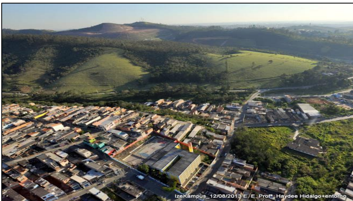
Foto 13 - Vista da E.E. Profª Haydee Hidalgo e entorno em 2013. Foto: IzeKampus (2013).
