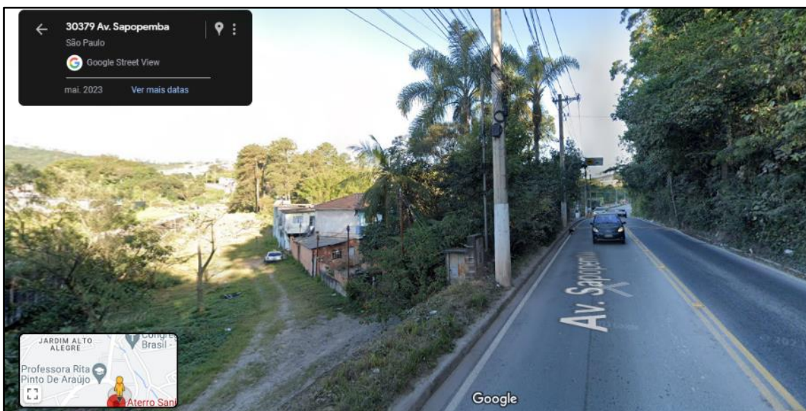
Foto 11 - Vista da Av. Sapopemba, próximo à entrada do Aterro São João. Fonte: Google Street View, 2023.
