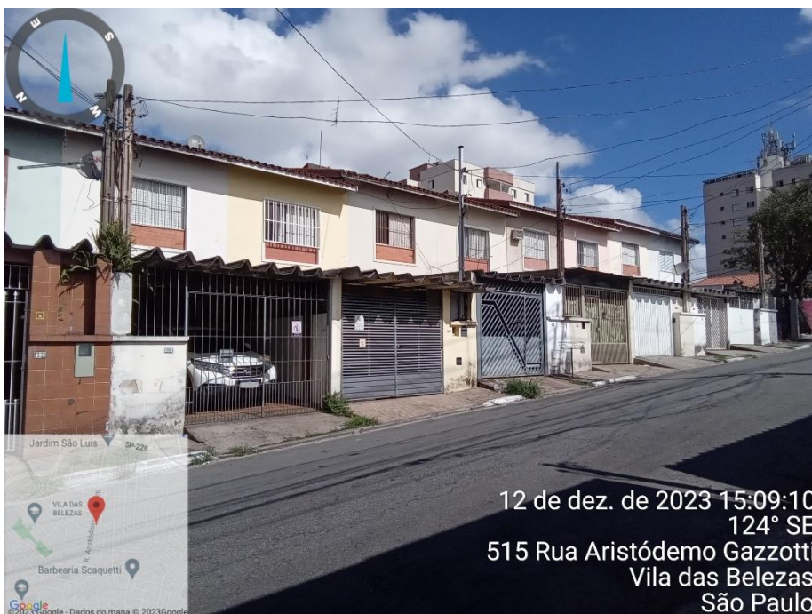
Foto 12.2.3-10 – Moradia – distrito de Jardim São Luís
