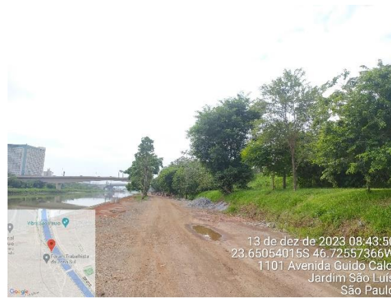
Foto 12.3-12 - Vista da ADA em trecho do Parque Linear Bruno Covas.
