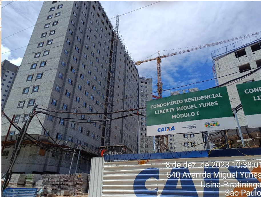
Foto 12.2.3-9 – Moradia – distrito de Campo Grande
