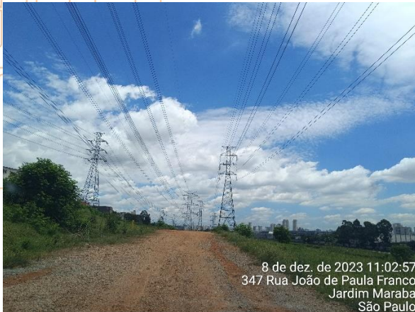
Foto 12.3.3-3 – Torres de energia elétrica – distrito de Socorro
