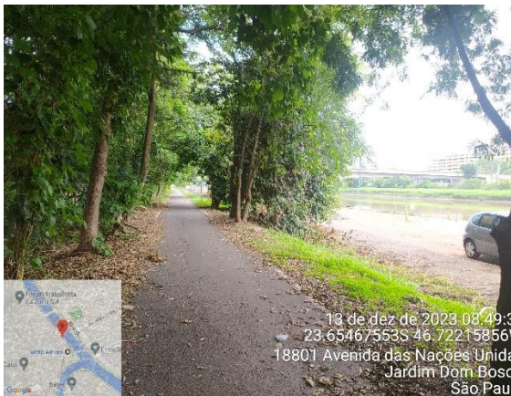
Foto 12.3-17 - Vista da ADA em trecho do Parque Linear Bruno Covas.
