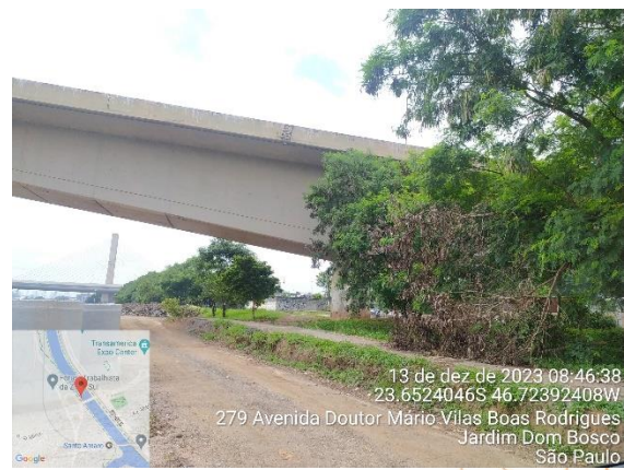
Foto 12.3-14 - Vista da ADA em trecho do Parque Linear Bruno Covas.
