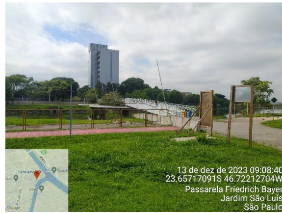
Foto 12.3-18 - Vista da ADA.
