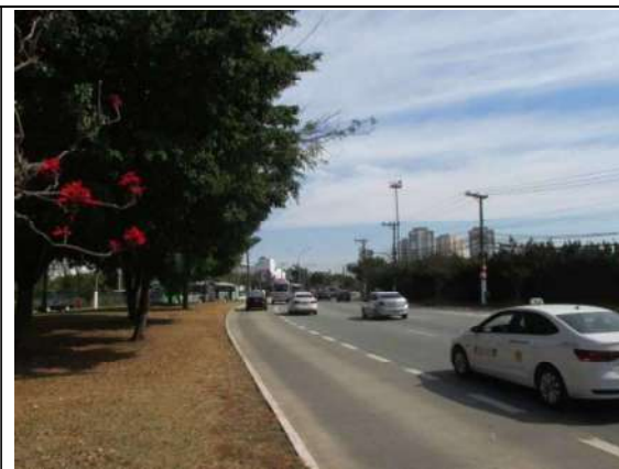
Foto 01: Aproximação sentido Lapa – Av. Marquês de São Vicente (loteamento à esquerda da foto).
