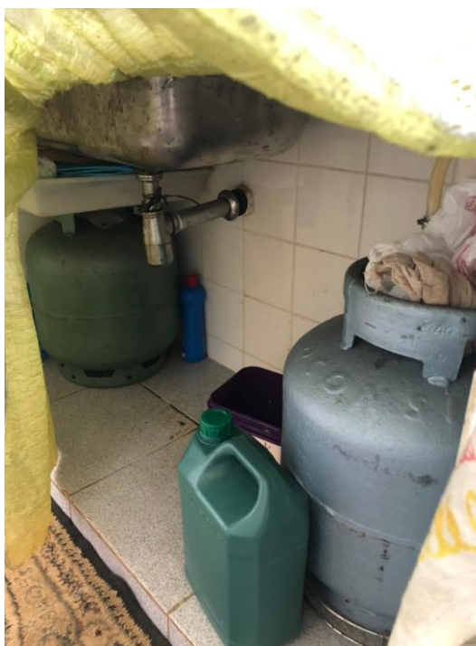
Figura 4: Cilindros de GLP 13kg sendo utilizados no interior da edificação com materiais
