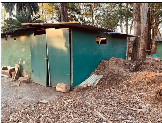
Figura 40. Peças rústicas confeccionadas com troncos ao lado da unidade de trituração do Parque.
