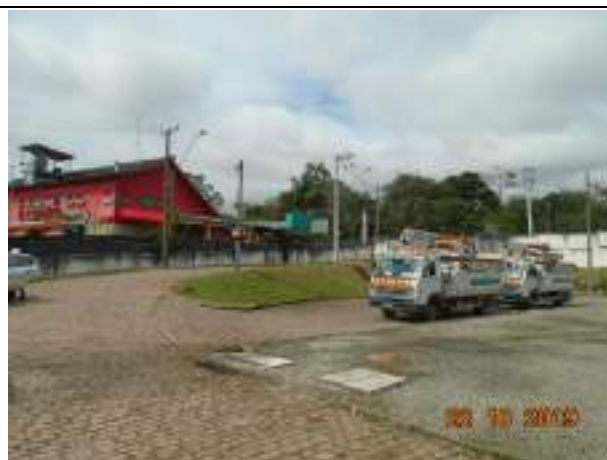
Foto 06: Vista da Subestação ETD Rio Bonito no sentido Sul. Entrada da subestação ao fundo da imagem.
