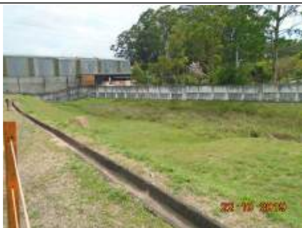
Foto 09: Vista geral da área da ETD Rio Bonito. Nesta área não está prevista intervenção. Vista em sentido Norte.
