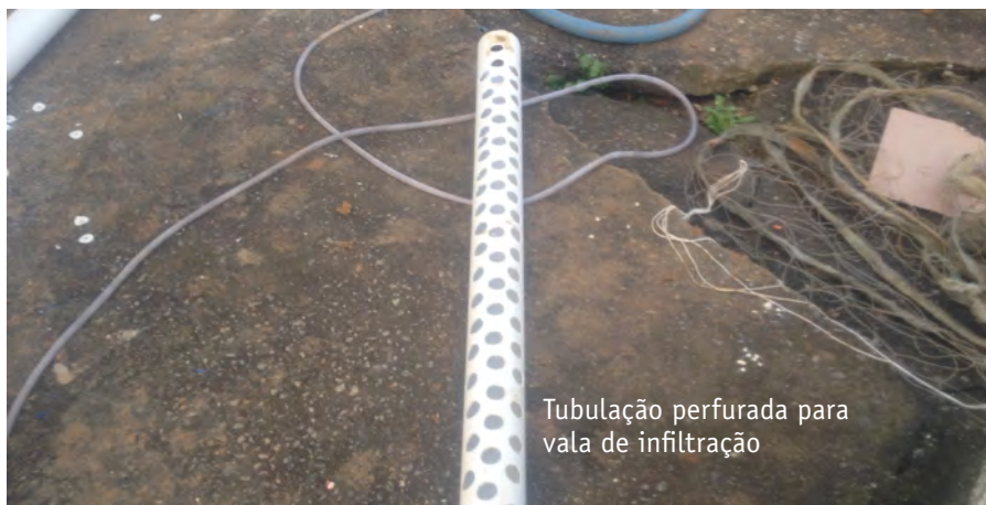
Foto 20 – Exemplo do cano furado para a vala de infiltração.
