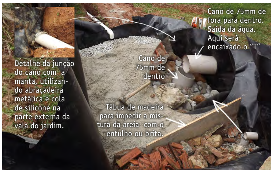
Foto 16 – Preenchimento da vala com brita e areia.
