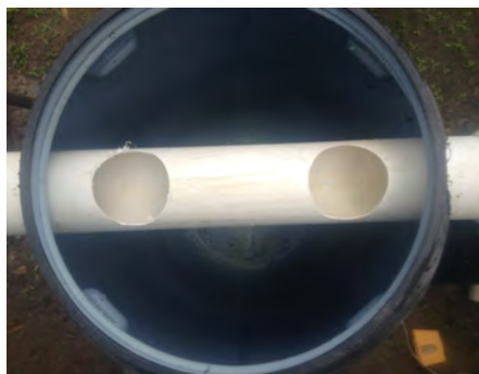
Fotos 34 e 35 – Detalhe dos furos no cano interno da cisterna, que depois será virado para baixo.
