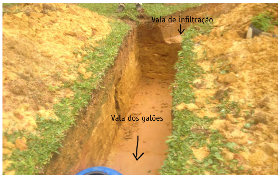
Foto 18 – Exemplo de vala escavada para as bombonas e da vala de infiltração.
