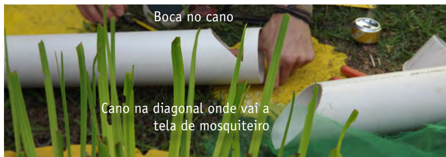
Foto 26 – Exemplos do corte nos canos para fazer o filtro de folhas.
