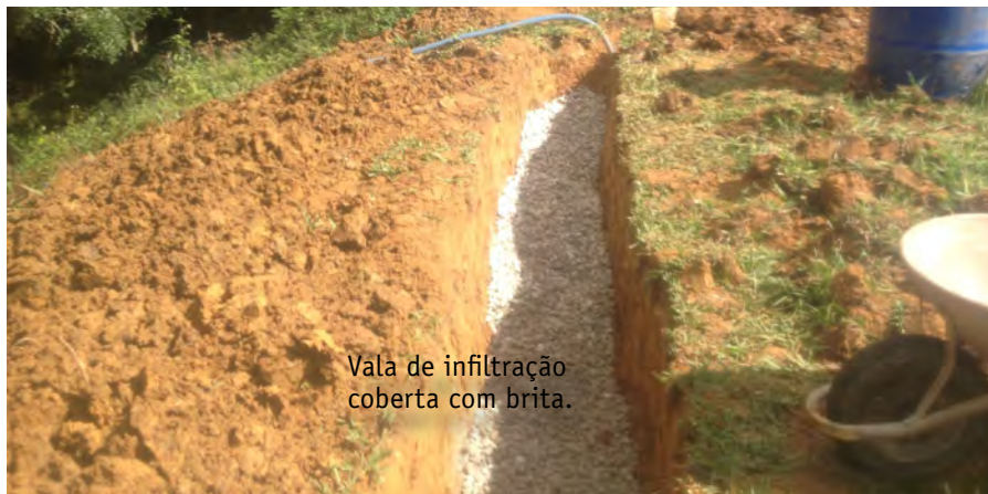
Foto 21 – Exemplo da vala de infiltração coberta com a primeira camada de brita e ainda sem o cano.
