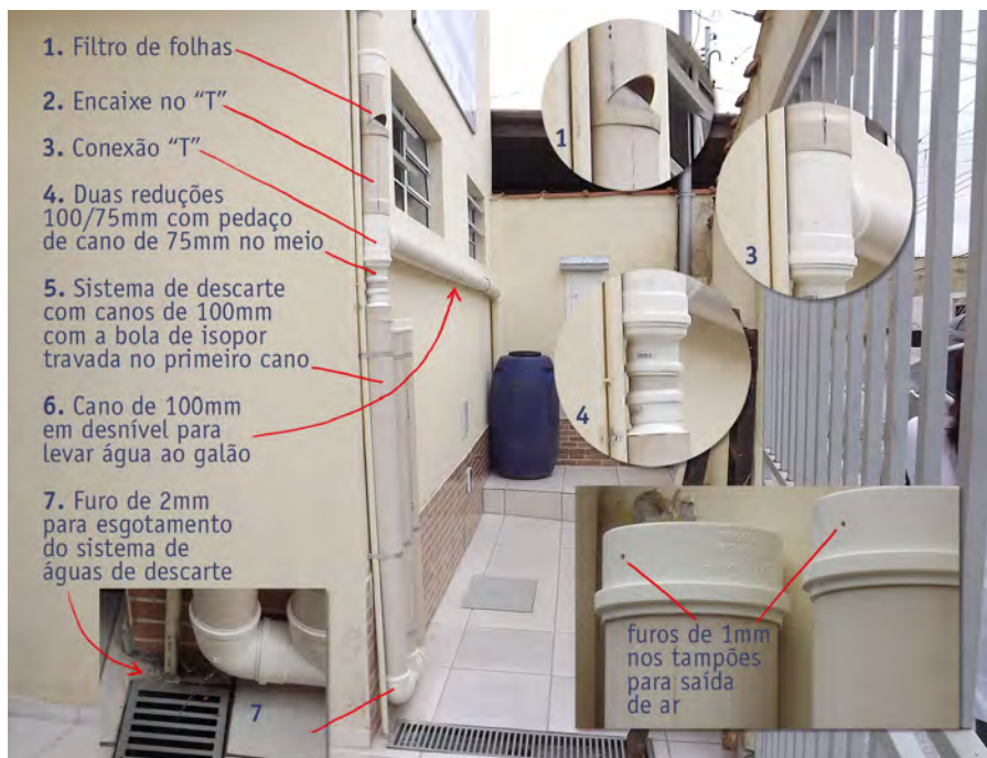
Foto 31 – Detalhamento da cisterna.
