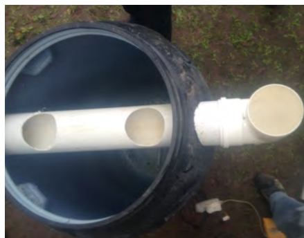
Fotos 34 e 35 – Detalhe dos furos no cano interno da cisterna, que depois será virado para baixo.
