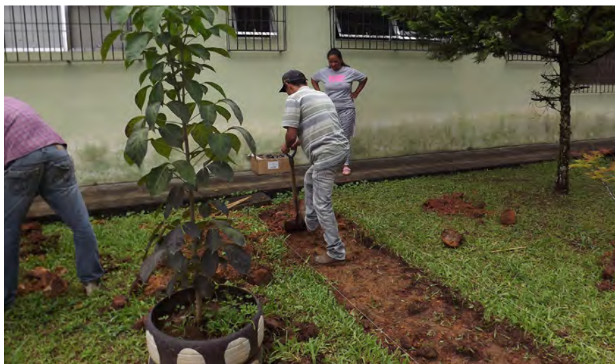
Foto 17 – Delimitação da vala para as bombonas.
