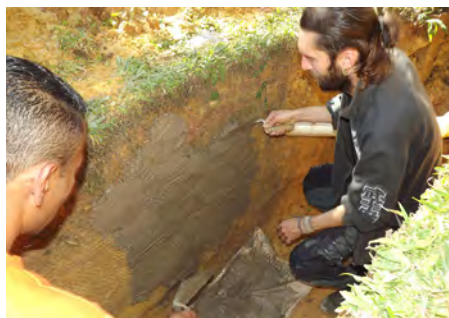
Foto 23 – Cobertura da tela com cimento.
