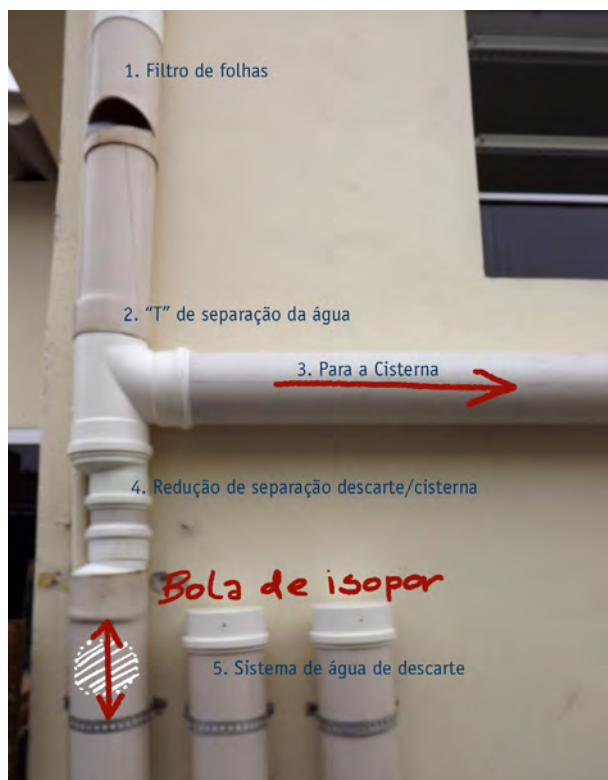
Foto 36 – Detalhe dos encaixes do filtro de folhas até o sistema da água de descarte.
