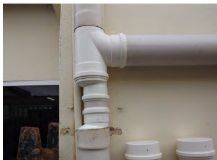
Foto 29 – Detalhe do “T” e das duas reduções de 100mm para 75mm.
