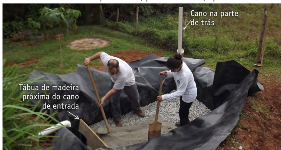
Foto 15 – Preenchimento da vala com brita e areia.
