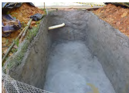
Foto 24 – Exemplo da BET impermeabilizada com o cimento.
