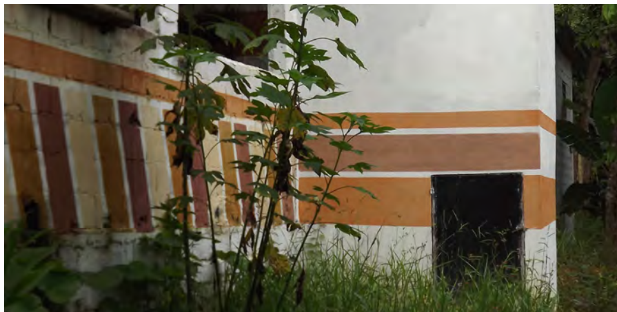
Foto 38 – Detalhes da parede do CEDESP (Centro Comunitário Jardim Autódromo) Anna Lapini pintados com a tinta de terra.
