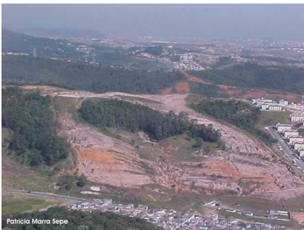
Foto 30 Área situada no distrito de Cidade Tiradentes (zona leste), onde observa-se processos erosivos em local com presença de vegetação e ocupação precária.
