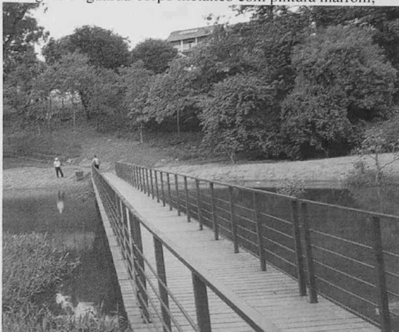
Imagem 2- guarda-corpo com chapa metálica perfurada”
