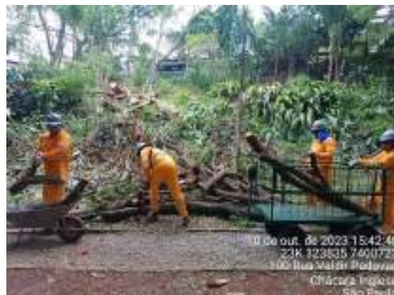
Figura 251 Manejo de galhos após queda de árvore entre as churrasqueiras/lago
