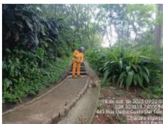
Figura 335 Limpeza de manutenção da escada para o lago e canaletas internas
