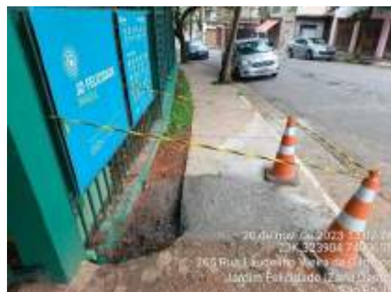
Figura 492 Manutenção e troca de encanamento com vazamentos em área externa - Calçada portaria 1 - SABESP
