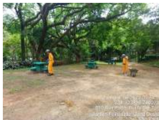
Figura 73 Manutenção de canteiros internos - Churrascaria
