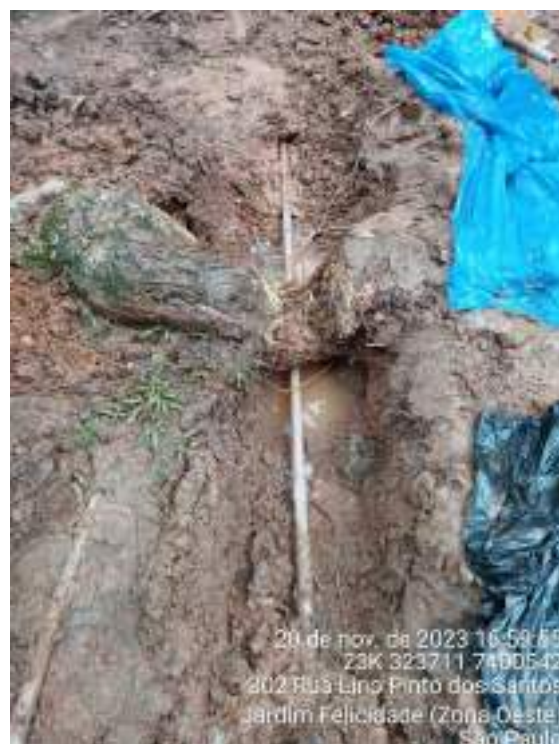
Figura 496 Manutenção e reparo de encanamento com vazamento em área interna - Parquinho - URBIA
