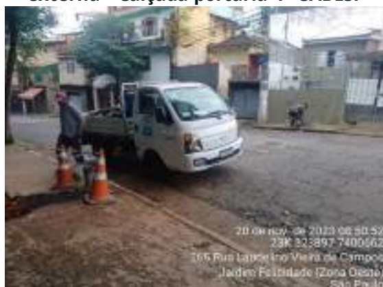
Figura 491 Manutenção e troca de encanamento com vazamentos em área externa - Calçada portaria 1 - SABESP
