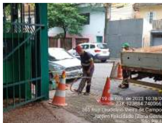
Figura 486 Manutenção e troca de encanamento com vazamentos em área externa - Calçada portaria 1 - SABESP
