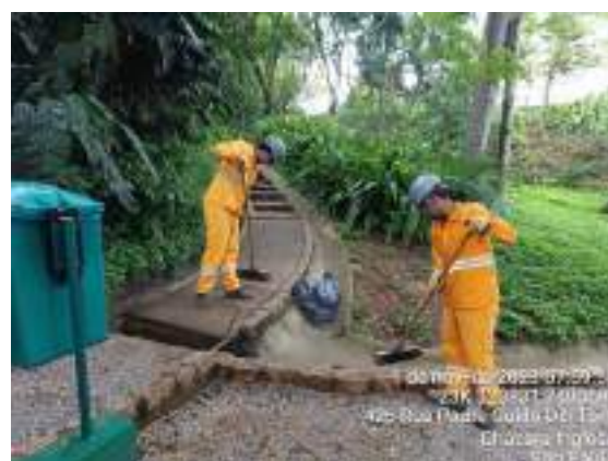
Figura 376 Limpeza de manutenção da escadaria e canaletas
