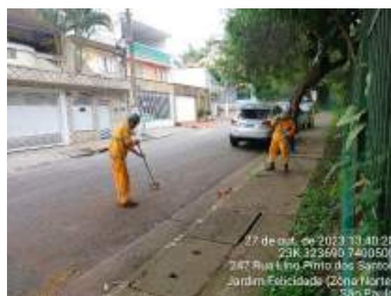
Figura 370 Limpeza de manutenção de áreas externas
