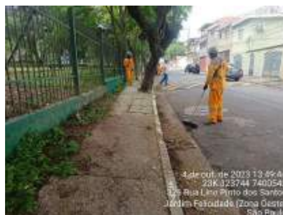
Figura 316 Limpeza de manutenção das calçadas externas - antes
