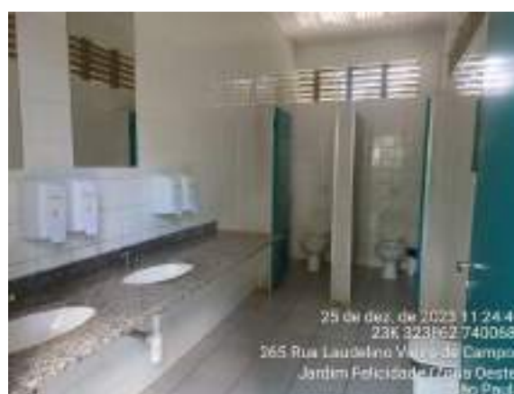
Figura 431 Higienização dos banheiros públicos
