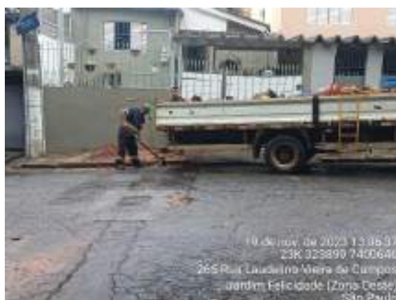
Figura 489 Manutenção e troca de encanamento com vazamentos em área externa - Calçada portaria 1 - SABESP
