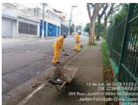
Figura 327 Limpeza de manutenção das calçadas externas
