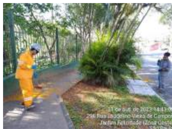
Figura 326 Limpeza de manutenção das calçadas externas
