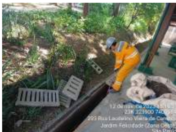
Figura 475 Manutenção de canaletas internas –Bocha – antes
