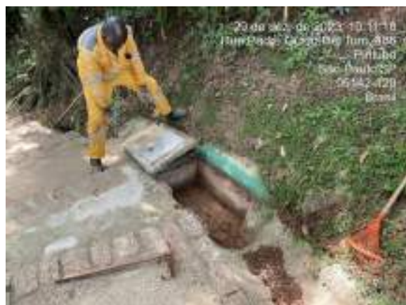
Figura 246 Limpeza de manutenção das caixas hidráulicas e canaletas – Escada para o lago
