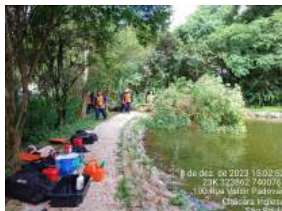
Figura 273 Supressão de arvore com risco de queda proximo a praça central
