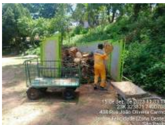
Figura 270 Manejo de resíduos excedentes para caçamba de áreas verdes
