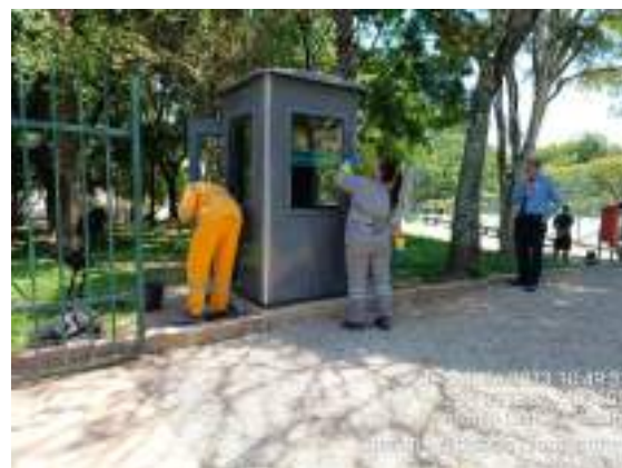
Figura 368 Limpeza de manutenção da guarita de segurança – Portaria 2
