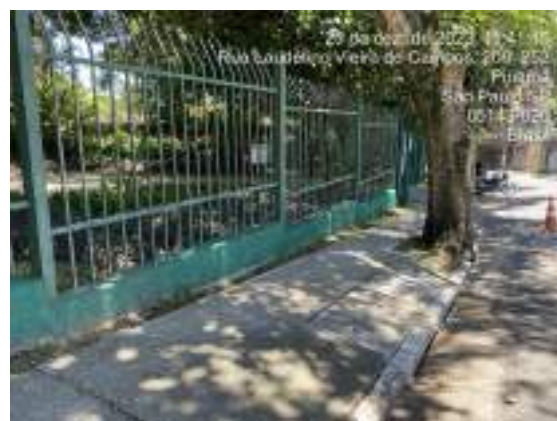
Figura 199 Roçagem das calçadas externas - depois
