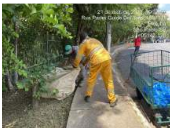
Figura 200 Limpeza de manutenção das calçadas externas
