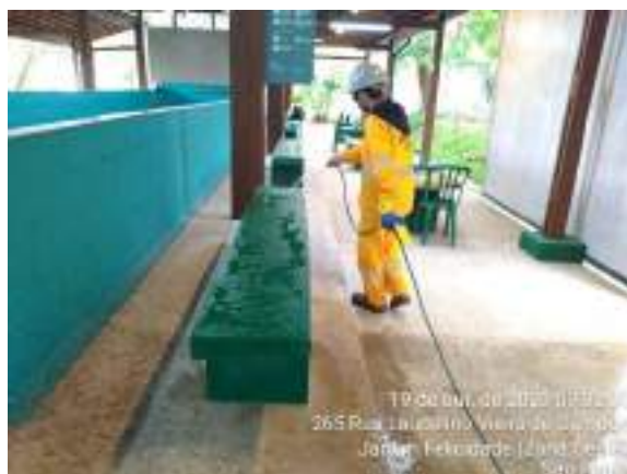
Figura 339 Limpeza de manutenção da área externa da bocha
