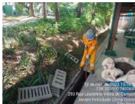
Figura 476 Manutenção de canaletas internas –Bocha – depois
