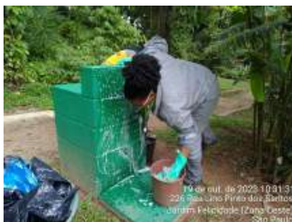
Figura 341 Higienização do bebedouro - Trilha do parque - antes
