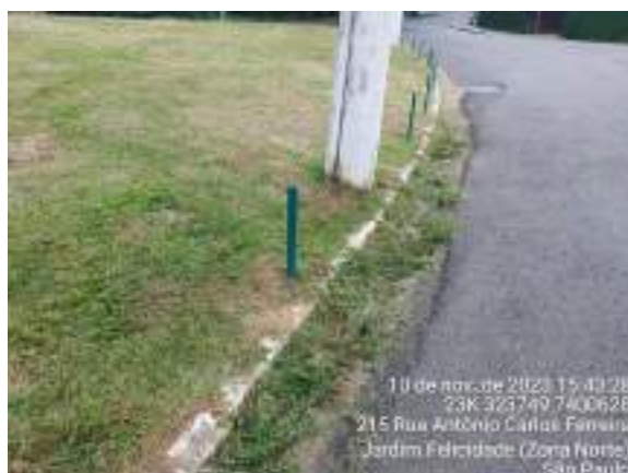
Figura 473 Manutenção de canaletas externas – Praça central – antes
