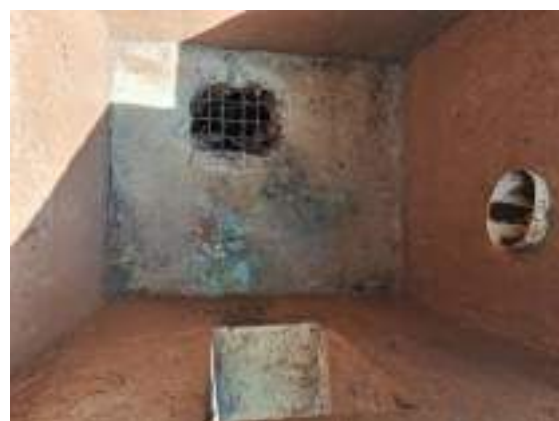
Figura 478 Manutenção de caixas hidráulicas e canaletas internas – Parquinho - depois
