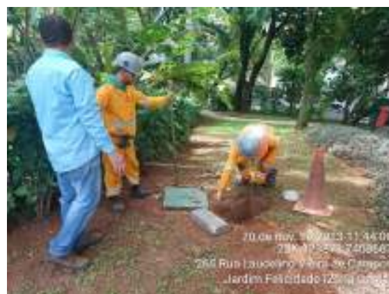
Figura 494 Manutenção e reparo de encanamento com vazamentos em área interna - Administração - URBIA
