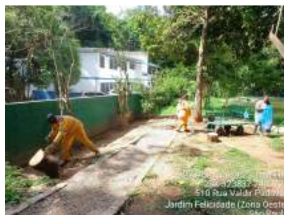
Figura 271 Manejo de resíduos excedentes para caçamba de áreas verdes
