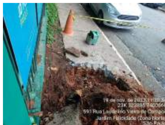
Figura 490 Manutenção e troca de encanamento com vazamentos em área externa - Calçada portaria 1 - SABESP
