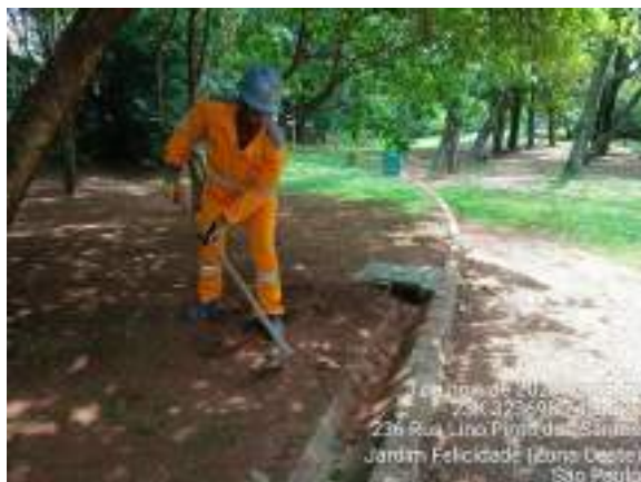
Figura 124 Limpeza de canaletas e caixas hidráulicas – Trilha do parquinho
