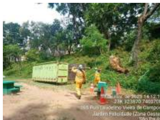
Figura 267 Manejo de resíduos excedentes para caçamba de áreas verdes
