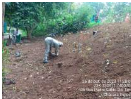
Figura 113 Plantio de recomposição do talude - Churrascaria/lago - durante
