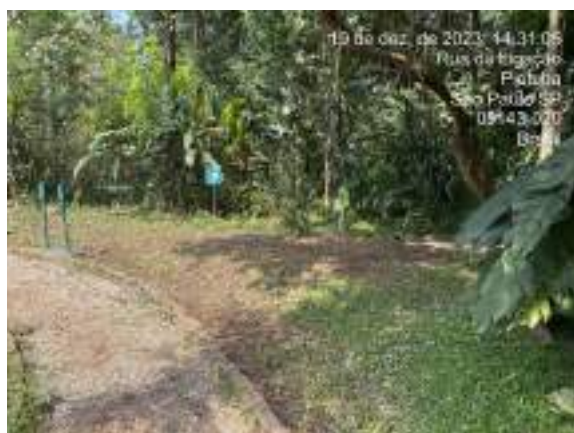
Figura 278 Manejo de resíduos e limpeza do canteiro – lago/praça anexa – depois
