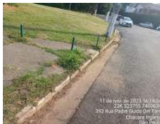
Figura 474 Manutenção de canaletas externas – Praça central – depois
