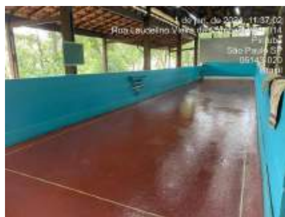
Figura 467 Lavagem e enceramento da cancha de bocha
