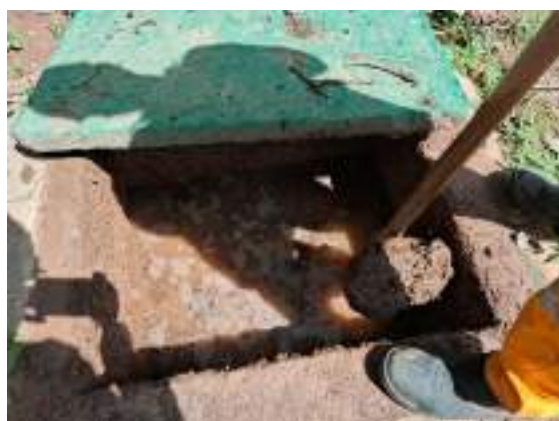
Figura 477 Manutenção de caixas hidráulicas e canaletas internas – Parquinho - antes
