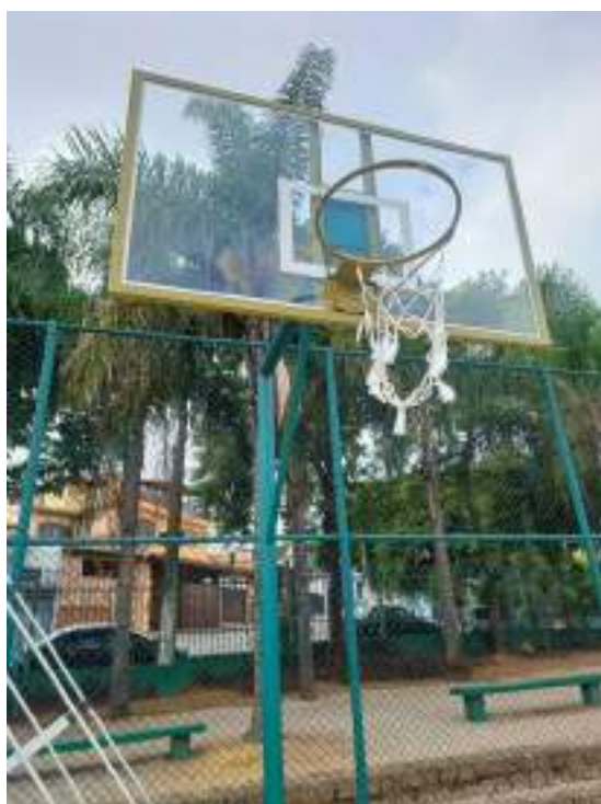
Figura 501 Troca de redes danificadas na tabela de basquete - antes
