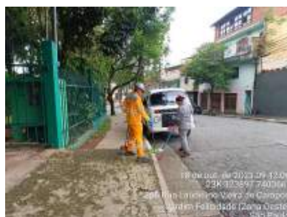
Figura 336 Limpeza de manutenção das calçadas externas
