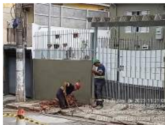
Figura 490 Manutenção e troca de encanamento com vazamentos em área externa - Calçada portaria 1 - SABESP
