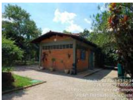
Figura 418 Limpeza de manutenção das calçadas internas - Administração
