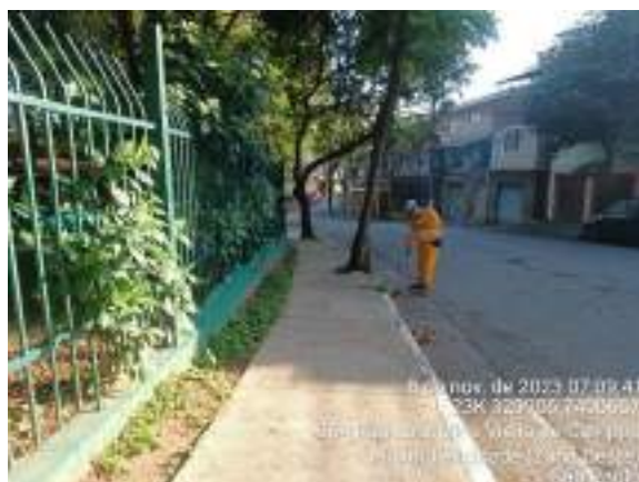
Figura 385 Limpeza de manutenção das calçadas externas
