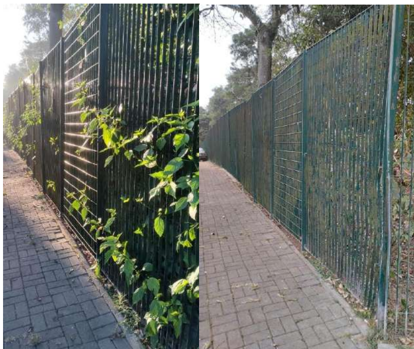
Figura 14: Limpeza e despraguejamento malvaviscos gradil, antes.
