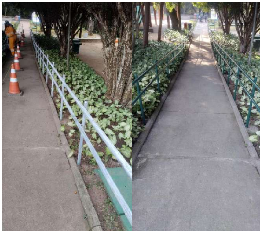
Figura 49: Instalação e pintura corrimãos rampa de acesso, antes.
