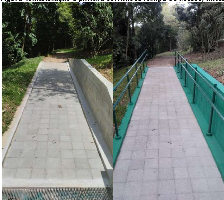
Figura 49: Instalação e pintura corrimãos rampa de acesso, antes.
