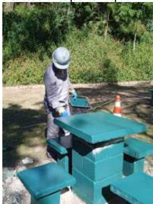
Figura 137:Reparo de mesas e bancos na área das churrasqueiras – depois
