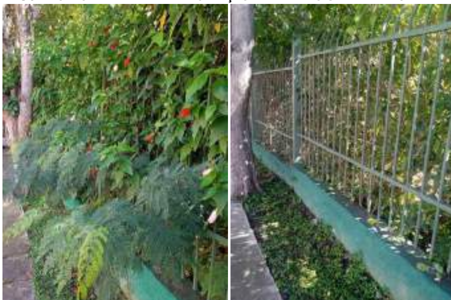
FIGURA 56 – PODAS DE LIMPEZA E MANUTENÇÃO EXTERNA AO GRADIL EM TODA EXTENSÃO
