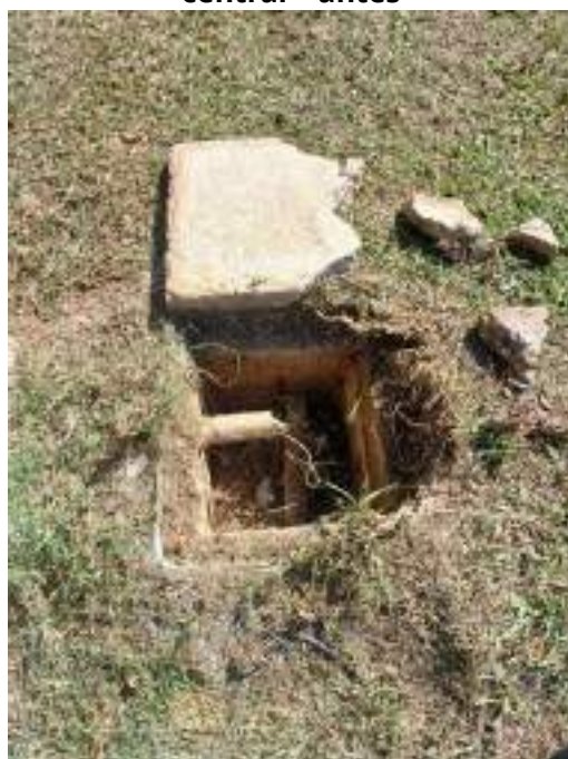
Figura 142:Substituição de tampa de alvenaria para caixa elétrica na praça central - antes
