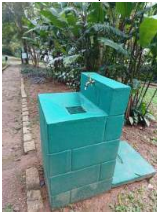
Figura 119:Reposição de torneira no bebedouro da trilha - depois
