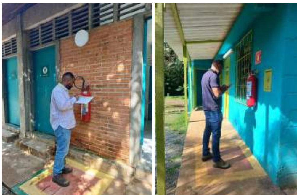
FIGURA 90 – VISTORIA DE EQUIPAMENTOS POR TÉCNICOS DE SEGURANÇA DO TRABALHO URBIA
