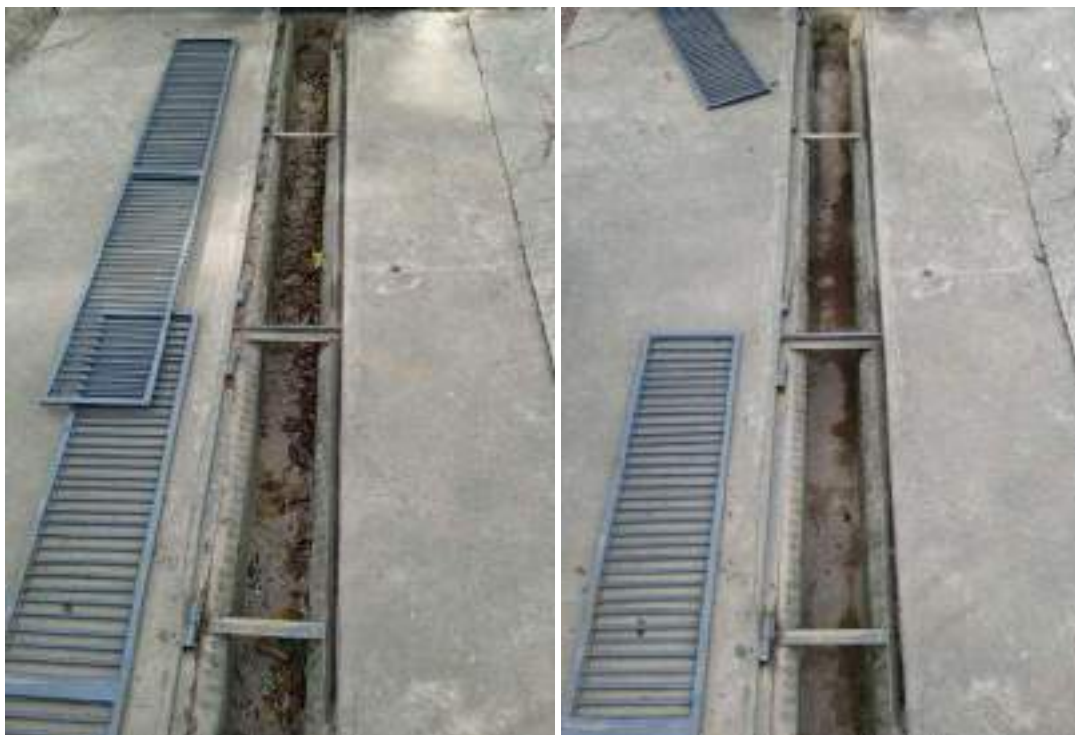
FIGURA 103 - MANUTENÇÃO DAS CANALETAS PRÓXIMAS AS PORTARIAS
