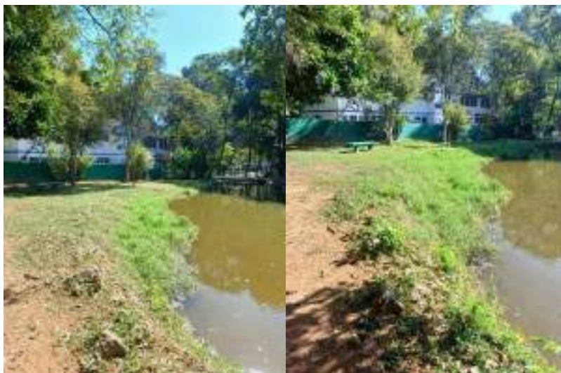
FIGURA 42 - ROÇAGEM DA ÁREA DO LAGO - ANTES E DEPOIS
