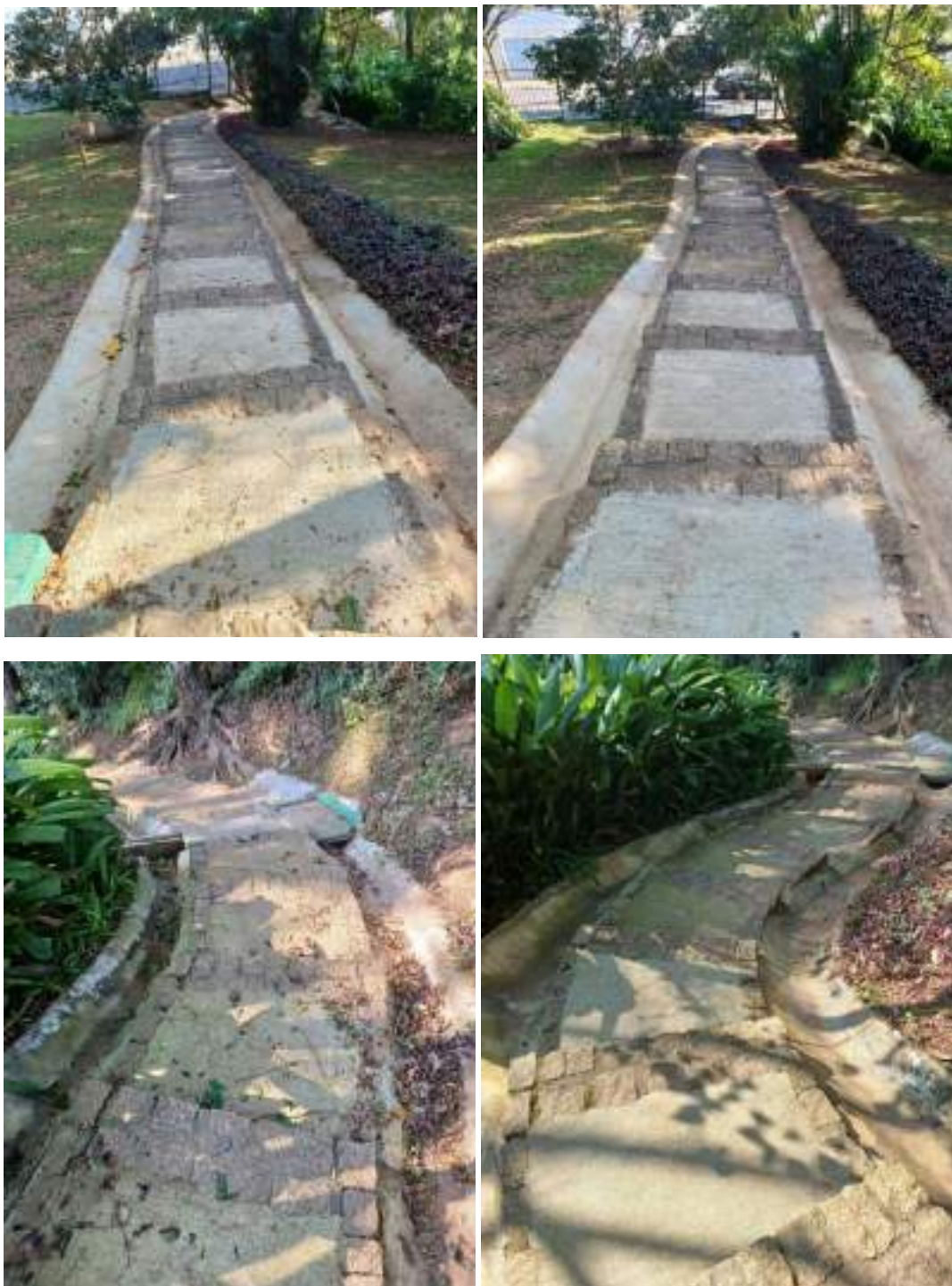
FIGURA 100 – MANUTENÇÃO DAS CANALETAS DA ESCADA PARA O LAGO
