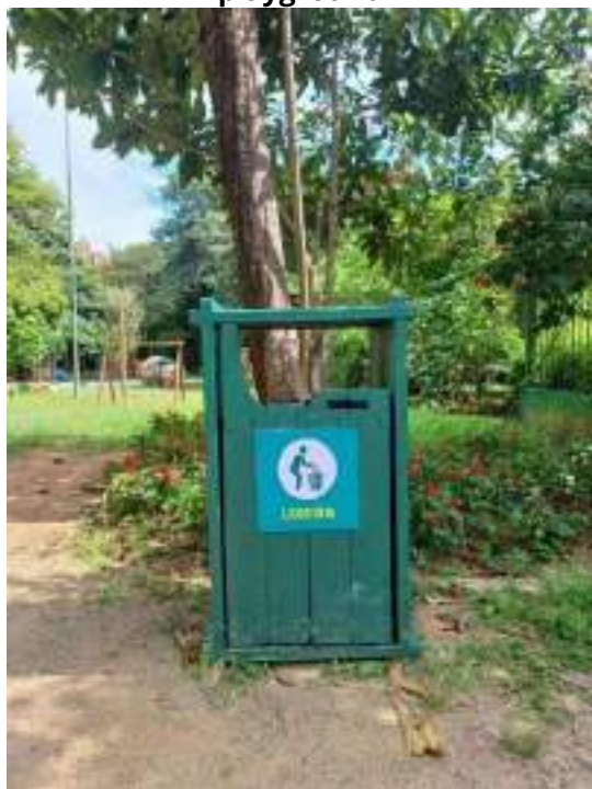
Figura 128: Instalação de placas informativas: Identificação de lixeira - playground
