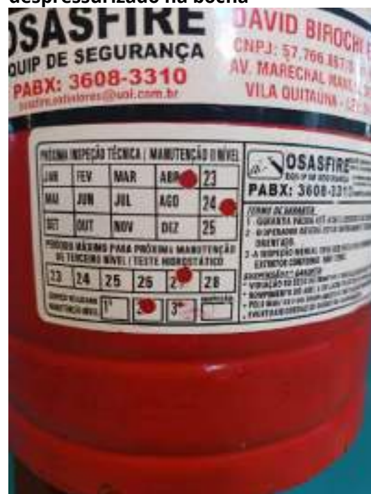
Figura 135: Substituição de extintor despressurizado na bocha
