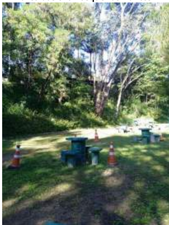
Figura 138:Reparo de mesas e bancos na área das churrasqueiras – antes
