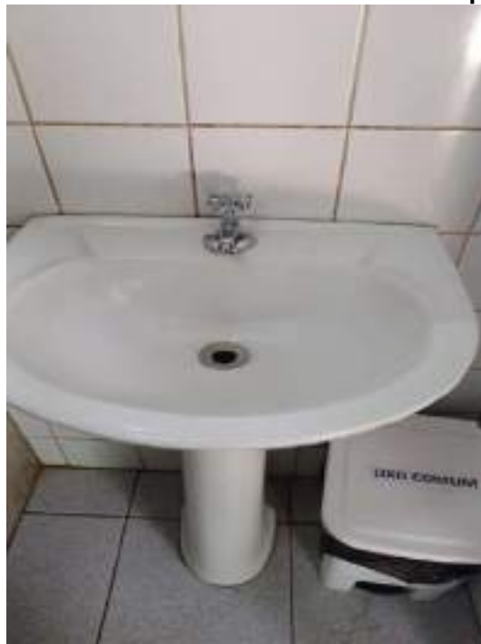
Figura 117:Reposição de torneira e troca do flexível no banheiro masculino - depois
