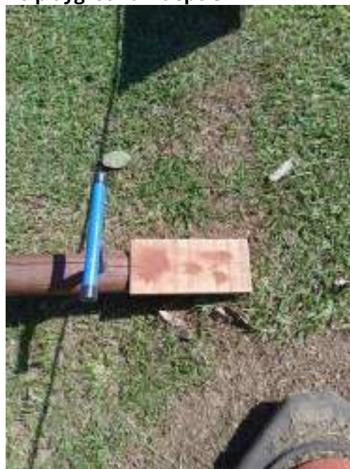
Figura 141:Reparo do banco da gangorra no playground - depois
