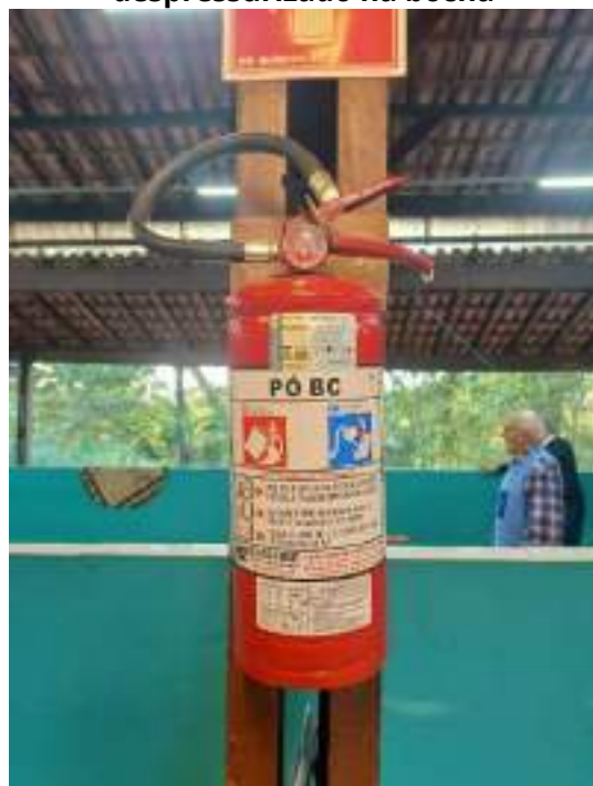
Figura 134: Substituição de extintor despressurizado na bocha
