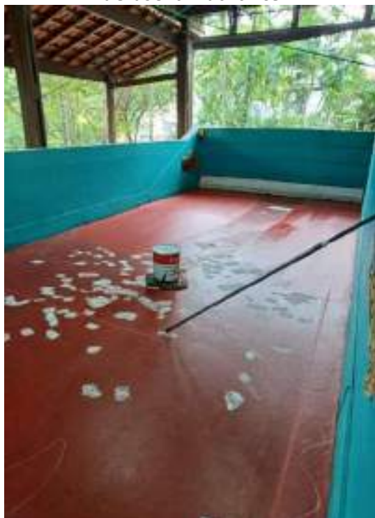
Figura 112: Manutenção do piso da cancha de bocha - durante
