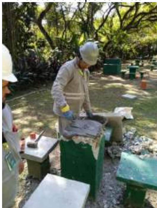
Figura 136:Reparo de mesas e bancos na área das churrasqueiras – antes
