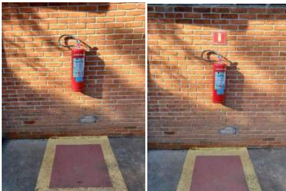
FIGURA 92 – SUBSTITUIÇÃO DE EXTINTOR DESPRESSURIZADO NA BOCHA
