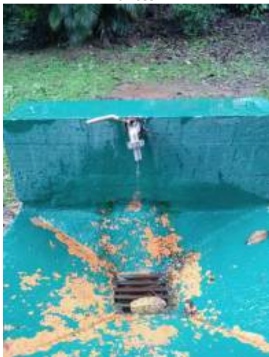
Figura 120:Substituição de torneira sem reparo no bebedouro do playground - antes
