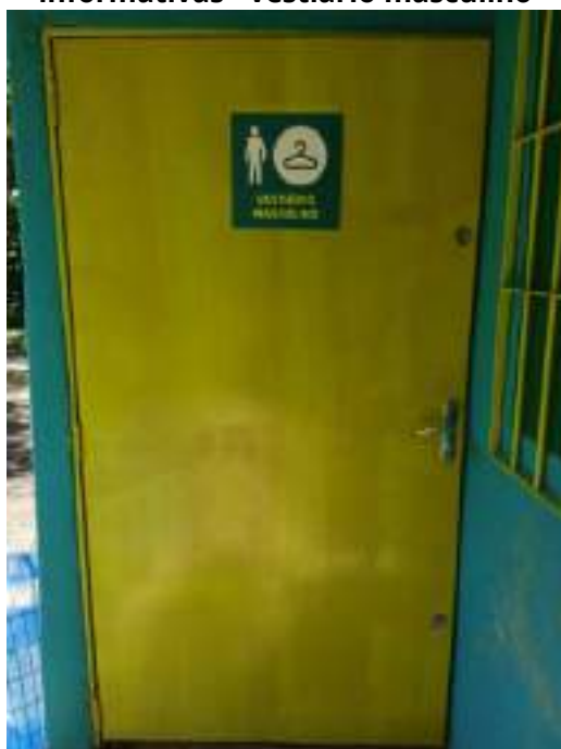
Figura 122:Instalação de placas informativas - vestiário masculino
