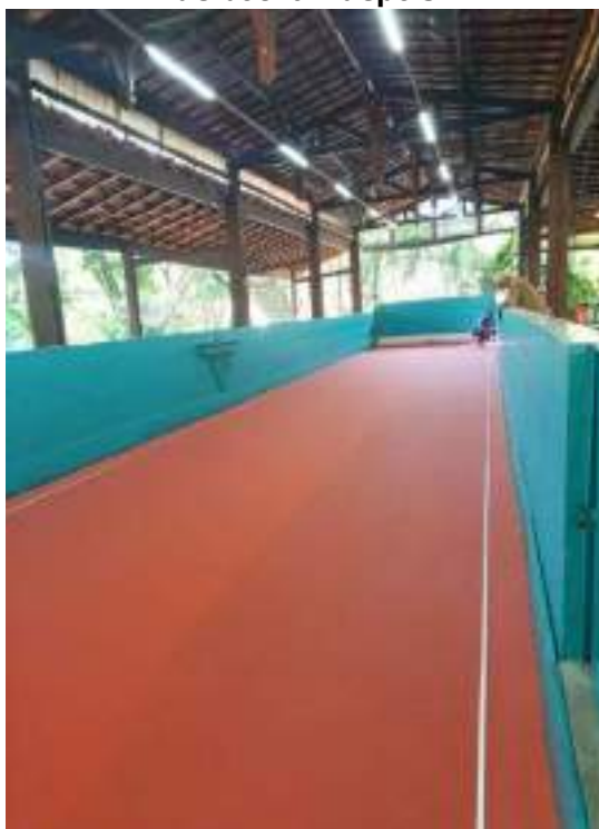
Figura 114: Manutenção do piso da cancha de bocha - depois
