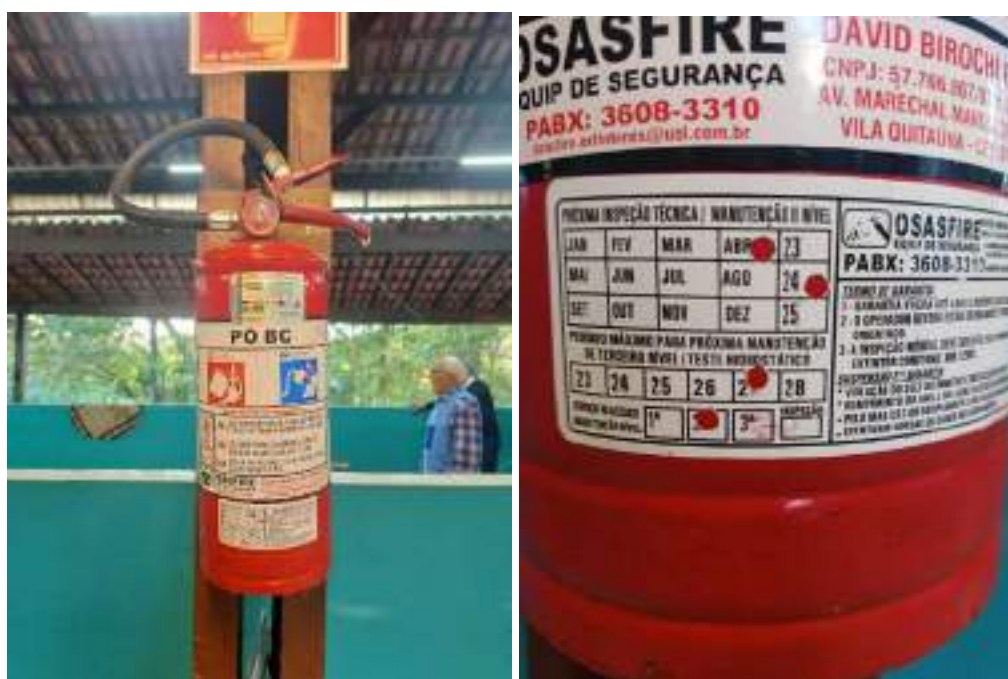
FIGURA 92 – SUBSTITUIÇÃO DE EXTINTOR DESPRESSURIZADO NA BOCHA
