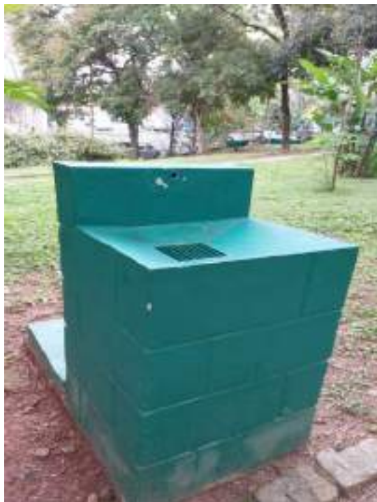
Figura 118:Reposição de torneira no bebedouro da trilha - antes
