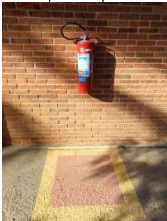
Figura 132: Instalação de placas indicativas para extintor próximo ao depósito - antes
