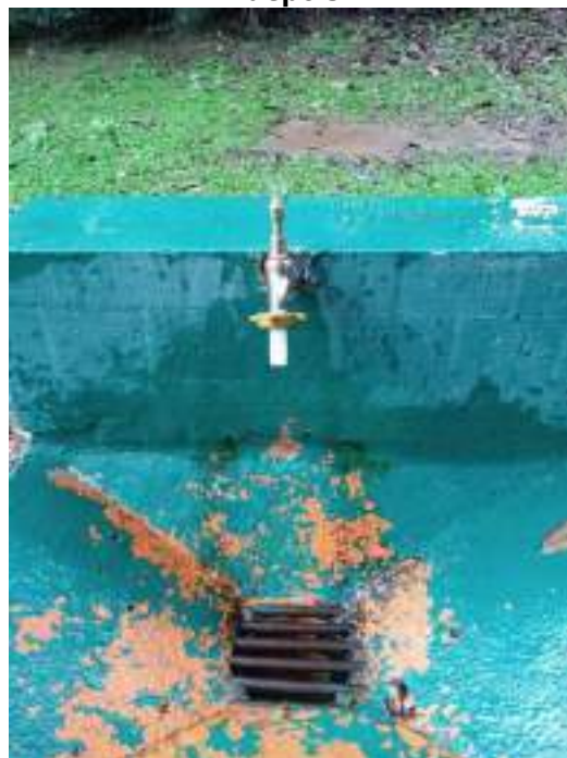
Figura 121:Substituição de torneira sem reparo no bebedouro do playground- depois
