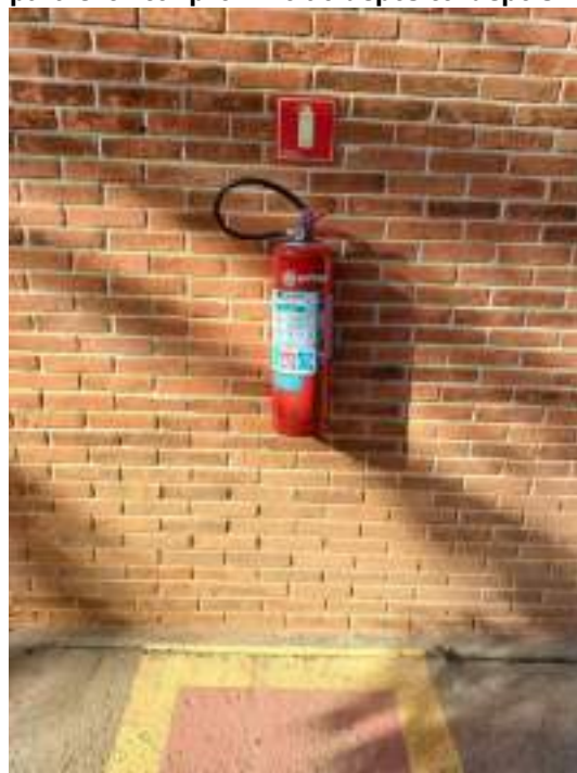
Figura 133: Instalação de placas indicativas para extintor próximo ao depósito - depois
