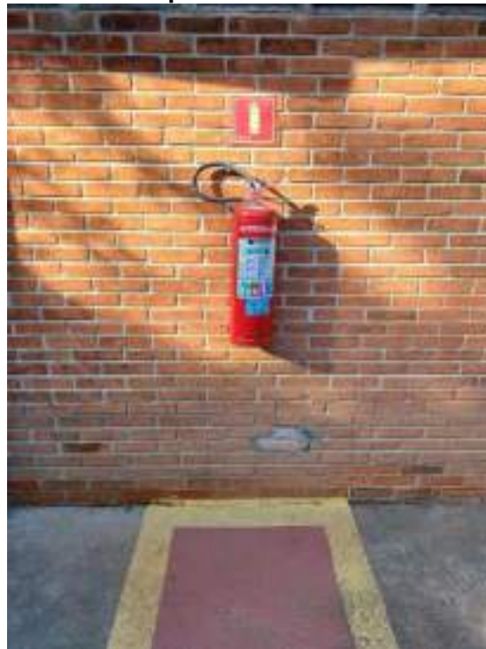
Figura 131: Instalação de placas indicativas para extintor próximo ao banheiro - depois
