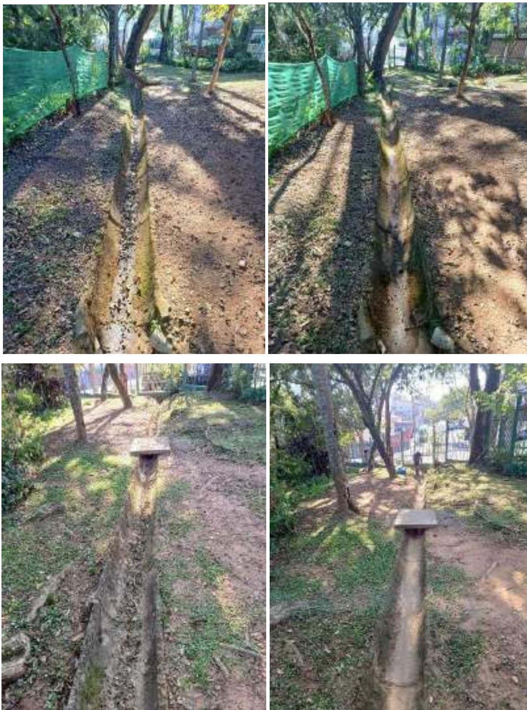
FIGURA 102 – MANUTENÇÃO DAS CANALETAS PRÓXIMAS A BOCHA – ANTES E DEPOIS
