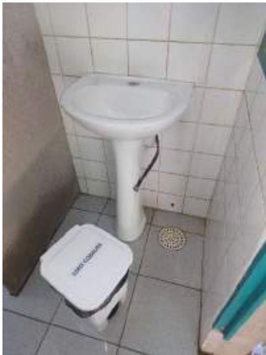
Figura 116:Reposição de torneira e troca do flexível no banheiro masculino - antes
