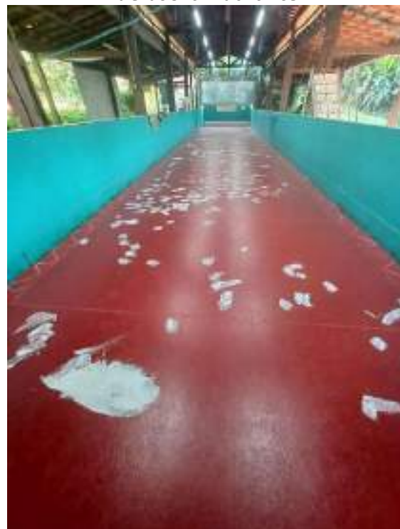
Figura 113: Manutenção do piso da cancha de bocha - durante
