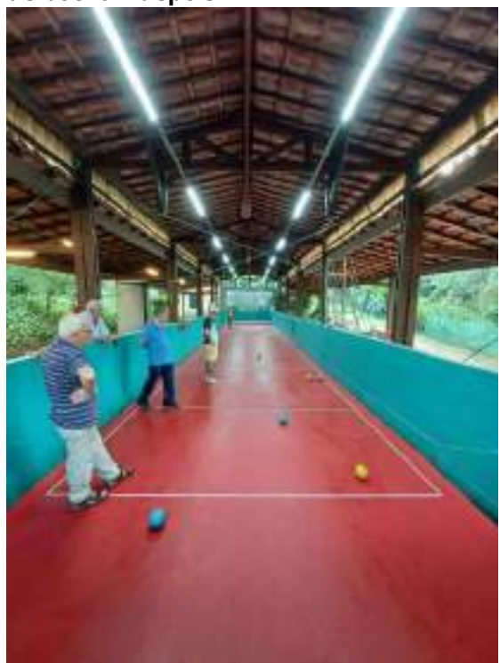
Figura 115: Manutenção do piso da cancha de bocha - depois
