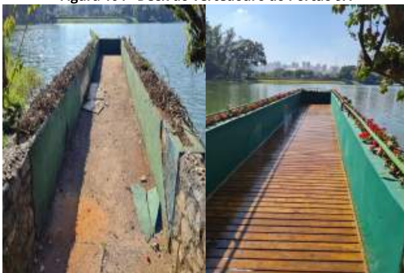
Figura 104 - Deck do vertedouro do Portão 9A
