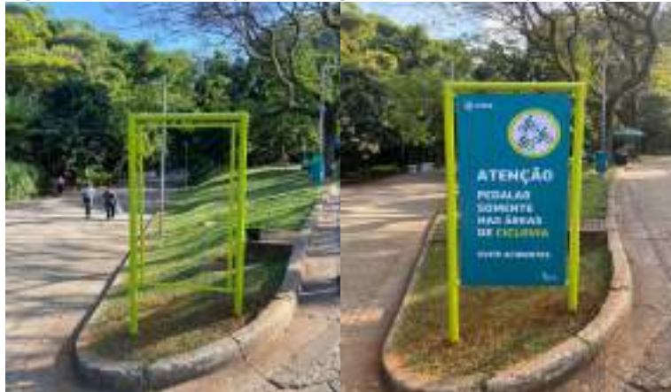
Figura 115 - Fabricação de suportes e instalação de placas
