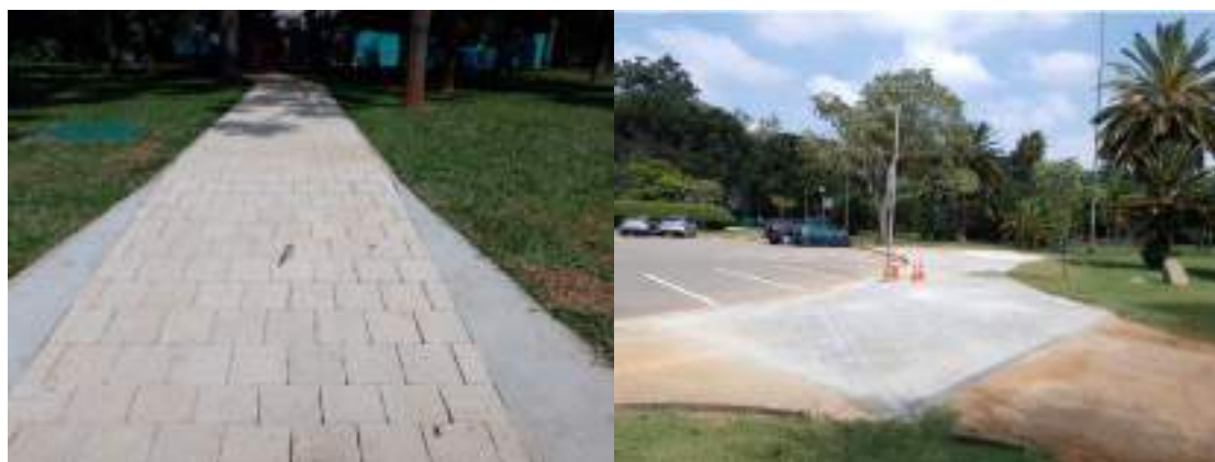
Figura 90: Adequação de acessibilidade e recuperação de calçadas.
