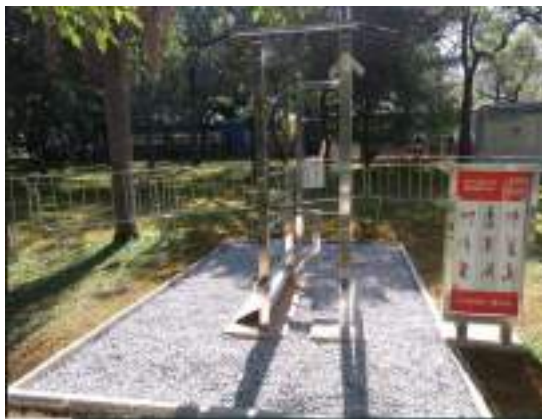
Figura 87: Execução de base para os equipamentos de ginástica.
