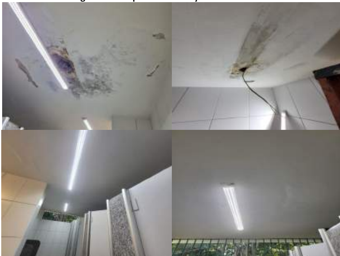
Figura 110 - Reparo de infiltração no banheiro 06
