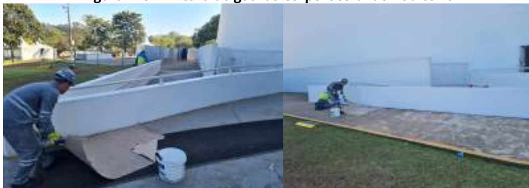
Figura 118 - Pintura do guarda corpo lateral do Auditório
