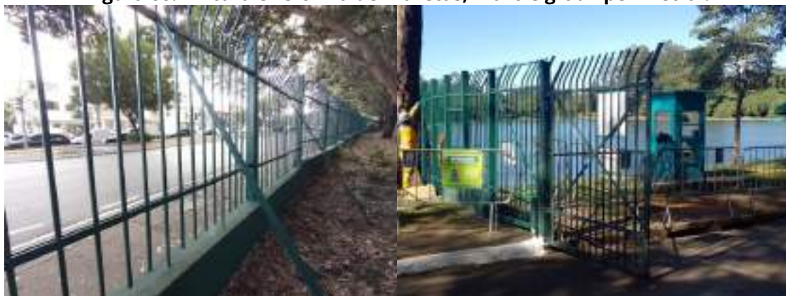
Figura 88: Pintura e reforma de muretas, muro e gradil perimetral.
