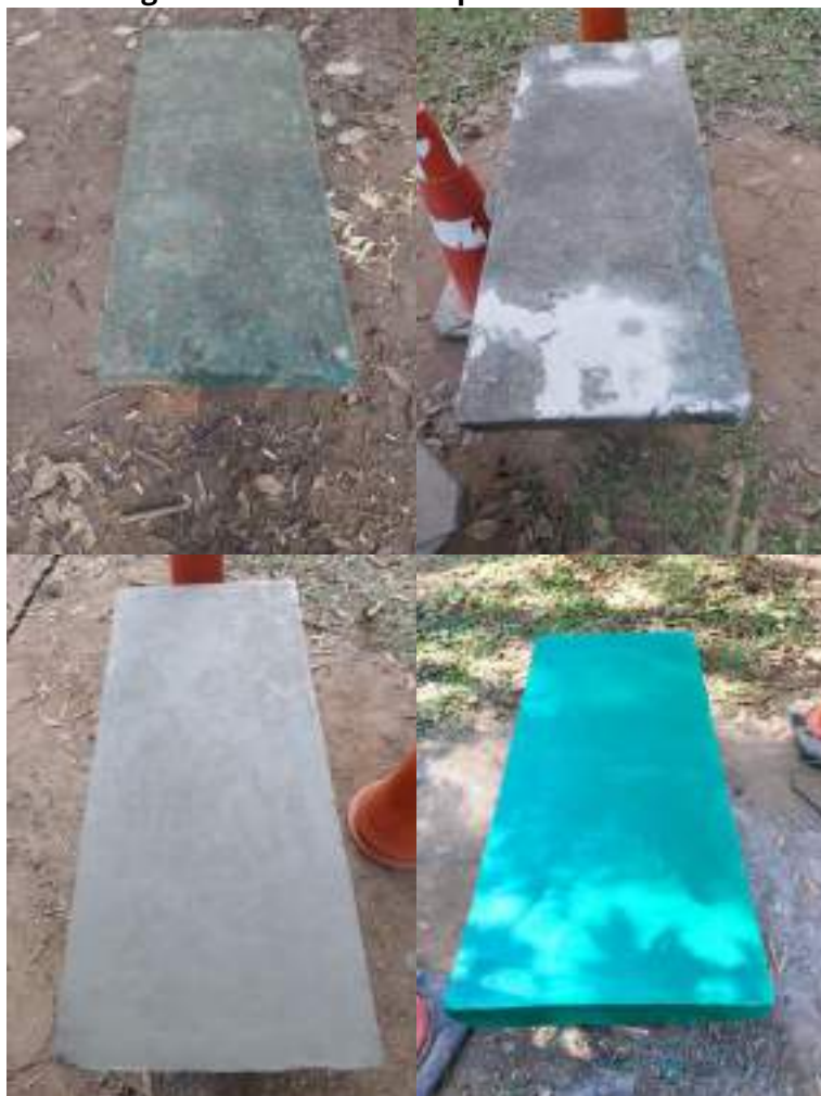
Figura 101 - Restauro e pintura de bancos
