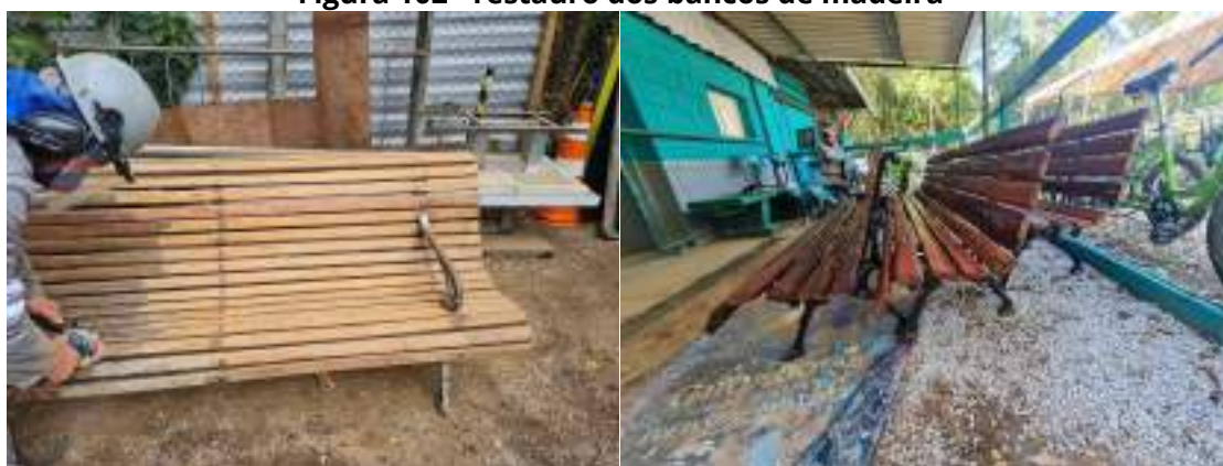
Figura 102 - restauro dos bancos de madeira
