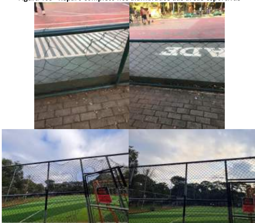
Figura 108 - Reparo completo nos alambrados das áreas esportivas
