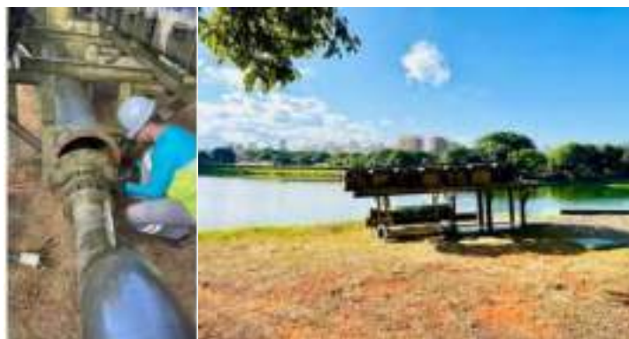
Figura 96 - Substituição de bombas na Fonte Multimídia.
