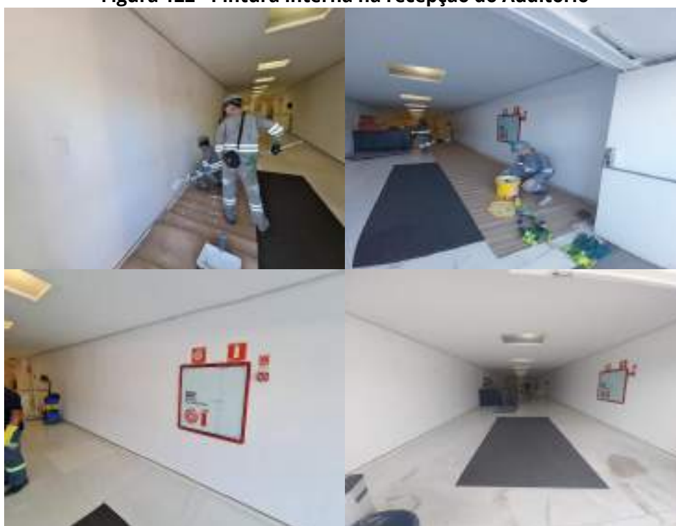
Figura 122 - Pintura interna na recepção do Auditório
