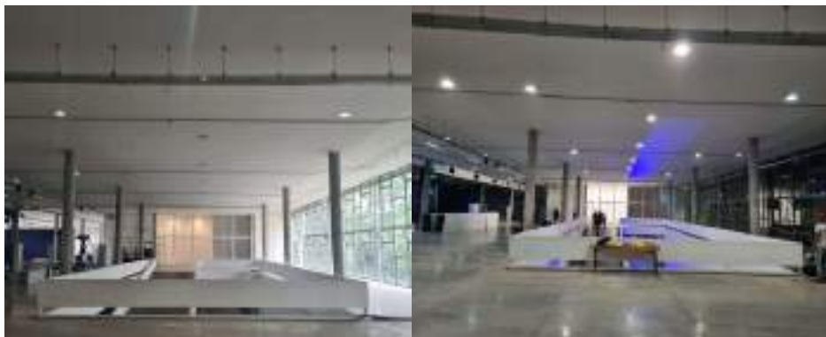
Figura 95 - Realizado a substituição de 140 lâmpadas no Pacubra.
