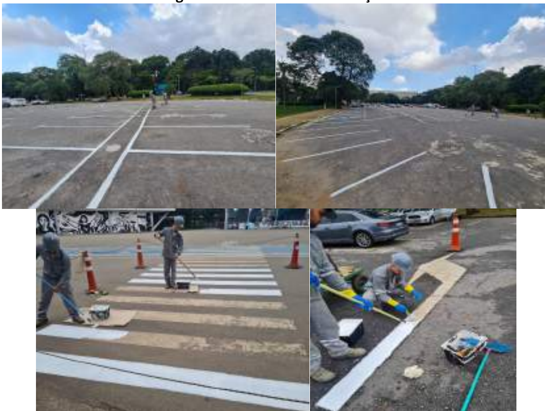
Figura 109 - Pintura de sinalização
