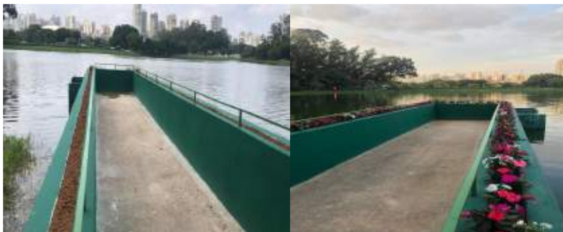
Figura 57 – Revitalização das Jardineiras Vertedouro
