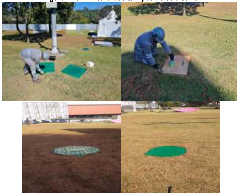
Figura 120 - Pintura das tampas do auditório
