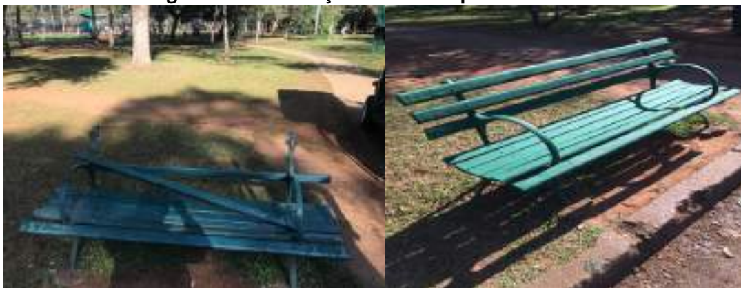
Figura 112 - Instalação de novas ripas nos bancos
