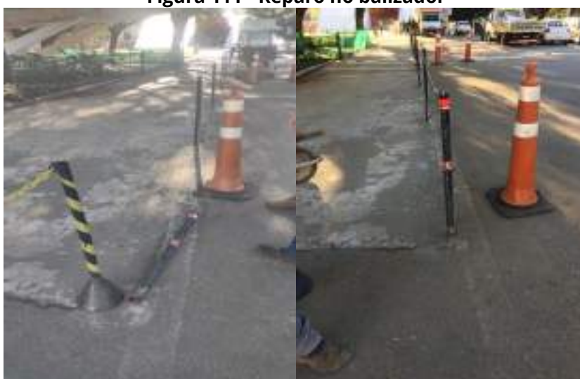
Figura 111 - Reparo no balizador
