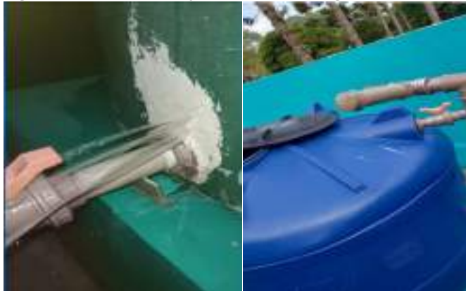
Figura 97 - Substituição de caixa d'água danificada.
