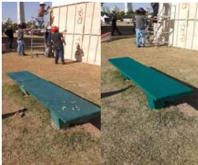
Figura 117 - Pintura dos bancos na área externa do auditório
