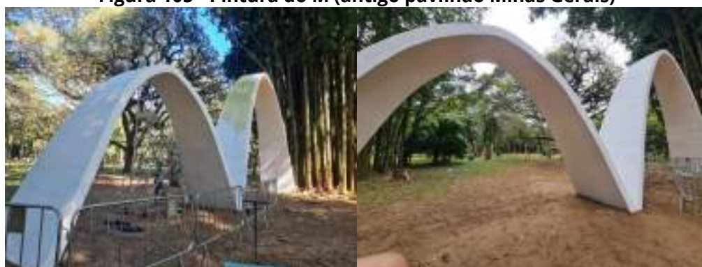
Figura 105 - Pintura do M (antigo pavilhão Minas Gerais)
