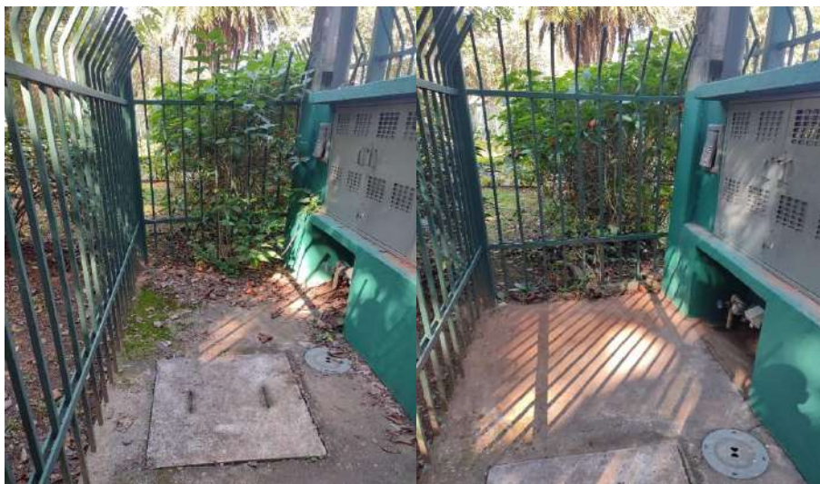
Figura 19 - Limpeza caixa de luz
