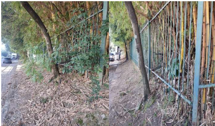
Figura 21 - Limpeza de gradil
