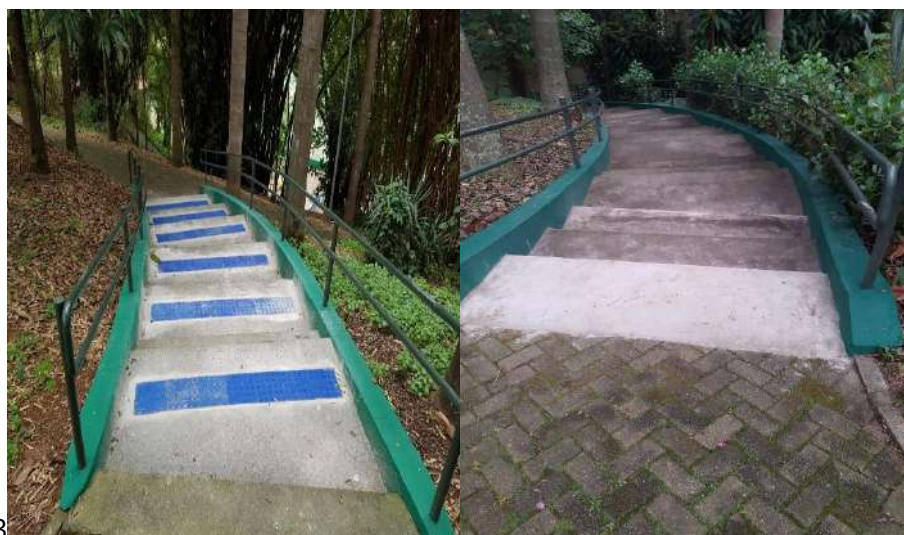
Figura 28 - Pintura e colocação piso tátil
