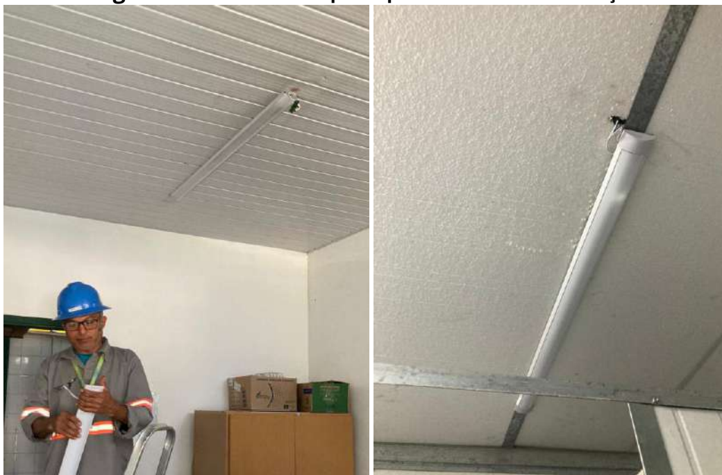
Figura 56- Troca de lâmpada queimada da administração
