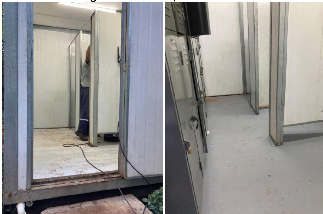
Figura 61- Troca do piso do container
