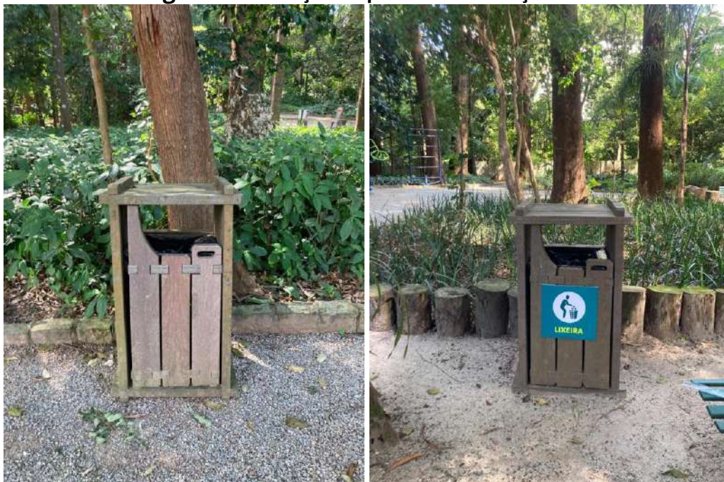
Figura 69– Fixação de placa de sinalização lixo
