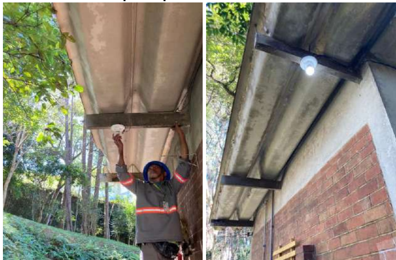
Figura 55- Troca de lâmpada queimada da área externa da administração
