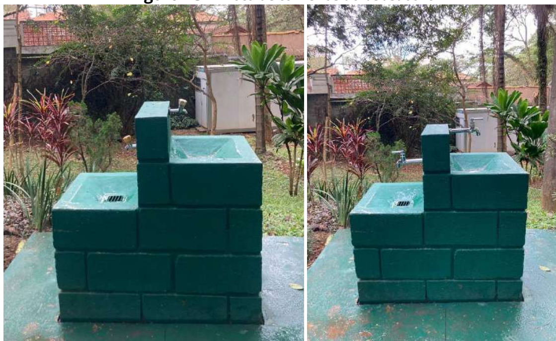
Figura 73 – Troca de torneiras do bebedouro
