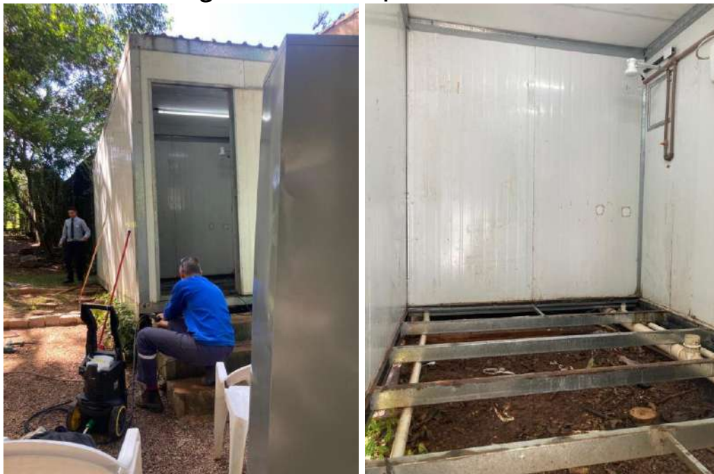
Figura 60- Troca do piso do container
