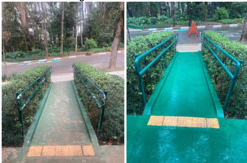
Figura 63- Pintura do corrimão
