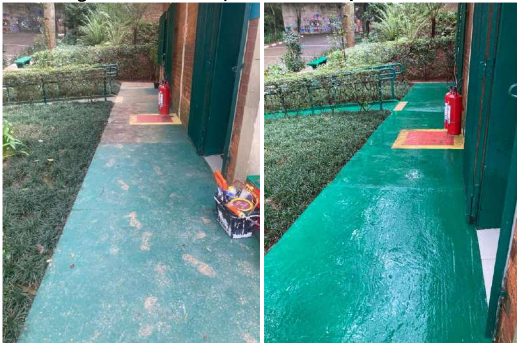
Figura 64– Pintura do piso da administração área externa
