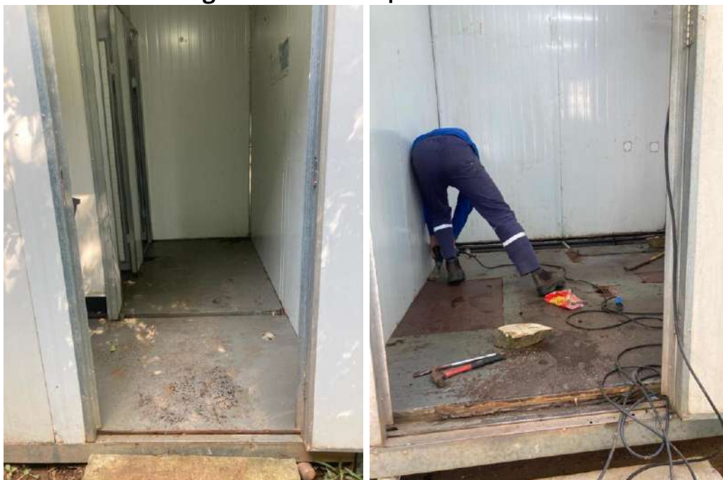
Figura 59- Troca do piso do container
