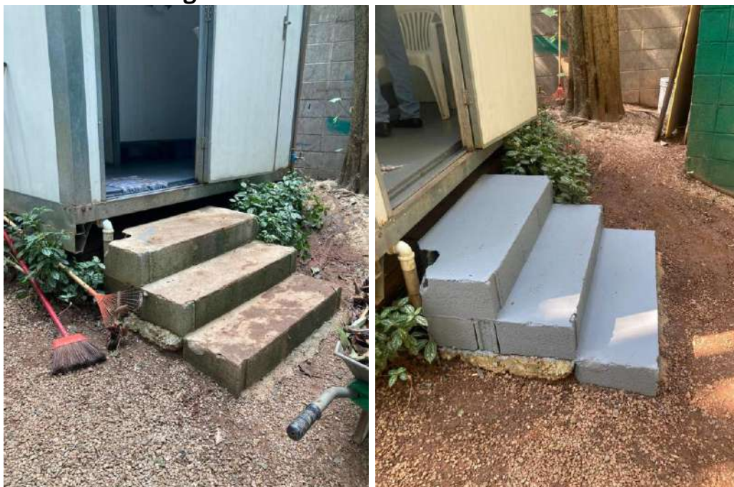
Figura 65– Pintura da escada do container
