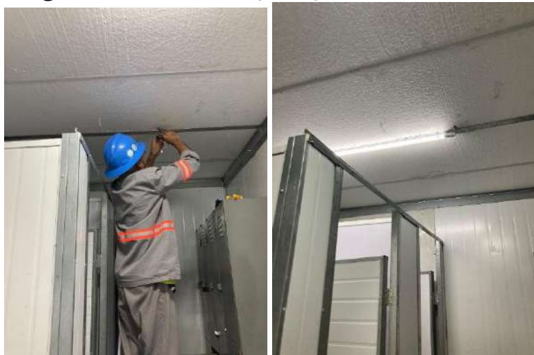
Figura 54- Troca de lâmpada queimada do container
