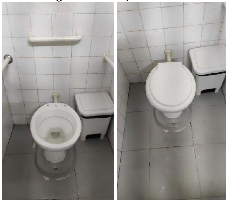
Figura 66- Instalação do assento
