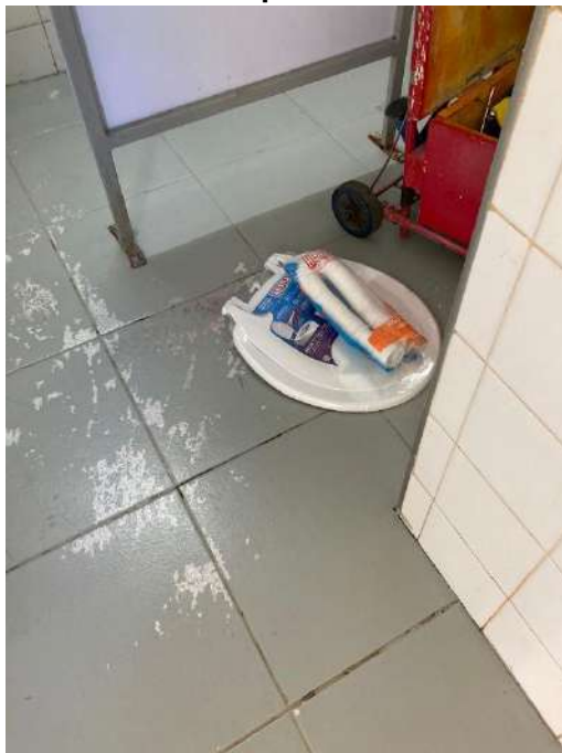
Figura 74 – Troca do spud do sanitario masculino
