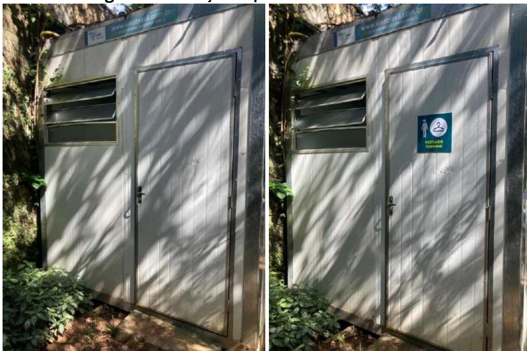
Figura 68– Fixação de placa informativa container
