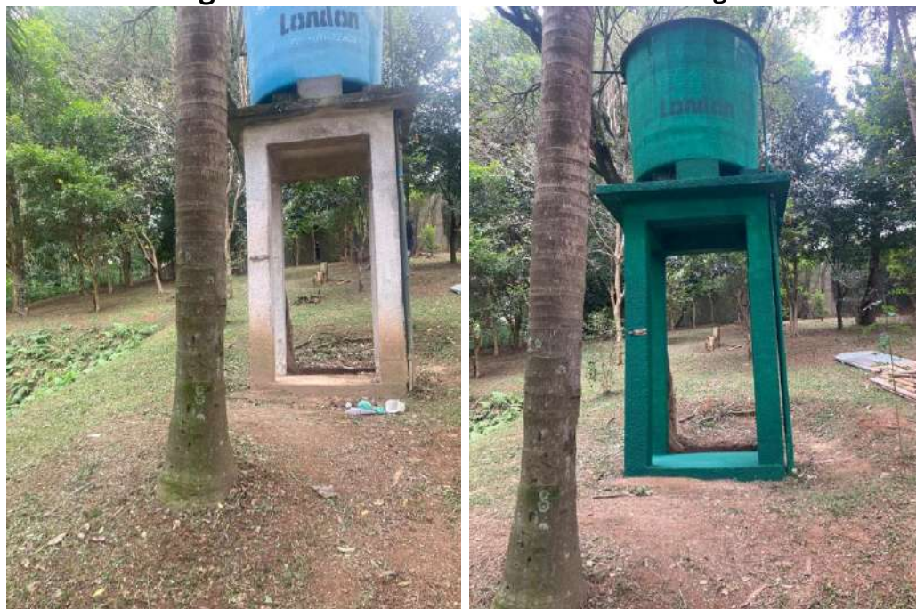
Figura 62- Pintura da estrutura da caixa d'água
