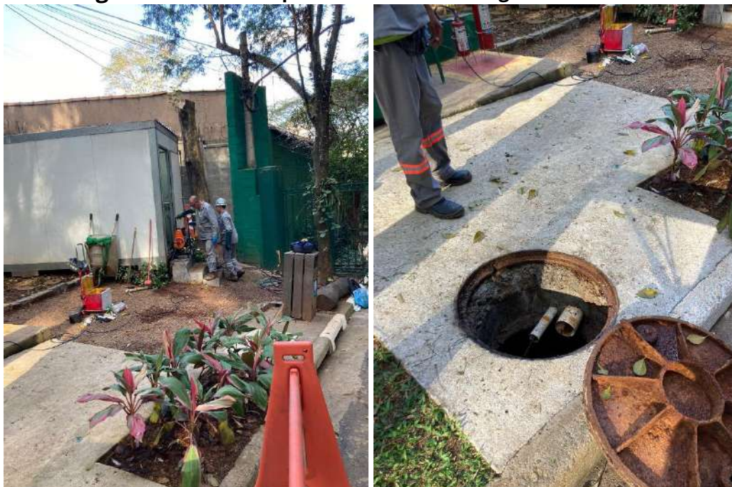
Figura 76 – Desentupimento da caixa de esgoto do container
