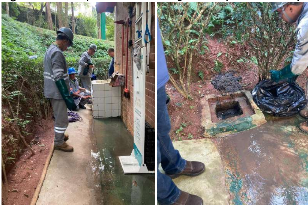
Figura 77– Desentupimento da caixa de esgoto do tanque da administração
