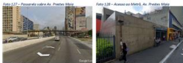
Foto 127 – Passarela sobre Av. Prestes Maia
