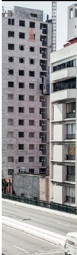
André Czitrom, na entrada elevada do prédio popular na Vila Buarque: plano de fazer dezoito condomínios do tipo nos bairros centrais. Na foto maior, a obra do conjunto para baixa renda projetado por Isay Weinfeld, no Minhocão: cantos arredondados e área comum na cobertura
