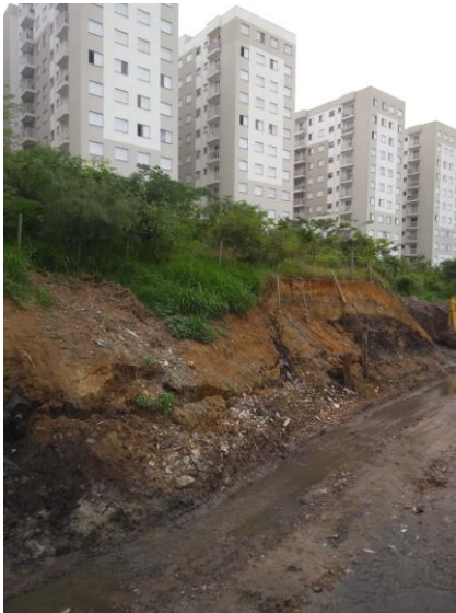
Foto do local – antes da intervenção
