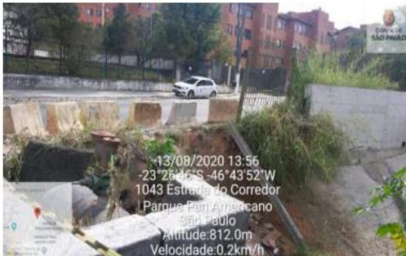
Foto do local – antes da intervenção
