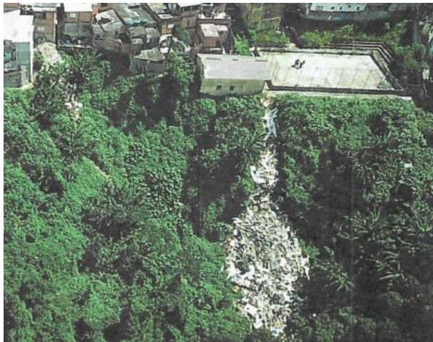
Foto do local – antes da intervenção
