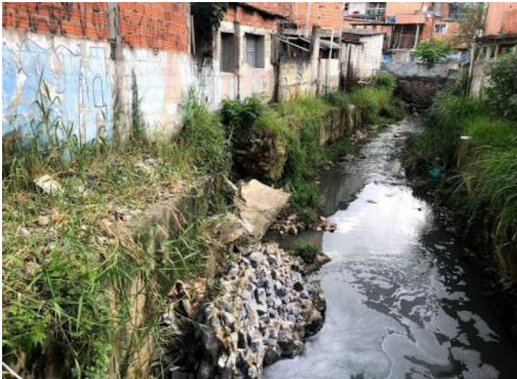
Foto do local – antes da intervenção
