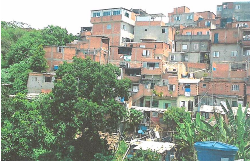
Foto do local – antes da intervenção
