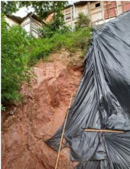
Foto do local – antes da intervenção
