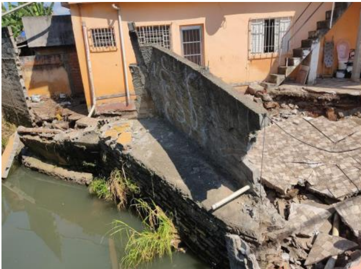
Foto do local – antes da intervenção
