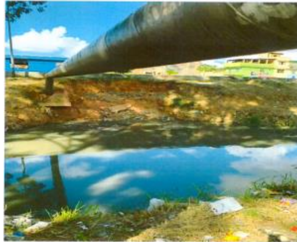
ADUTORA DE AGUA, AV. JACÚ-PÊSSEGO
