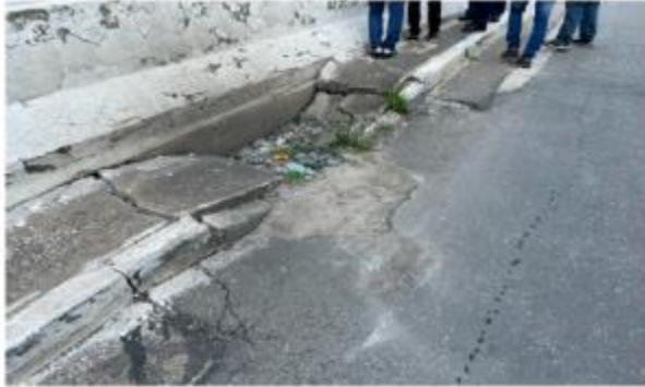
Afundamento na via
